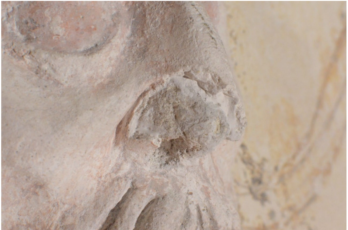
Obr. 129: Detail obličeje Boha Otce. Poškození nosu v podobě ztráty modelačního štku, ke kterému došlo ještě před nátěrem nejstarší druhotné vrstvy. Modelační štuk byl částečně podinjektován tak, aby v průběhu odkryvu nedocházelo k jeho ztrátám.
