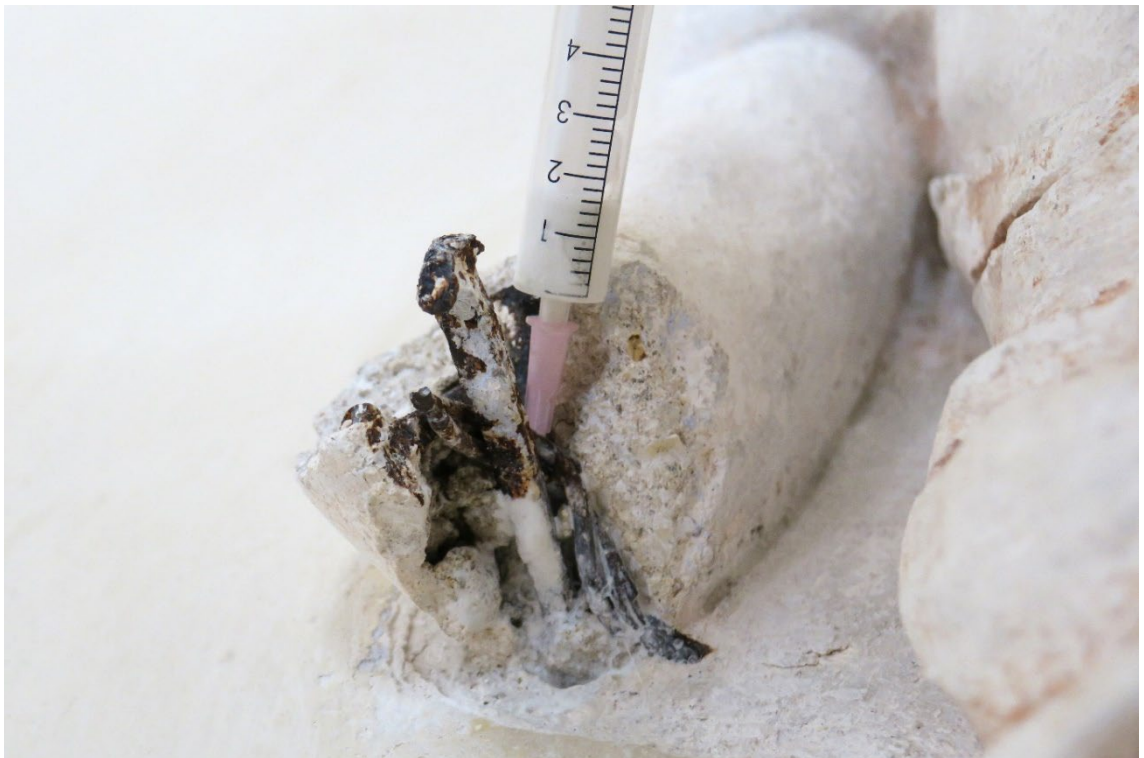
Obr. 143: Injektáž původních uvolněných armatur, které museli být upevněny zpět k renesančním štukům.
