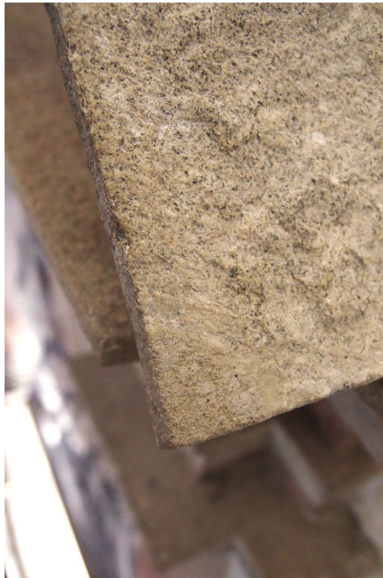
Obr. 151: Tmelení žulových částí.
