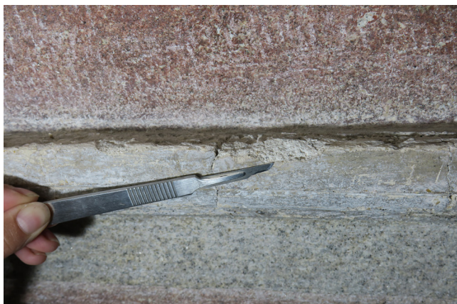
Obr. 12: Detail místa odběru vzorku V9 pro chemicko-technologický průzkum. Konec šály (pentle) Rosiny, tmel s vrstvami druhotných nátěrů.
