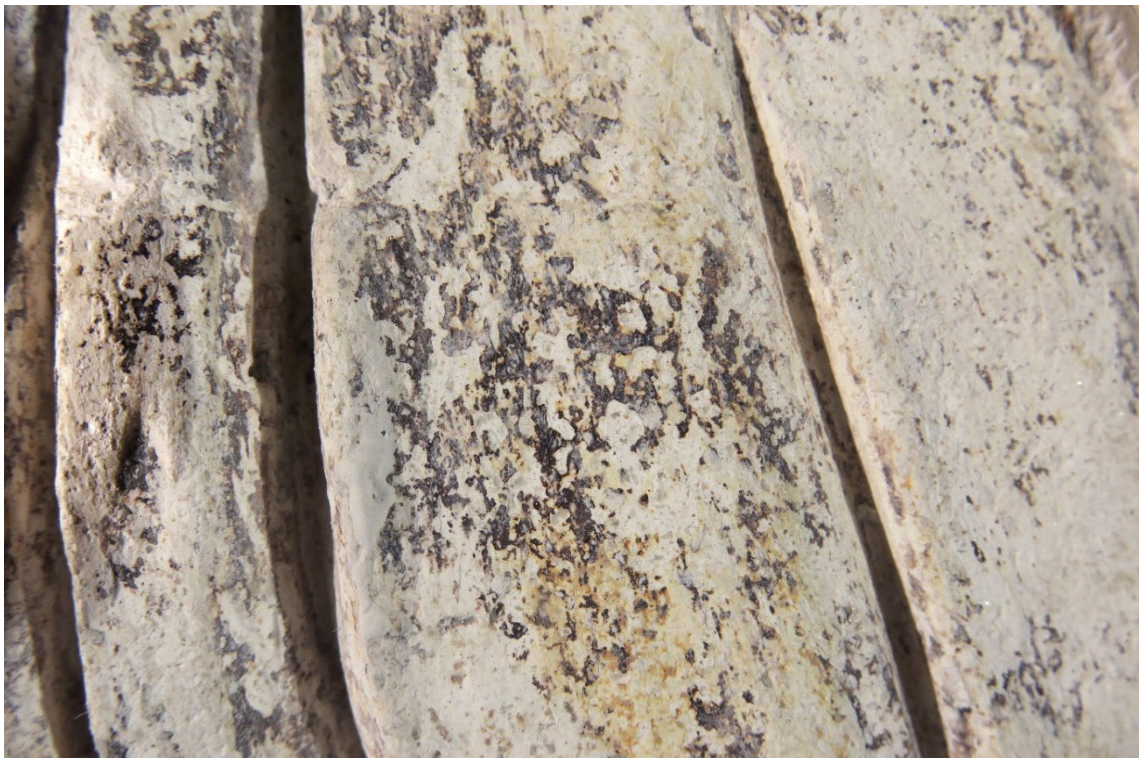
Obr. 130: Detail polychromie šatu Boha Otce s okrovou a hnědou barevností. Na fotografii je patrné poškození barevné vrstvy, která je zde dochována pouze lokálně.
