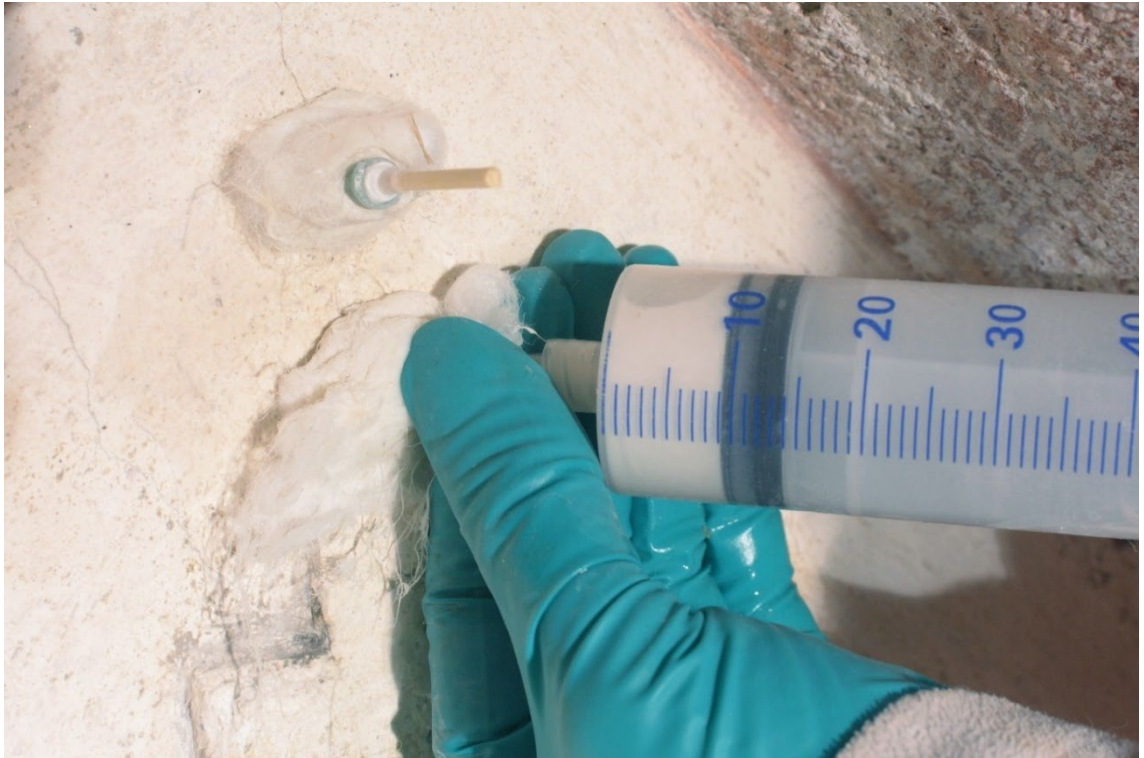
Obr. 142: Injektáž dutin na pozadí Boha Otce v tympanonu. Injektážní směs byla aplikována do předem připravených dutin pomocí injekční stříkačky.
