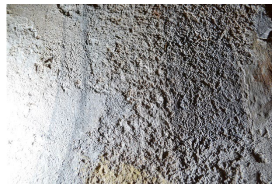
Obr. 64: Detail malovaného rámu v ostrém bočním nasvícení, kde lze pozorovat hrubou strukturu podkladové omítky.
