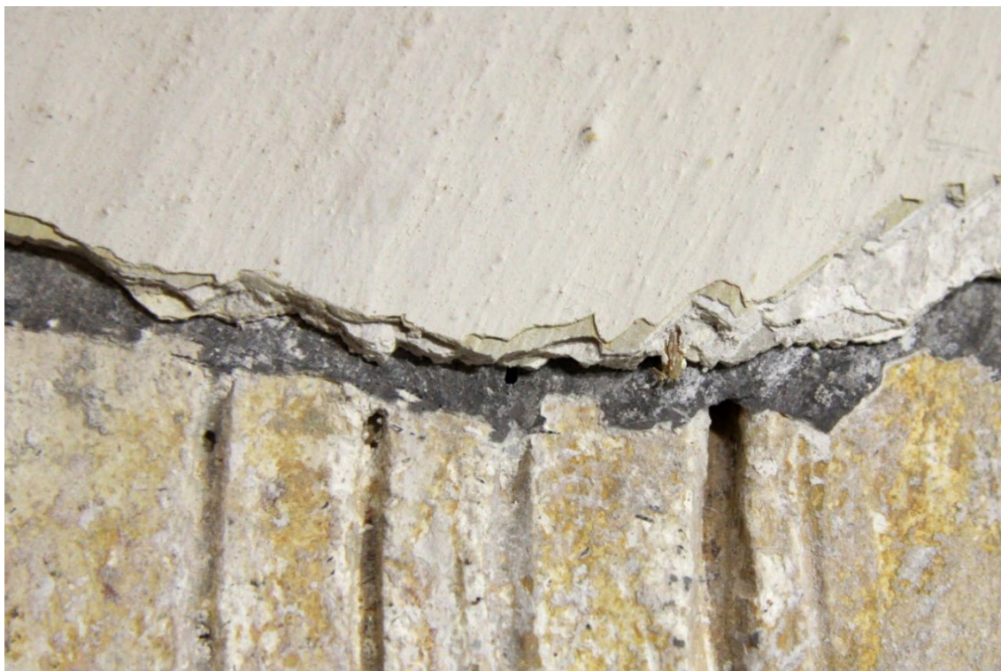
Obr. 105: Souvrství druhotných vrstev, které dosahují vrstvy až 1 cm. Pozadí tympanonu s rytou kresbou za Bohem Otcem v průběhu odkryvu.
