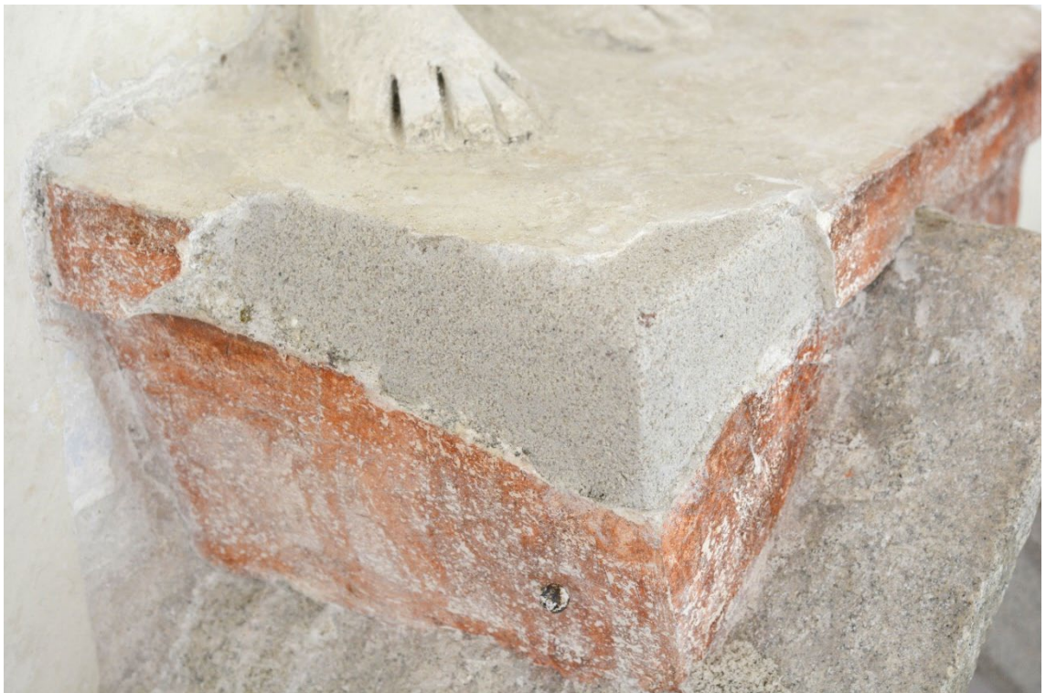
Obr. 149: štukový podstavec pod Kristem v průběhu tmelení. Na snímku je patrná jádrová vrstva vápenného štuk.
