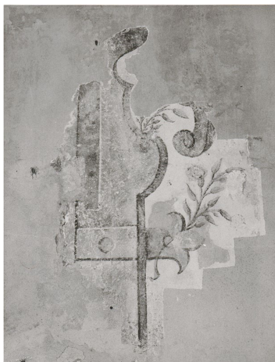
Obr. 59: Sondážní průzkum na severní stěně boční lodi odhalující přítomnost renesančních malovaných rámuů. Průzkum provedený v roce 1995 pod vedením restaurátora Jiřího Látala.
