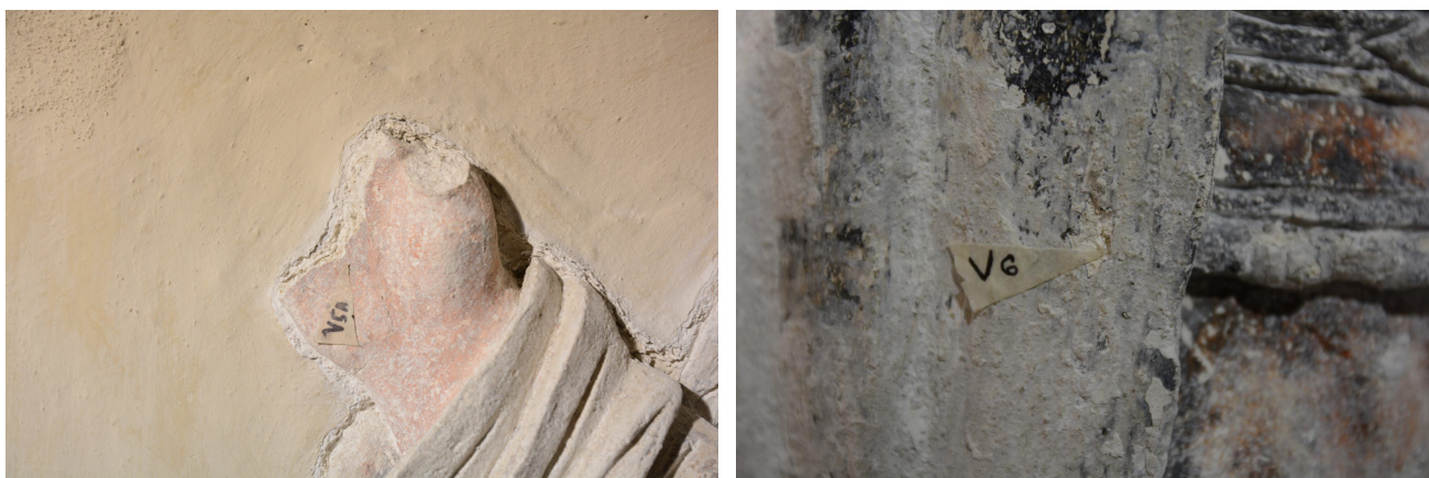
Obr. 5: Detail místa odběru vzorku V5A. Zděný sokl pod erbem Rosiny z Vartenberka. Cementová malta se svrchní omítkou/cementová malta s cihlou.
