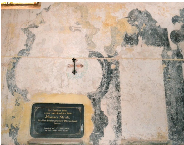
Obr. 66: Monotónní malované rámy na jižní stěně boční lodi. Vpravo je patrné poškození rámu způsobené renovací kůru v polovině 19. století. Stav v roce 2022 je identický se stavem v roce 2001 (obr. 61).
