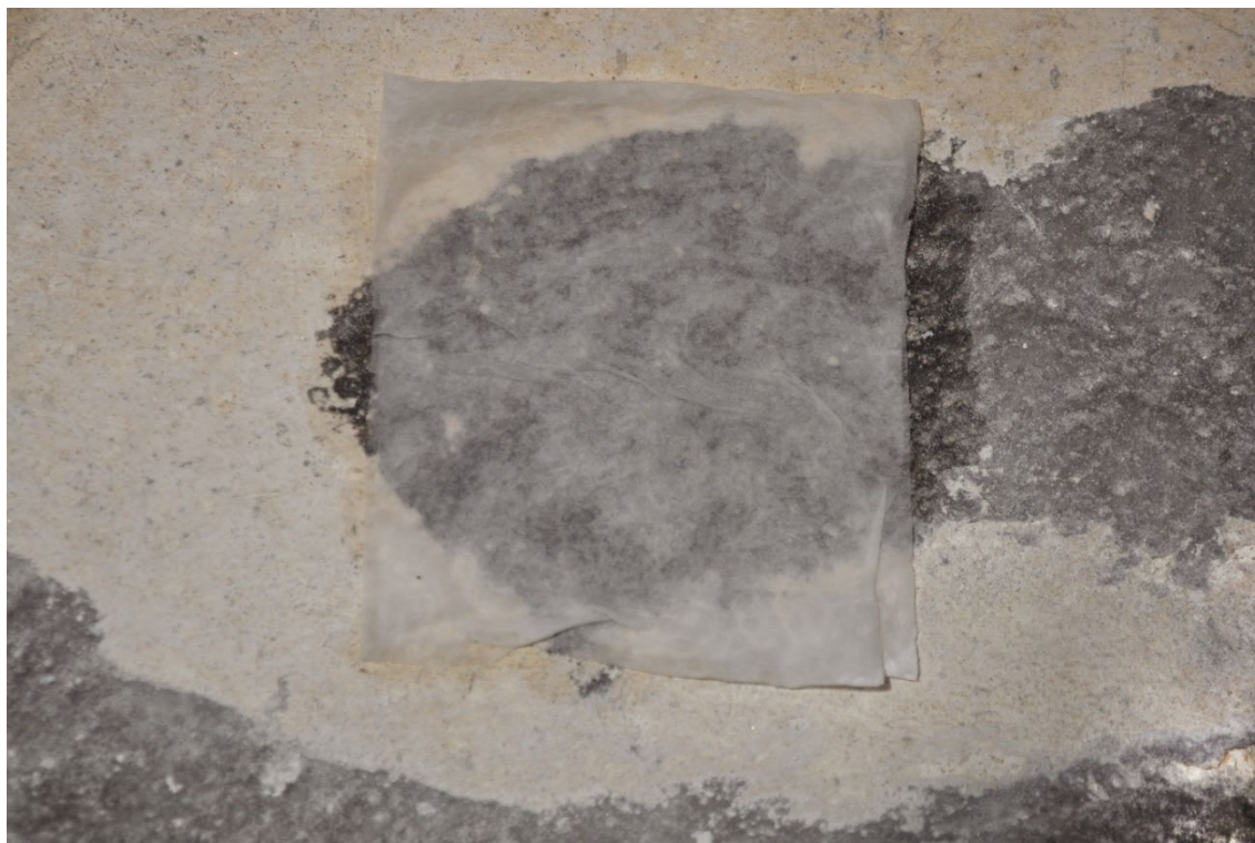
Obr. 107: Postup odstraňování nejstarší druhotné vrstvy, která byla prvně změkčena zábalen z destilované vody a buničiny po dobu cca 15 minut. Pozadí Boha Otce v tympanonu. Průběh snímání druhotných vrstev.
