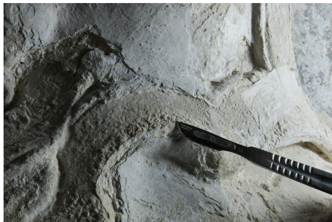
Obr. 14: Detail místa odběru vzorku V14 (S1) pro chemicko-technologický průzkum. Přilba, seškrab solných výkvětu na sekundárním doplňku.
