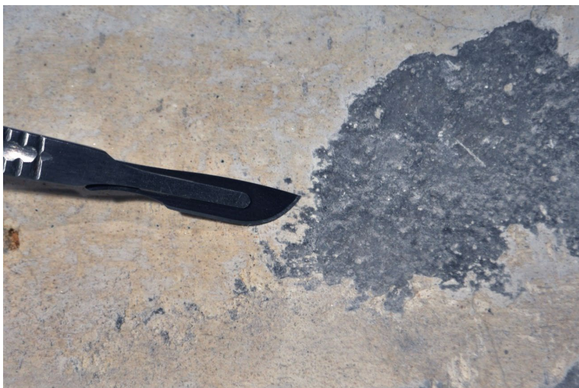
Obr. 108: Odstraňování druhotné vrstvy a následné dočišťování renesanční vrstvy pomocí skalpelu.
