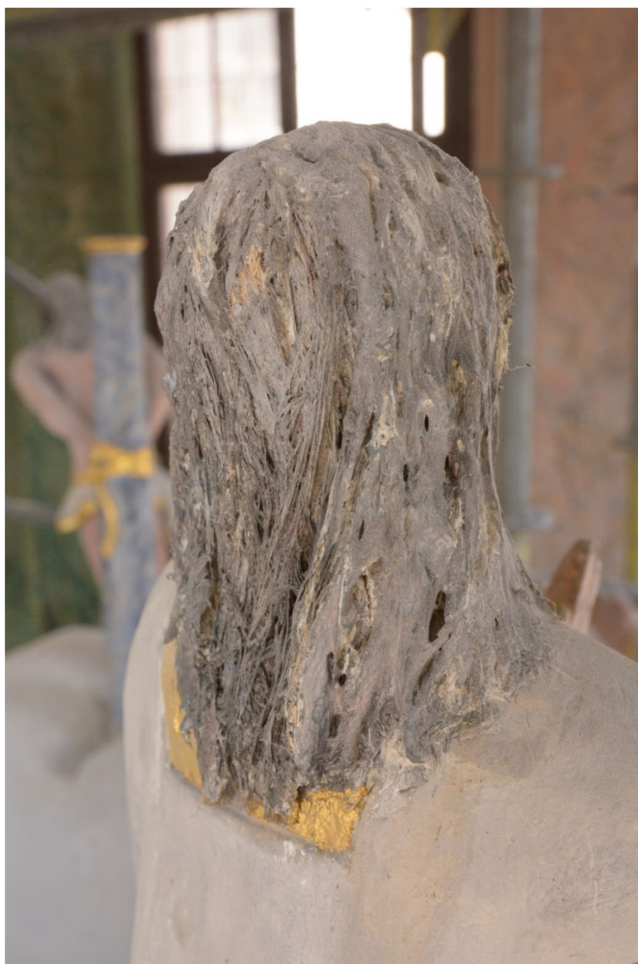
Obr. 100: Detail vlasů Krista z pašijového cyklu na baldachýnovém oltáři v zámecké kapli Všetech svatých v Telči. Na fotografii je patrná koudel pokrytá tenkou vrstvou připomínající postup smočení koudle ve vápenné vodě z důvodů podpoření vlasové struktury.
