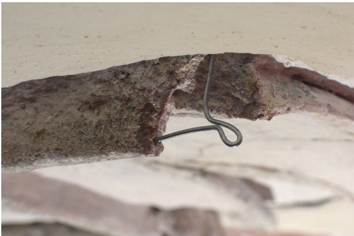
Obr. 146: Umístění záchytných armatur před nanesením hmoty štuku. Zdobné zakončení kříže vítězného praporu.
