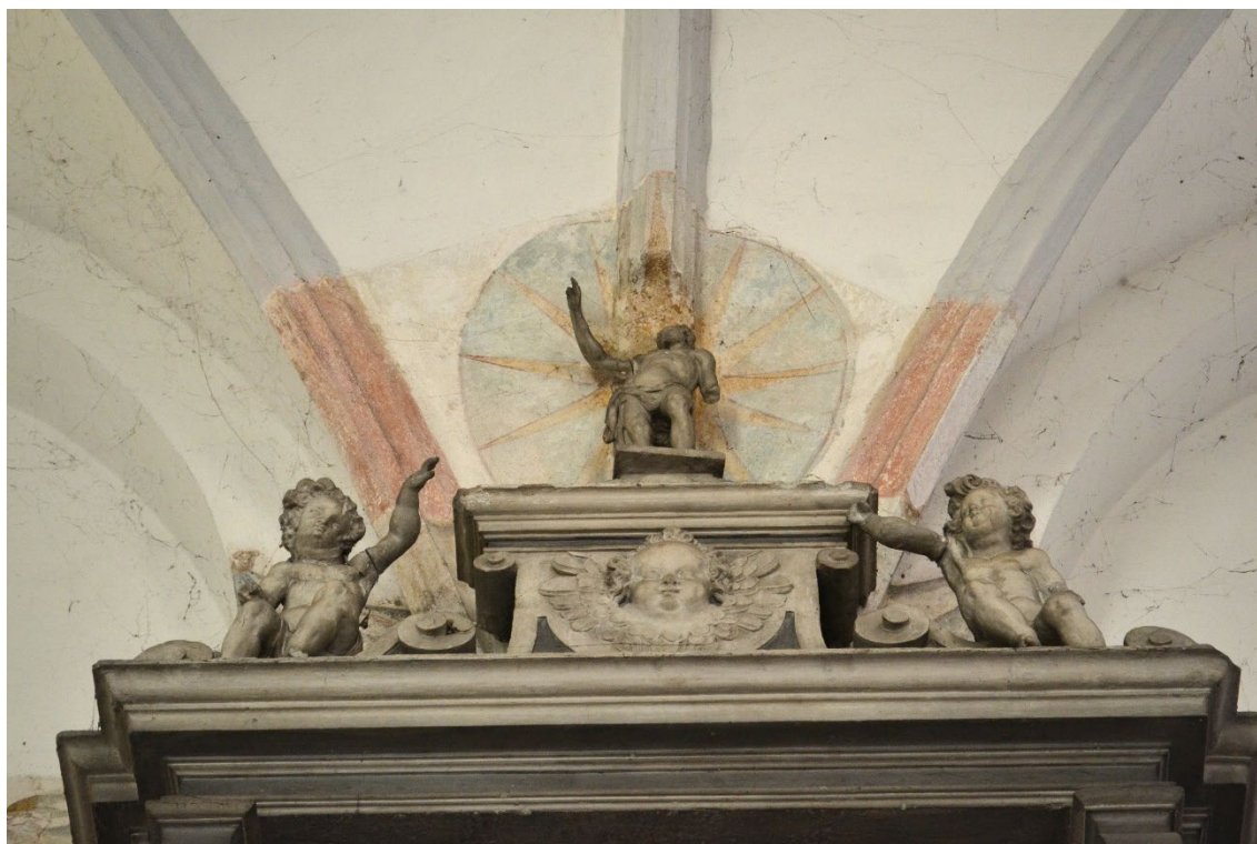
Obr. 80: Horní část epitafu s okolní výmalbou. Na snímku je patrné osekání klenebního žebra kvůli dostatečnému prostoru pro vrcholovou sochu Vítězného Krista.
