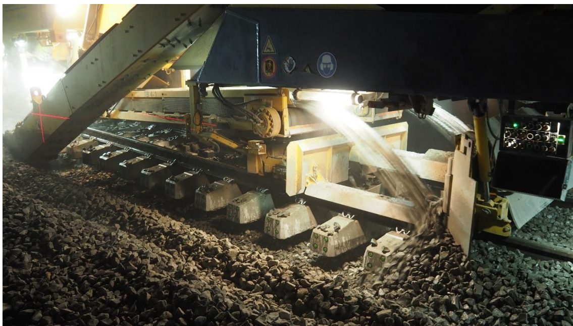
Obrázek 8 - Čistička štěrkového lože C 75 za provozu
