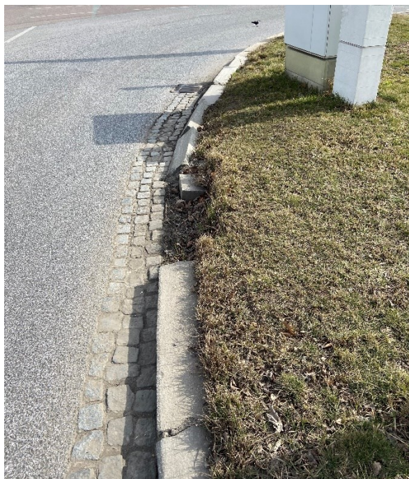
Obrázek 27 – Porušení nároží křižovatky
