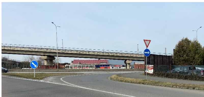
Obrázek 21 – Pohled na připojovací větev
