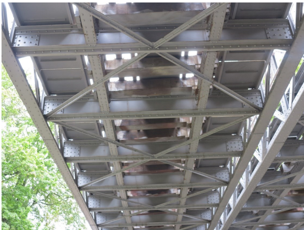
Obrázek 3 - Spodní pohled na konstrukci mostovky
