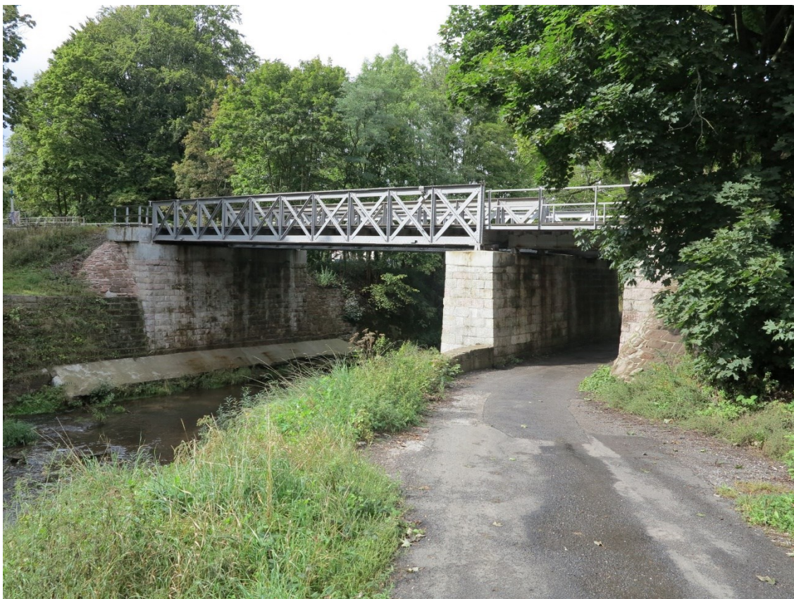
Obrázek 1 - Pohled na konstrukci z levého břehu
