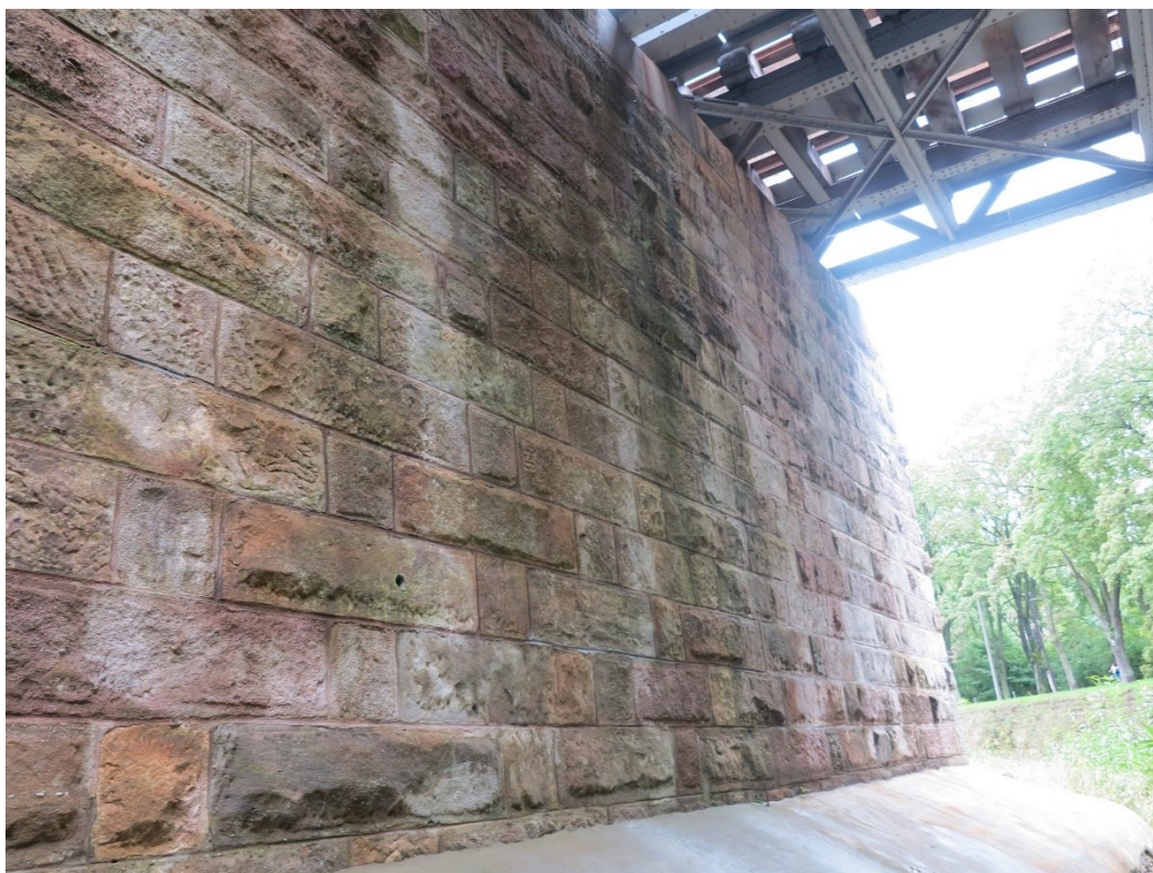
Obrázek 5 - Detail vnitřní strany pilíře P 01
