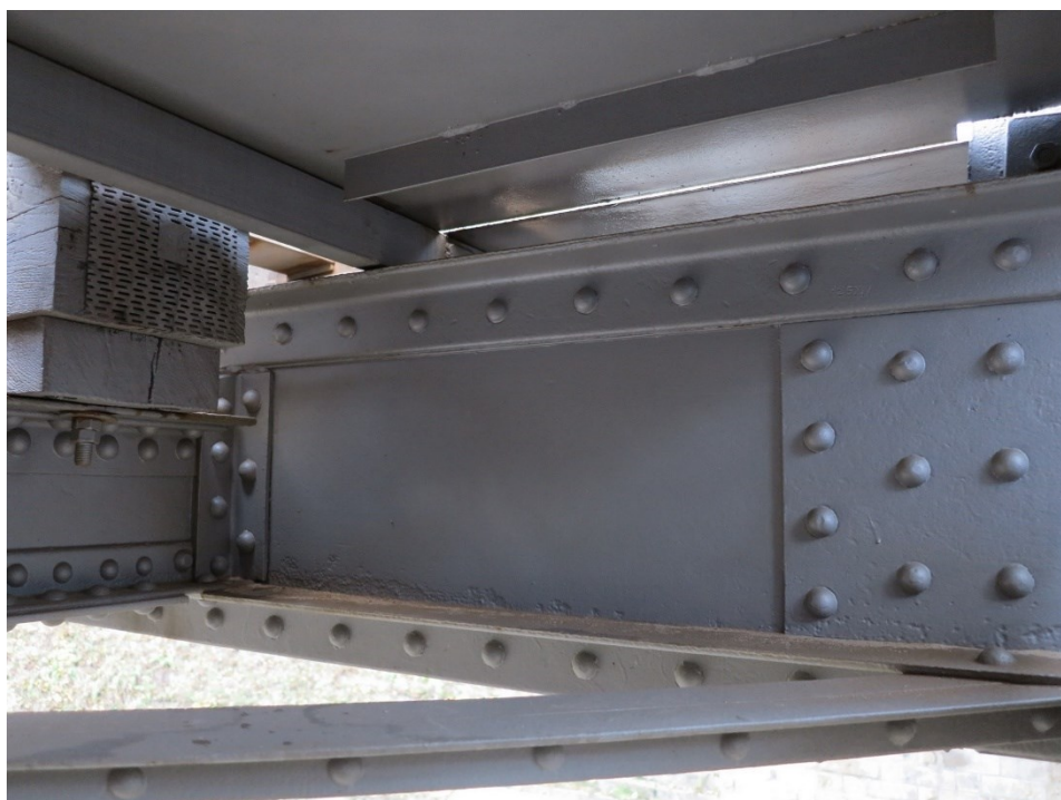
Obrázek 6 - Detail mostovky. Připojení podélníku na příčník
