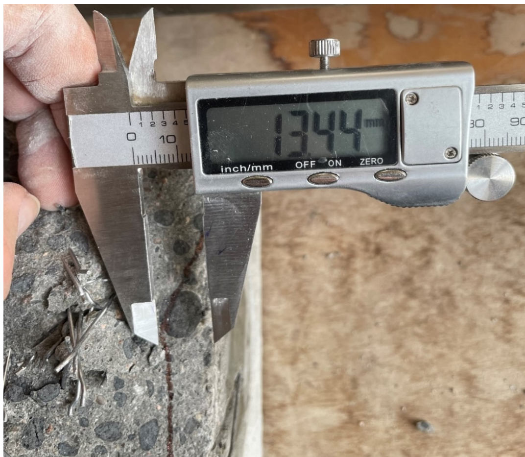
Obrázek 26: Hloubka průsaku na tělese 1-V5 [vlastní foto]
