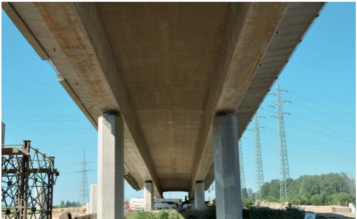
Obrázek 6: Plnostěnný trámový most na silnici R6 Sokolov-Tisová [33]
