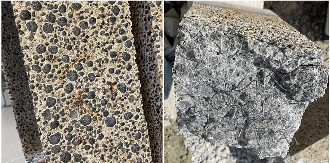
Obrázek 16: Detail poškození sady CHEM [vlastní foto]
