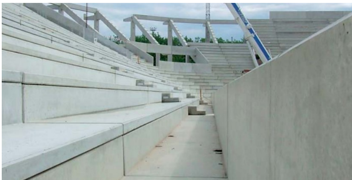
Obrázek 5: Výstavba stadionu Eden v Praze [33]
