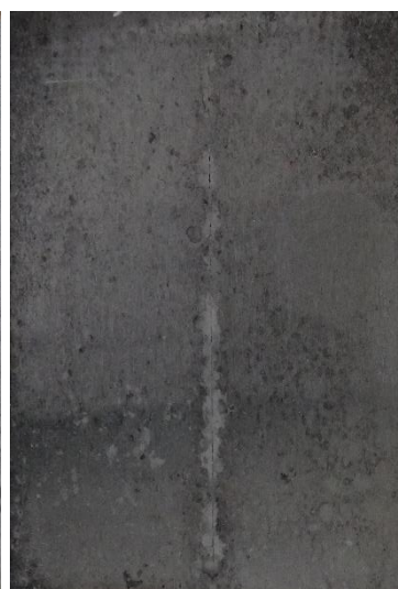
Po stažení nátěru
