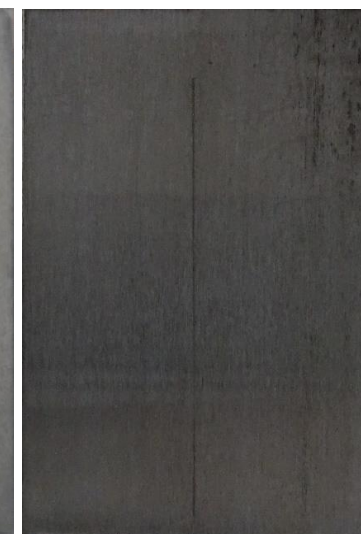
Po stažení nátěru
