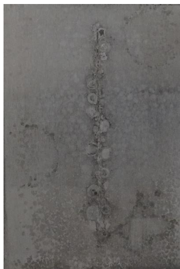
Po stažení nátěru
