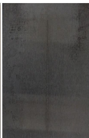
Po stažení nátěru
