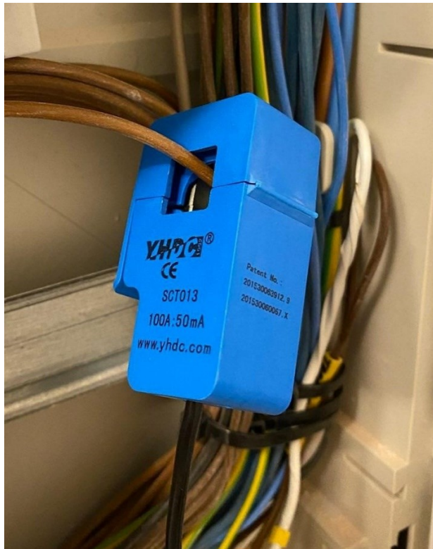
Obrázek 14: Instalace proudového transformátoru
