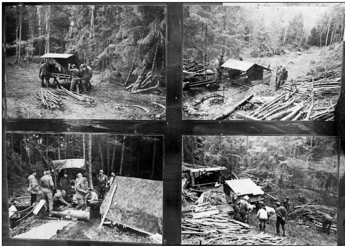
Fotografie č. 22: Průběh stavby. 693
