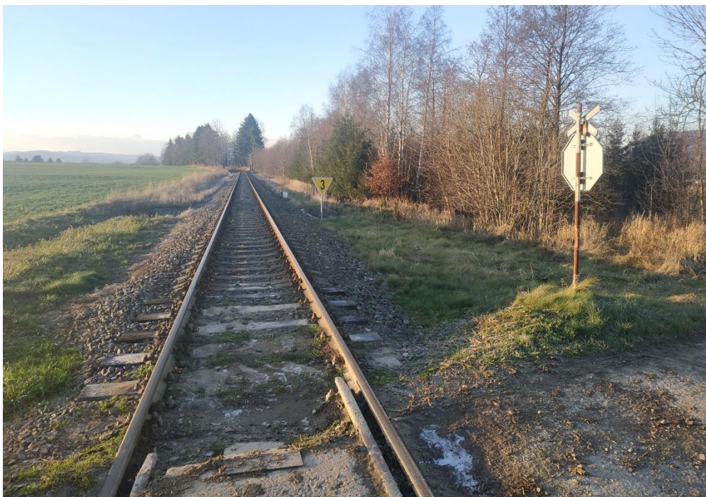
Obrázek 8: Pohled na trať ve směru na Dolní Lipku
