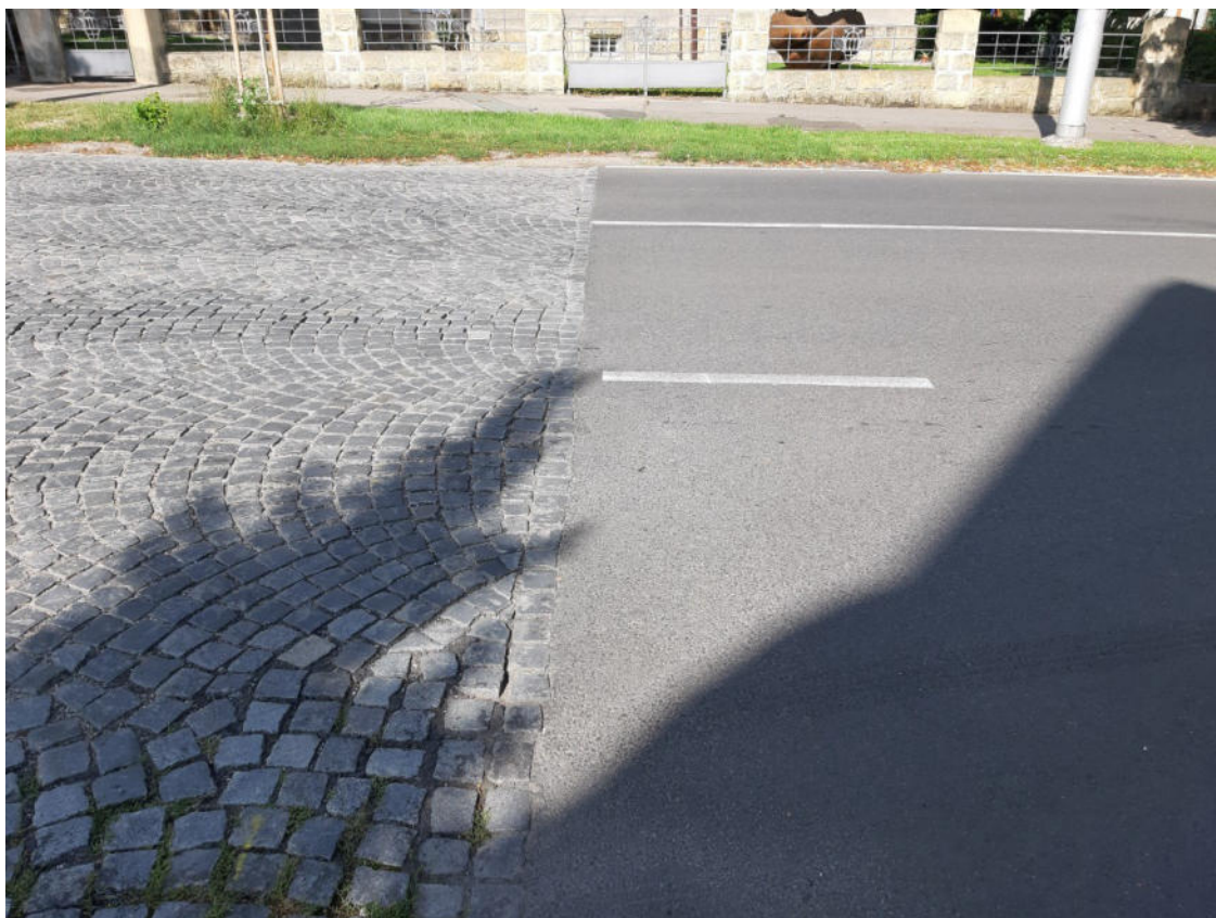
FOTO 36: ulice Nezvalova, napojení povrchů (nový povrch z r. 2020). Foto: autor
