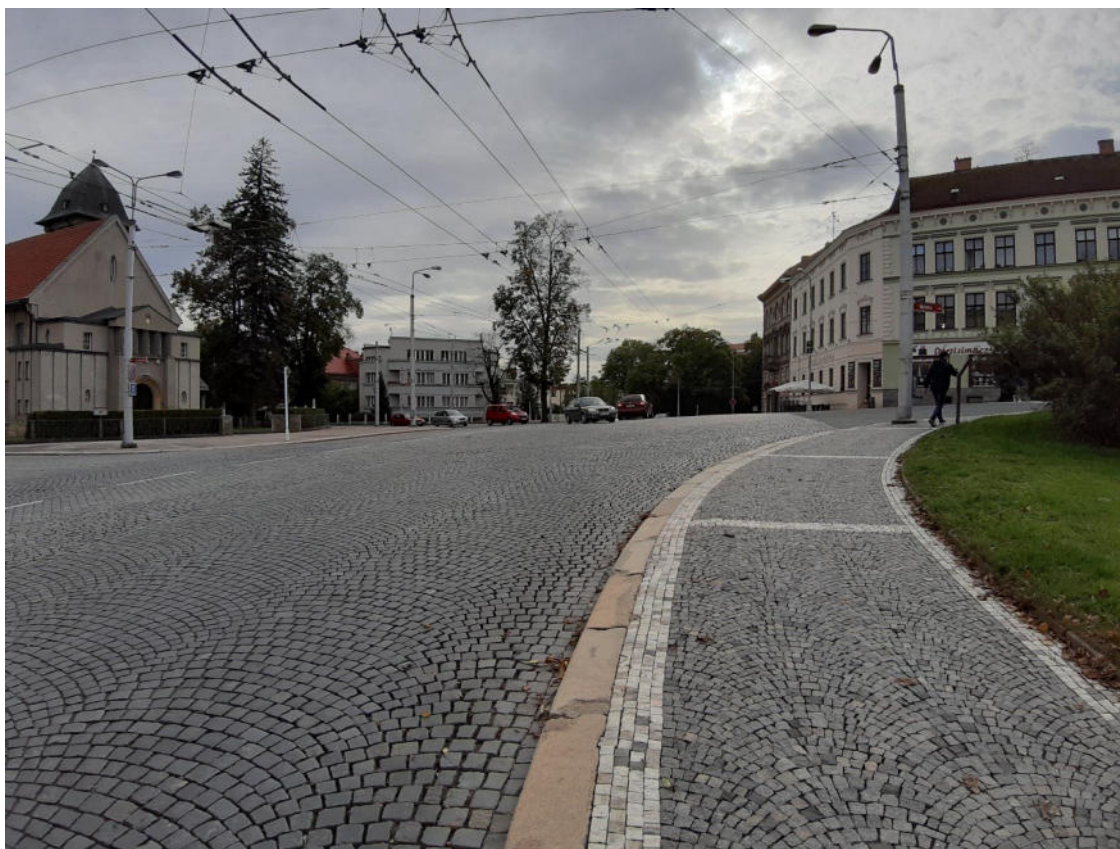
FOTO 22: Pohled z ulice ČSA, kostkový povrch, chybějící VDZ - nezřetelné jízdní dráhy. Foto: autor
