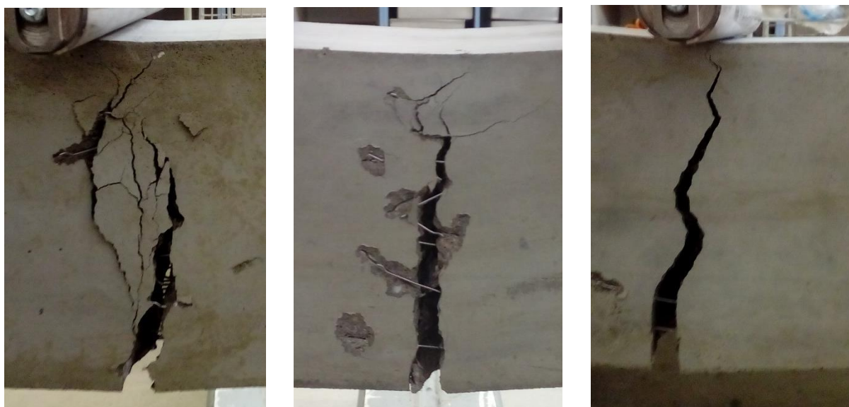
Obrázek 20. – Rozdílné šíření trhlín na zadních stranách zkušebních hranolů
