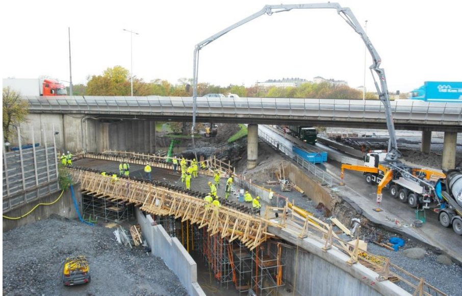
Obr. 4.11 Betonáž mostovky.
