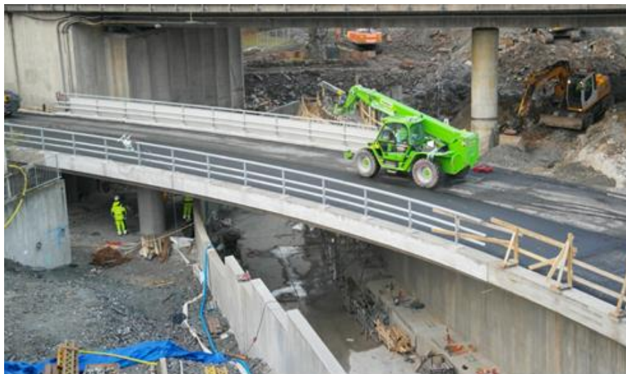
Obr. 4.12 Dokončený most č. 2-2043-15.
