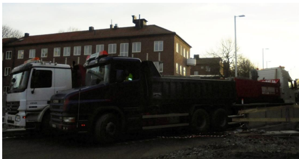
Obr. 4.15 Zatěžovací zkouška – 2. zatěžovací stav – čtyři nákladní vozidla.
