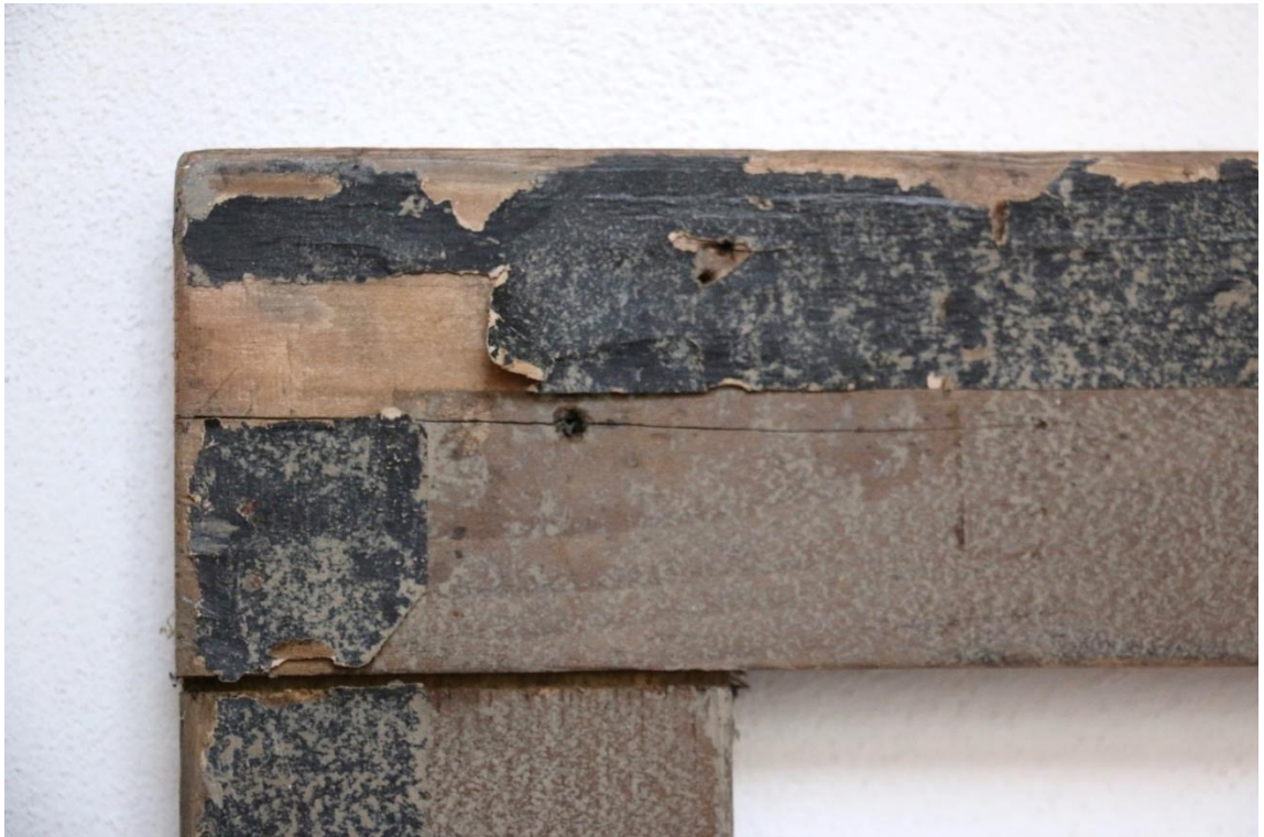
Obr. 55 Detail stavu původního dřevěného rámu před restaurátorským zásahem
