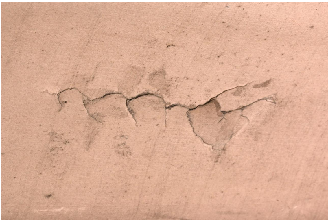
Obr. 5 Detail mechanického poškození papírové podložky ve formě trhliny, stav před restaurováním
