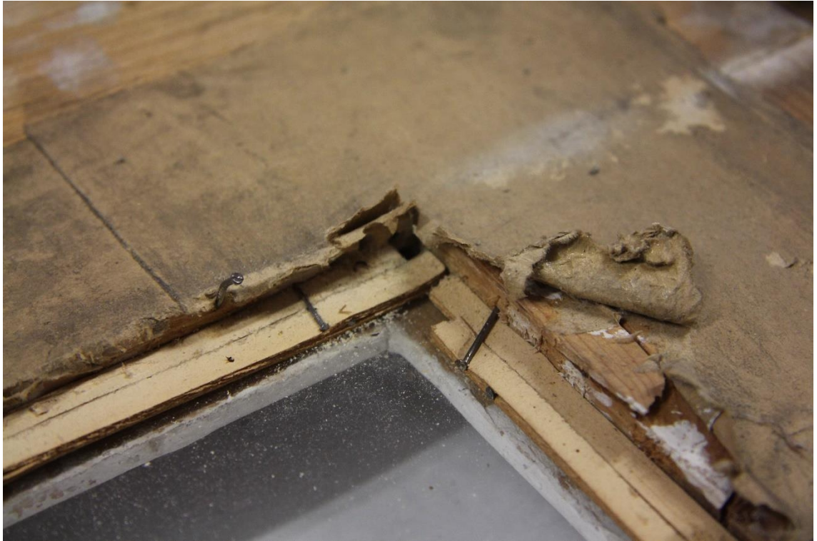
Obr. 44 Stav před restaurování, rám po vyjmutí díla, detail poškození
