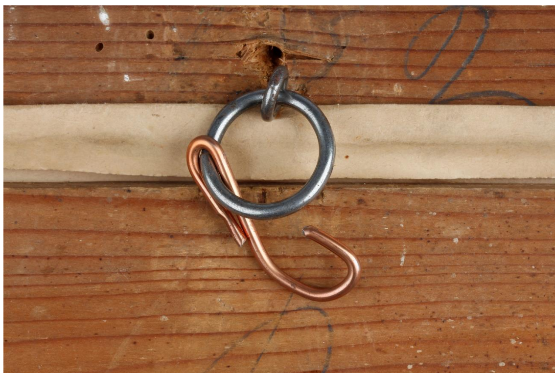
Obr. 136 Stav objektu před restaurováním, detail závěsného systému
