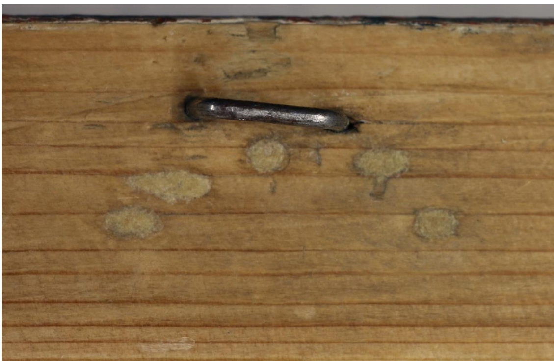
Obr. 49 Stav po restaurování, detail závěsného systému, a zatmelených ztrát
