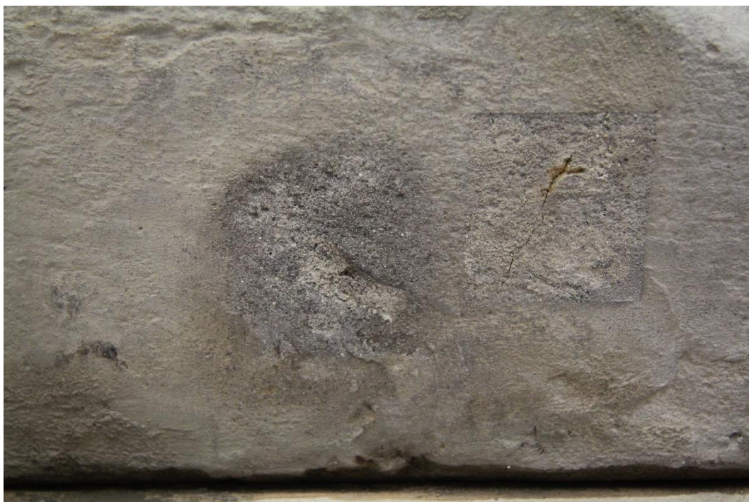
Obr. 51. Zkoušky čištění levá strana zkouška párou, pravá strana zkouška pískováním
