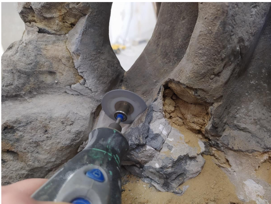
Obr. 65. Odstraňování částí tmelů mikrobruskou
