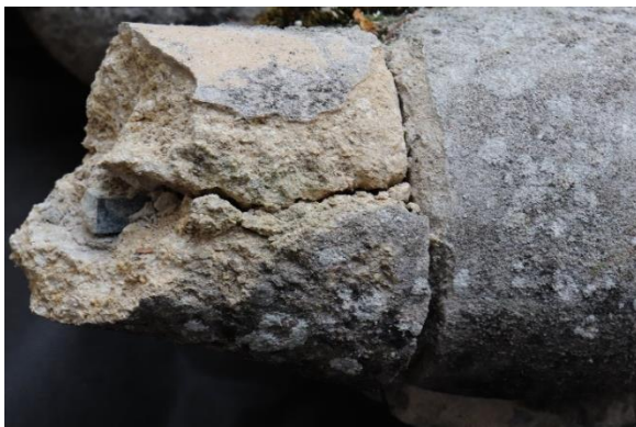
Obr. 25. Trhliny u armatur
