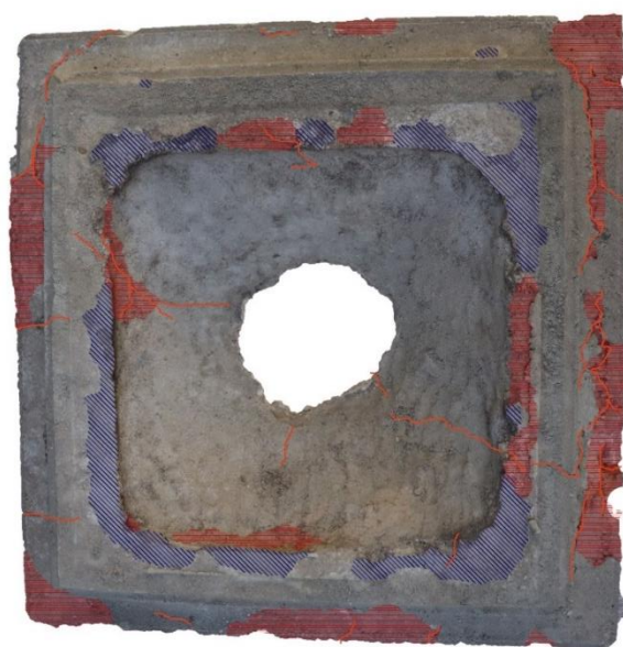
Obr. 172. Grafická dokumentace poškození hlavice spodní strana
