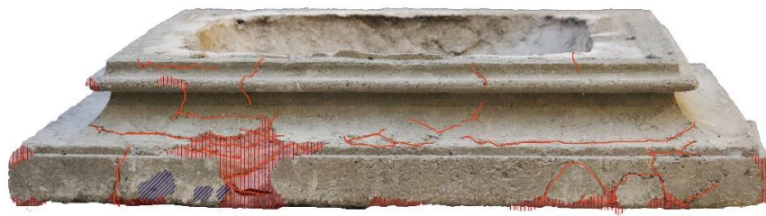
Obr. 174. Grafická dokumentace poškození hlavice strana a
