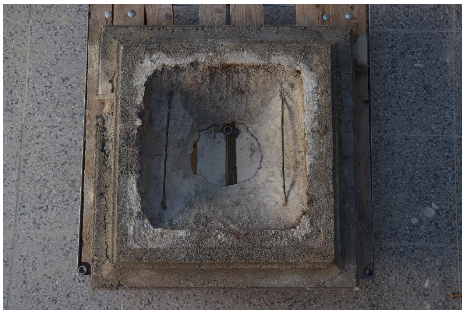
Obr. 164. Hlavice podstavce – nové armatury
