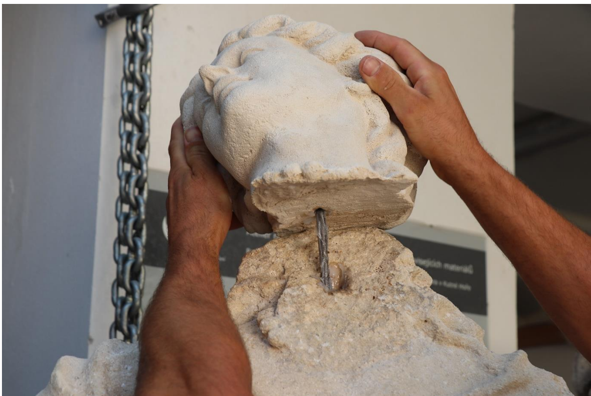
Obr. 66 Nasazování hlavy na závotovou tyč opatřenou lepidlem
