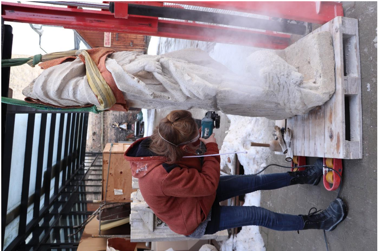
Obr. 50 Nařezávání tmelu ve spoji sochy úhlovou bruskou, před použitím pily
