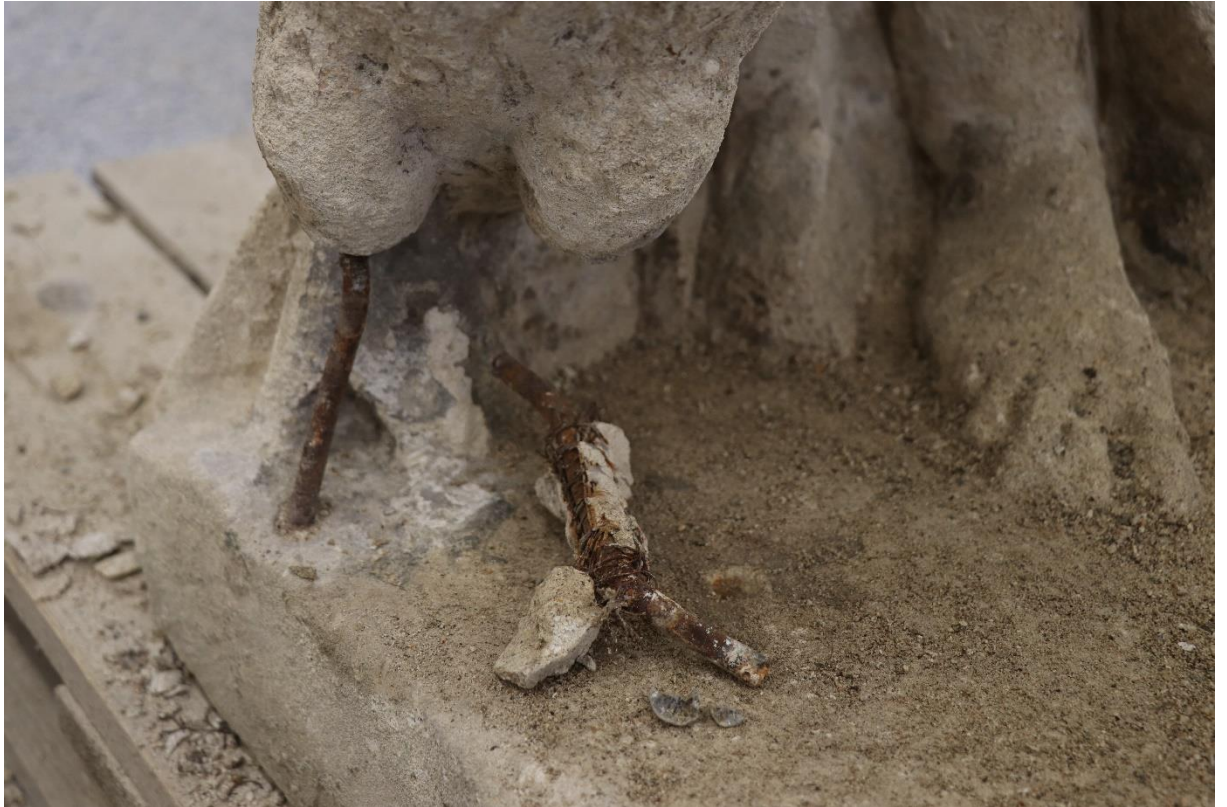
Obr. 48 Detail armatur v nohou páva
