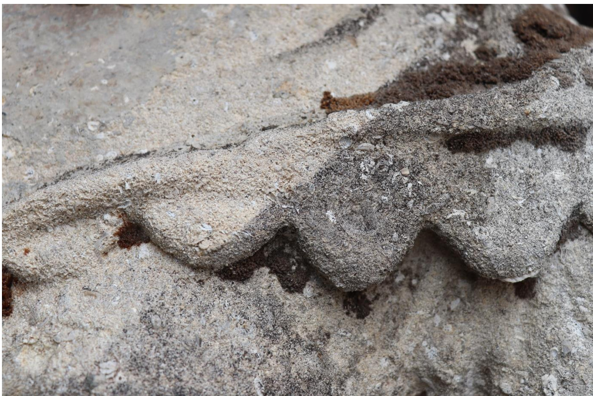
Obr. 36 Detail čištění biologického napadení
