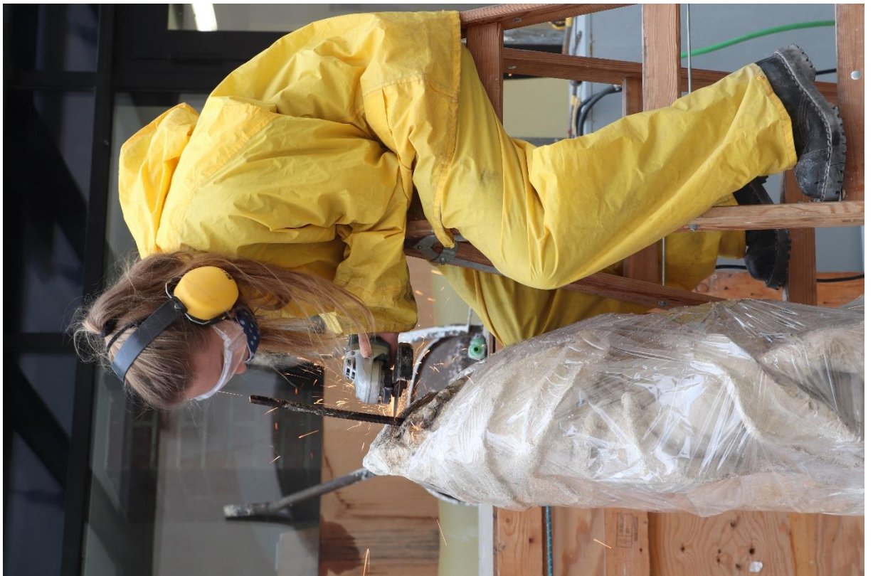
Obr. 45 Řezání příliš dlouhého čepu úhlovou bruskou
