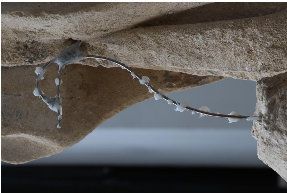
Obr. 63 Armatura páva z nerezové tyče opatřená epoxidovým lepidlem pro mechanické zajištění tmelu
