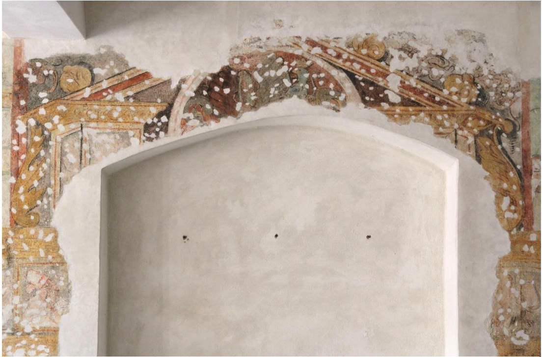
Obr. 91: Detail horní části portálu na západní stěně. Stav po vytmelení.
