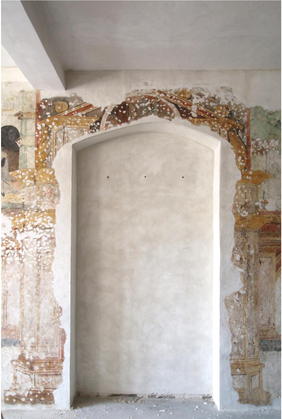
Obr. 90: Celkový pohled na portál na západní stěně. Stav po vytmelení.
