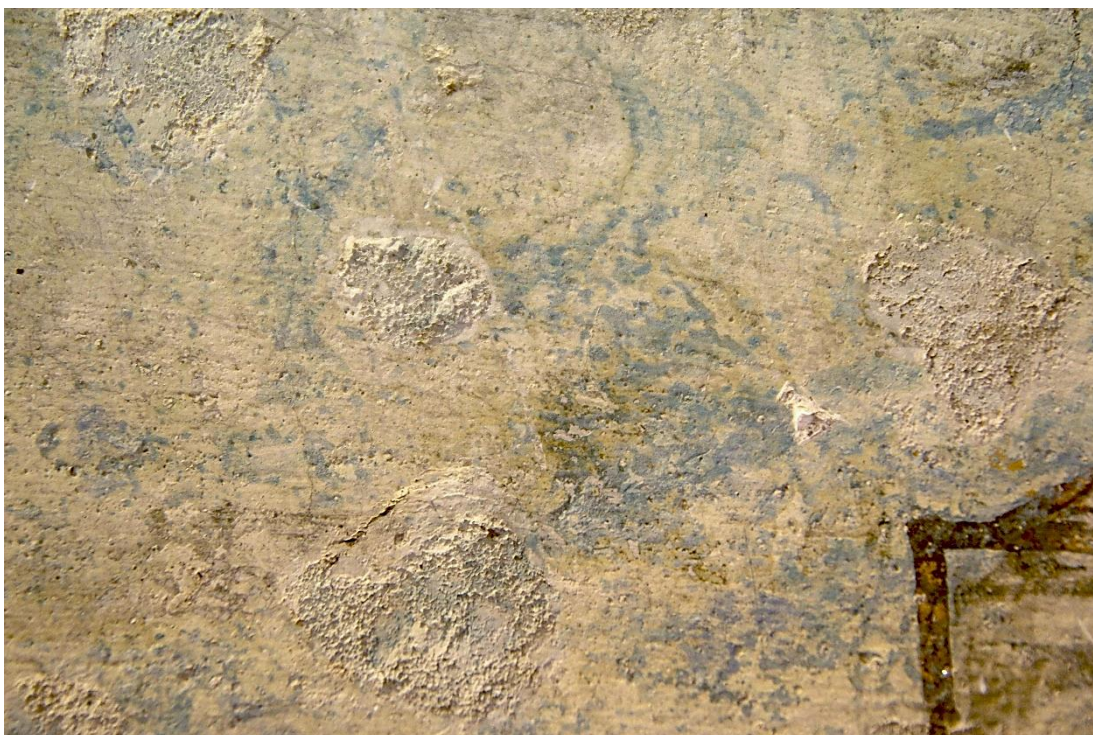
Obr. 31: Detail oblohy v pozadí architektury. Kromě drobných fragmentů modré barevné vrstvy v oblasti oblohy jsou na snímku patrné tmely s nezačištěnými okraji. Fotografie v rozptýleném umělém nasvícení. Stav před restaurováním.
