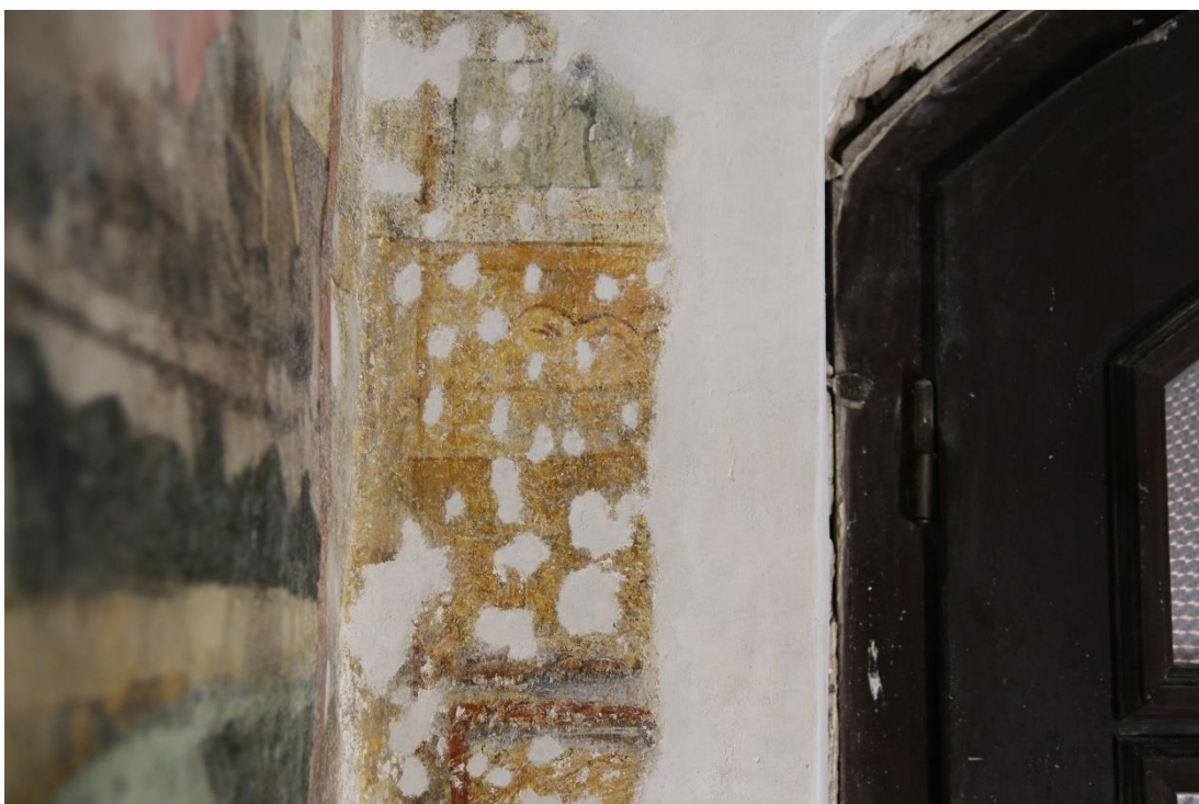
Obr. 98: Detail horní části levého bočního ostění severního portálu. Stav po vytmelení.
