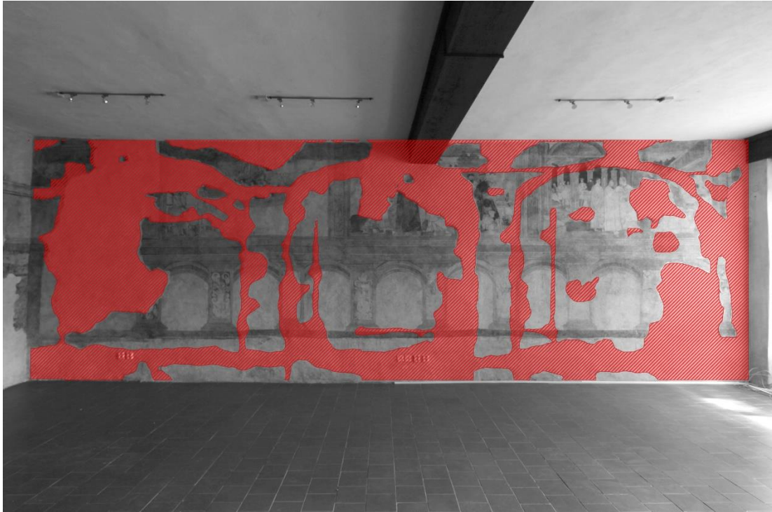
Obr. 10: Grafická dokumentace velkoplošných tmelů (červeně) na východní stěně místnosti. (Zdroj: BERANOVÁ, Anežka, Jana WAISSEROVÁ a Zuzana WICHTERLOVÁ. Dokumentace restaurátorského průzkumu: Průzkum nástěnných maleb v 1. patře nám. Míru čp. 480, Slavonice . 2018. Zdroj: soukromý archiv autorů.)
