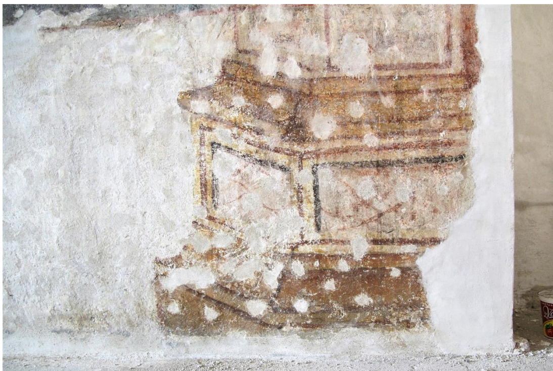
Obr. 93: Detail patky levého ostění západního portálu. Stav po vytmelení.
