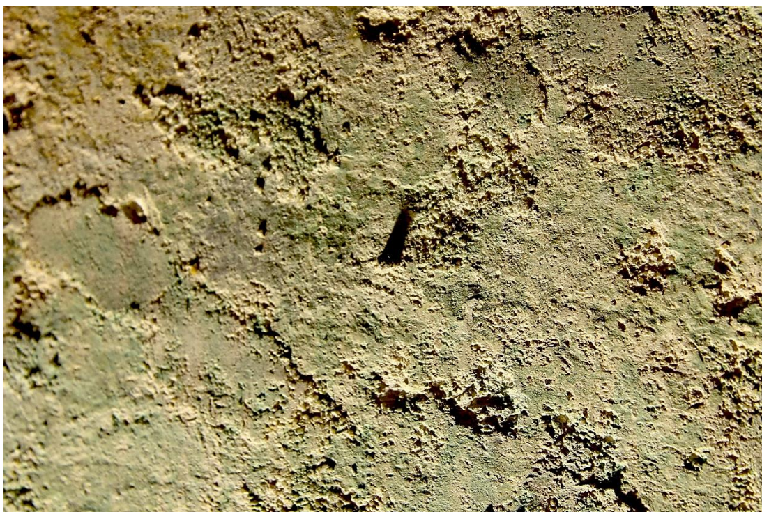
Obr. 29: Uprostřed fotografie jde vidět hřebíček v originální omítkové vrstvě. Fotografie v ostrém bočním nasvícení. Stav před restaurováním.
