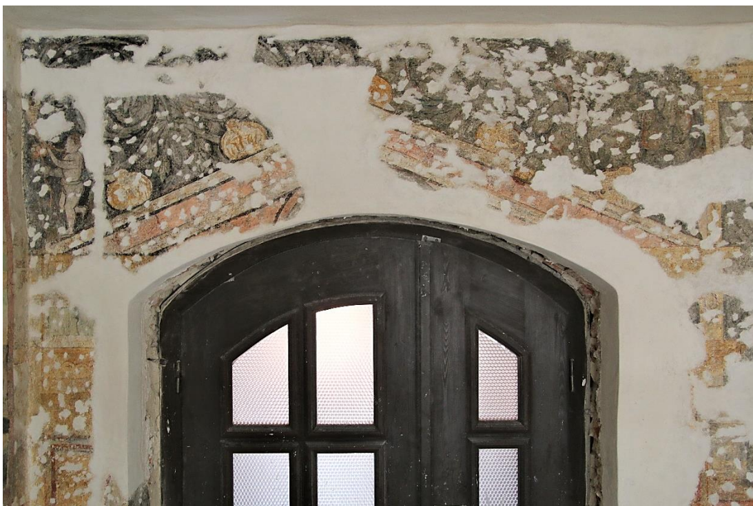
Obr. 97: Detail horní části severního portálu. Stav po vytmelení.
