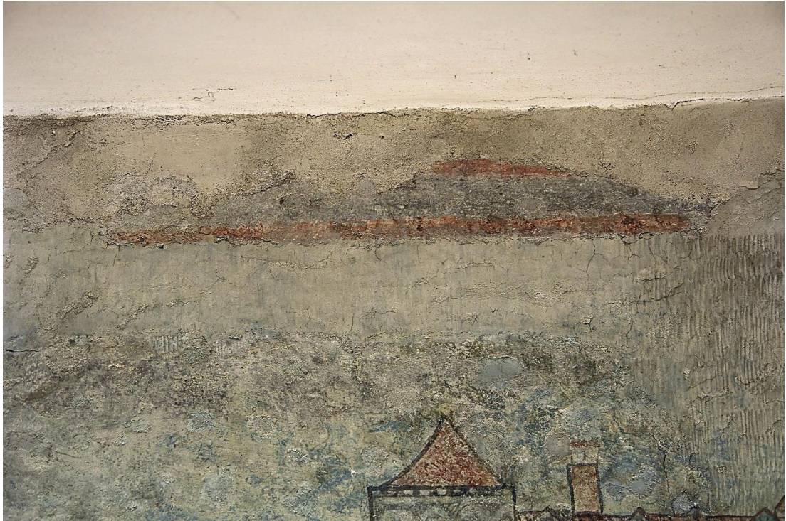
Obr. 18: Dochovaný fragment v horní části výjevu. Na fotografii je patrné různorodé pojetí retuše tmelů. Stav před restaurováním.
