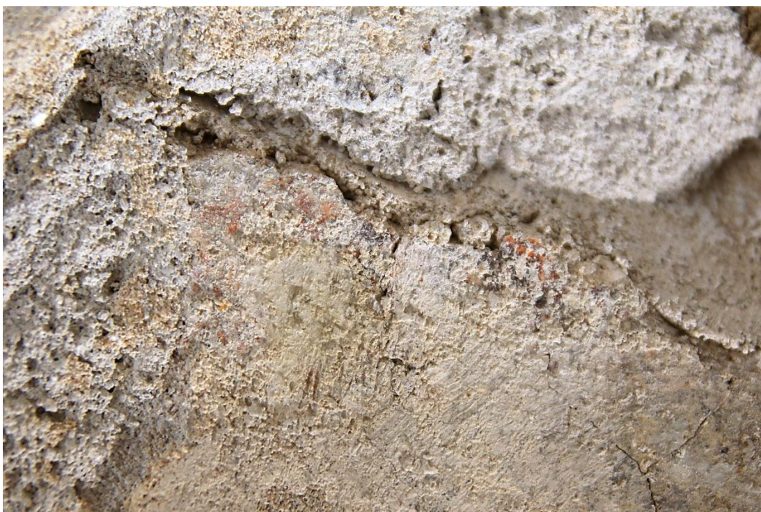
Obr. 44: Horní část výjevu v průběhu odstraňování tmelů. Ve středu fotografie je viditelný fragment s výraznou oranžovou barevnou vrstvou. Tato část byla překryta vrstvou tmelu.
