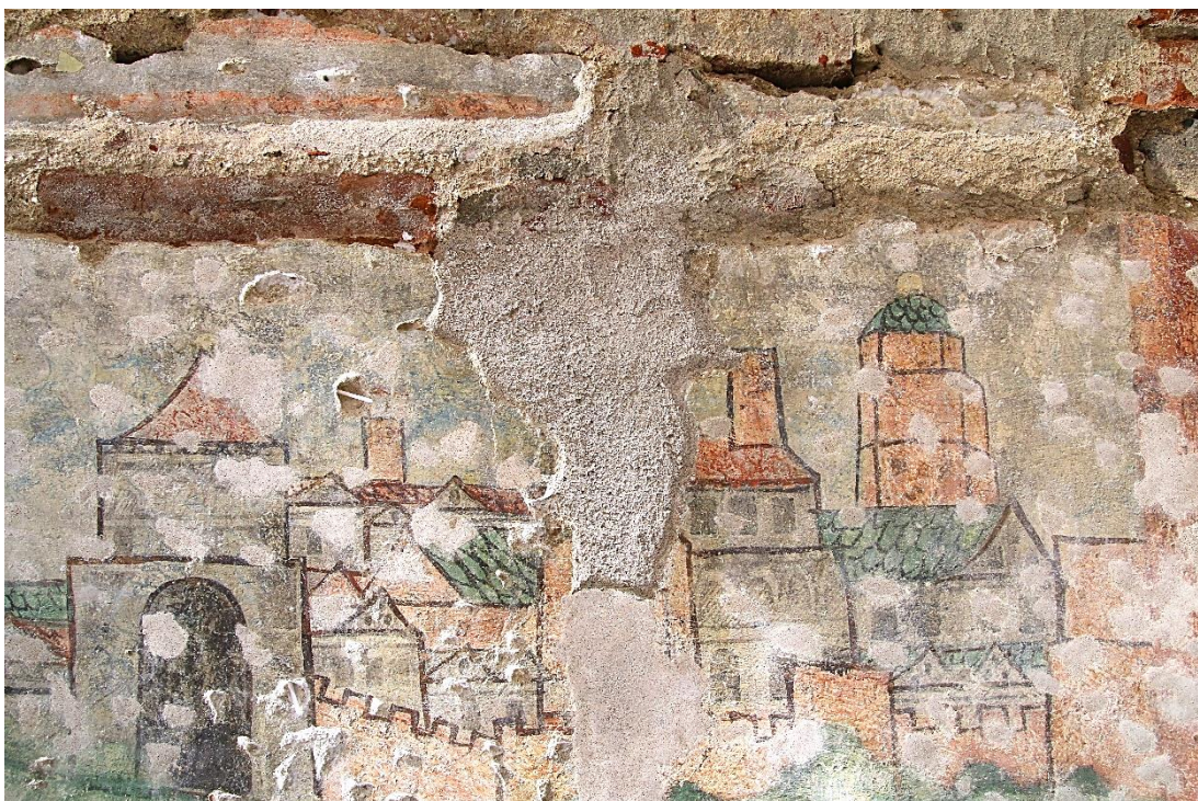
Obr. 49: Architektura v pozadí v průběhu tmelení. Na snímku je patrný způsob vrstvení nově prováděných velkoplošných tmelů.
