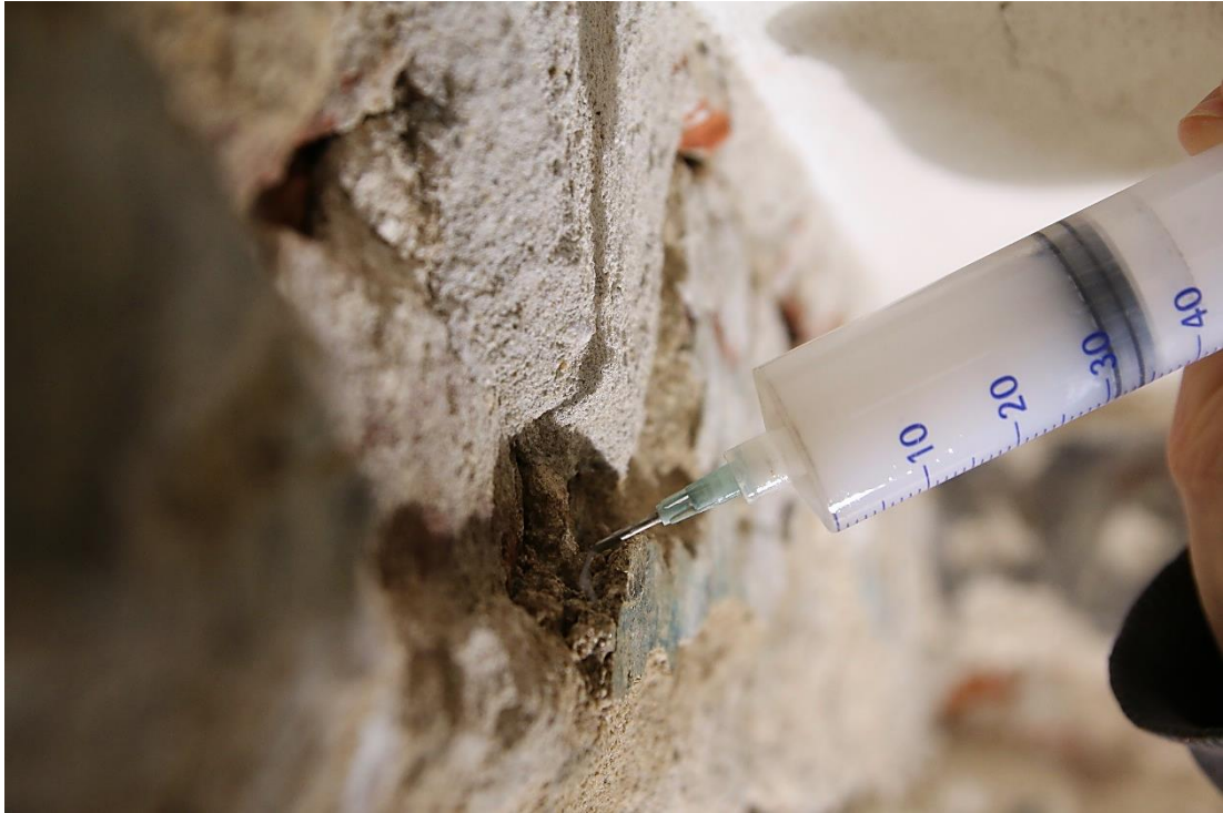
Obr. 51: Proces konsolidace omítkové vrstvy na vedlejším úseku.
