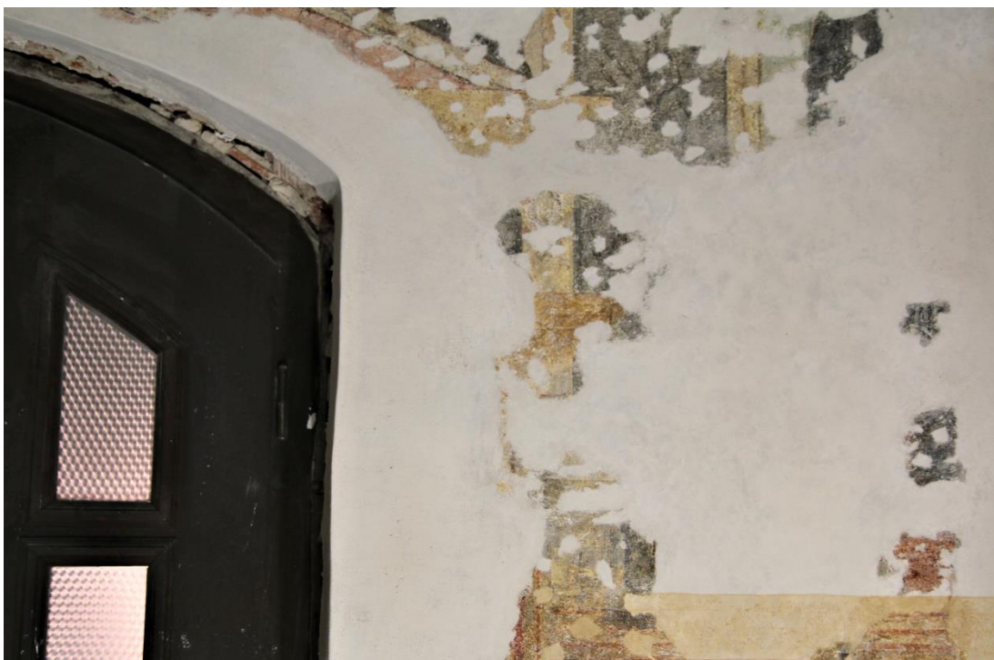
Obr. 99: Detail horní části pravého bočního ostění severního portálu. Stav v průběhu retuší.
