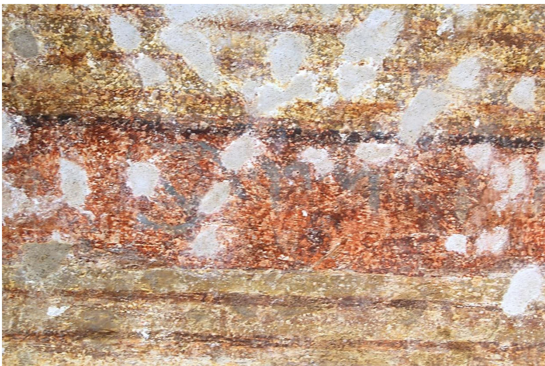
Obr. 69: Detail fragmentu písma v iluzivním vlysu. Stav po vytmelení.
