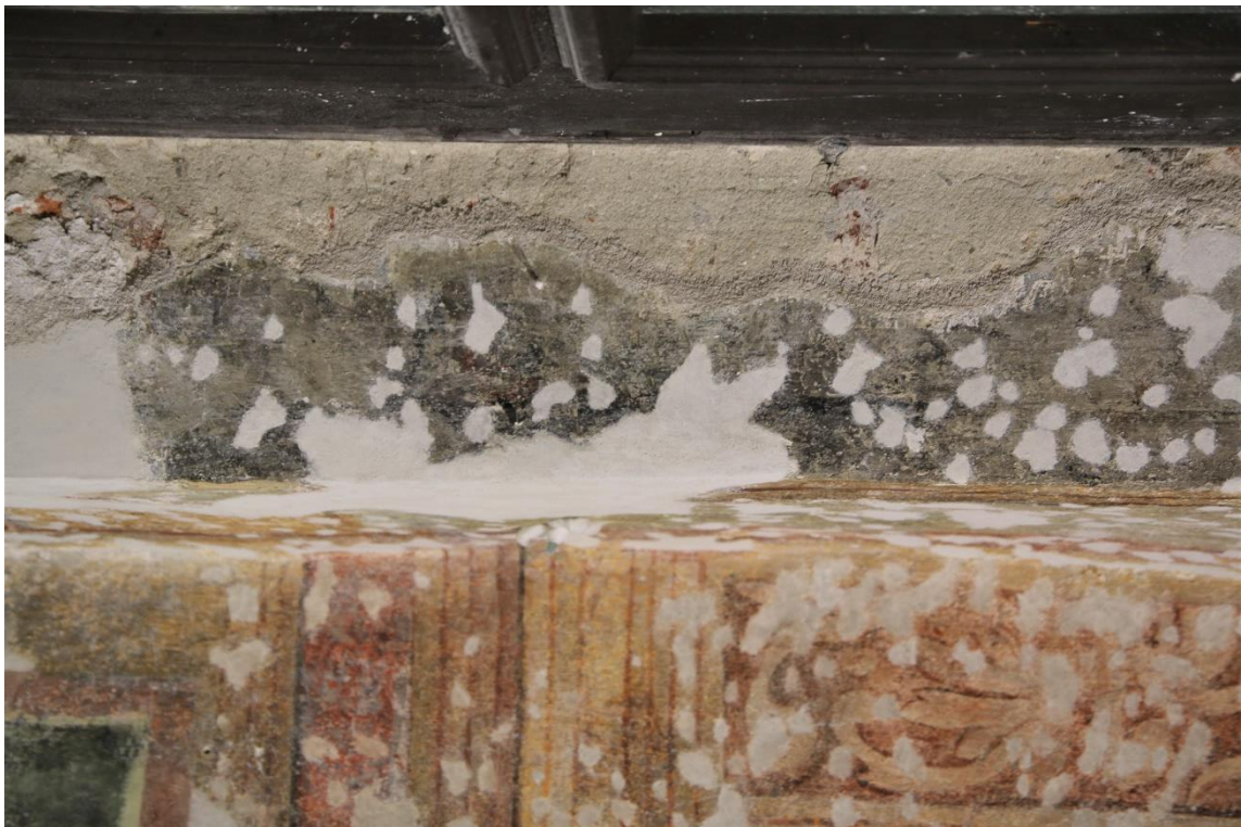
Obr. 101: Detail špalety vstupního prostoru v severní stěně. Na fotografii jsou patrné fragmenty černé barvy. Stav v průběhu tmelení.
