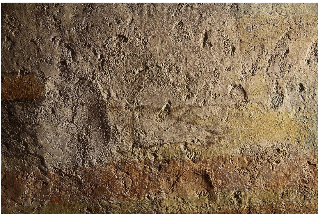
Obr. 24: Detail Kristových nohou v ostrém bočním nasvícení. Na snímku je dobře patrná nerovnost tmelu za patou nohy a okolní tmely, které jsou částečně provedeny pod úroveň originální omítky. Stav před restaurováním.
