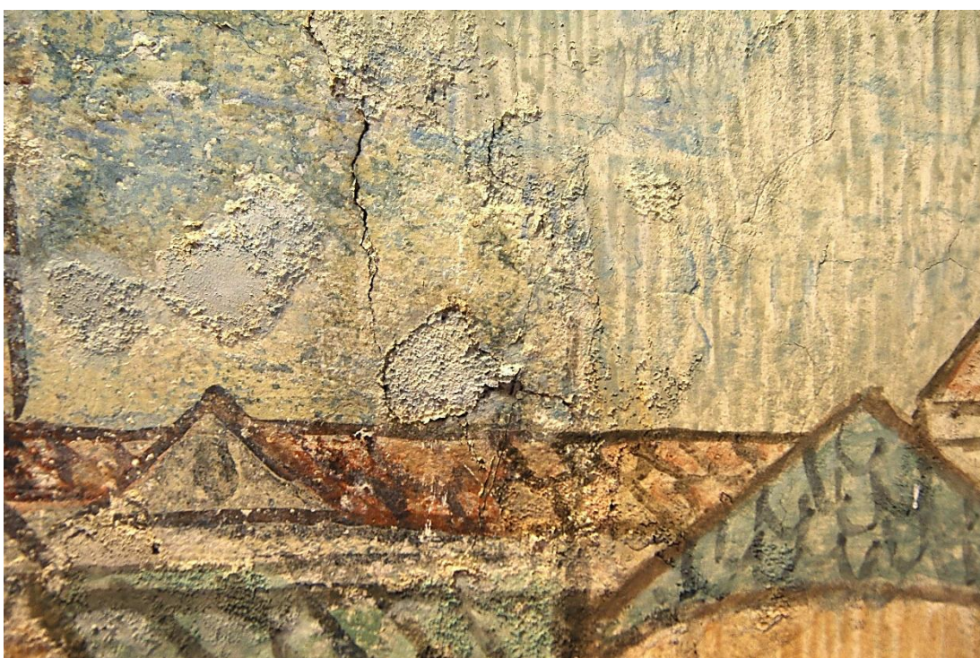
Obr. 32: Detail oblohy v pozadí architektury. Na fotografii jsou viditelné drobné praskliny v originální omítkové vrstvě v okolí druhotných tmelů. Na pravé straně fotografie je viditelná čárkovaná retuš společně s rekonstrukcemi střech. Fotografie v rozptýleném umělém nasvícení. Stav před restaurováním.
