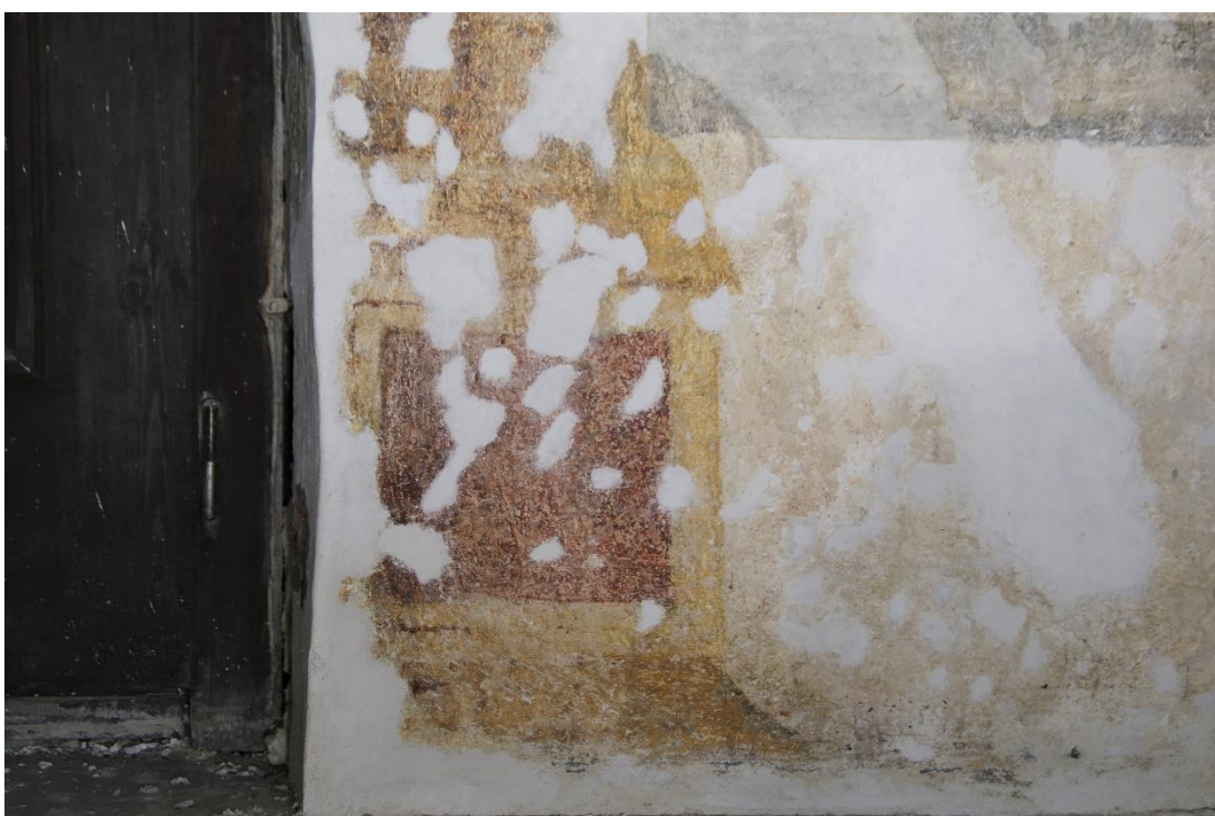
Obr. 100: Detail patky pravého bočního ostění iluzivního portálu na severní stěně restaurované místnosti. Stav v průběhu retuší.
