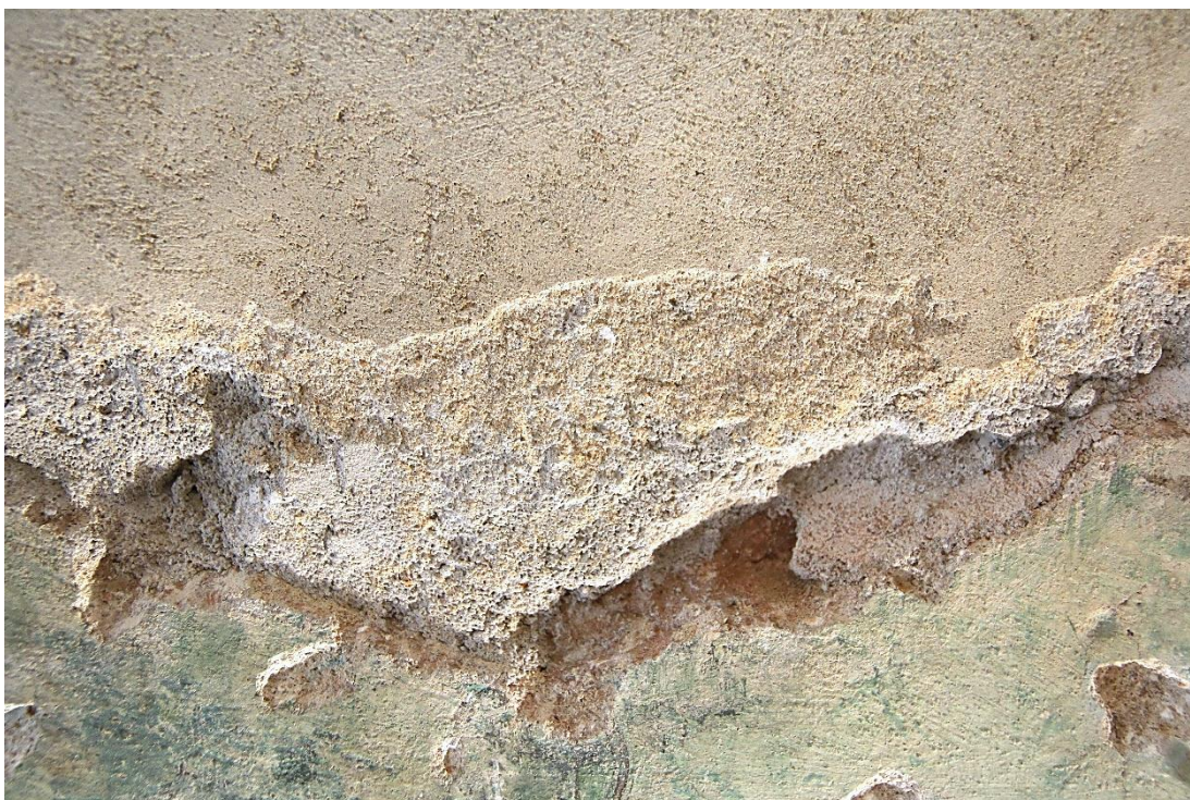
Obr. 43: Detail výstavby velkoplošných tmelů v horní části výjevu. Ve spod je patrné použití tmelu na cementové bázi. Povrch byl zapracován patrně vápenným tmelem za použití písku jako plniva. Stav v průběhu odstraňování tmelů.
