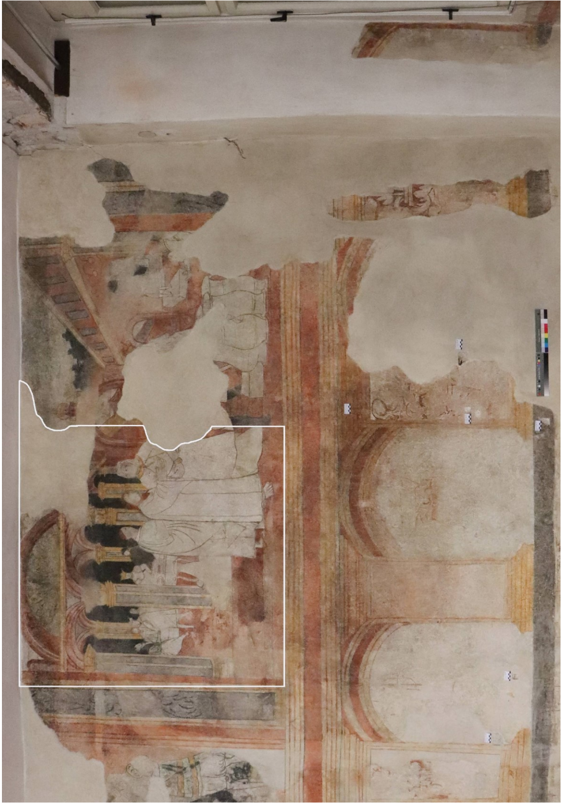
Obrázek č. 1 – Znázornění úseku, který je předmětem restauračního zásahu.
