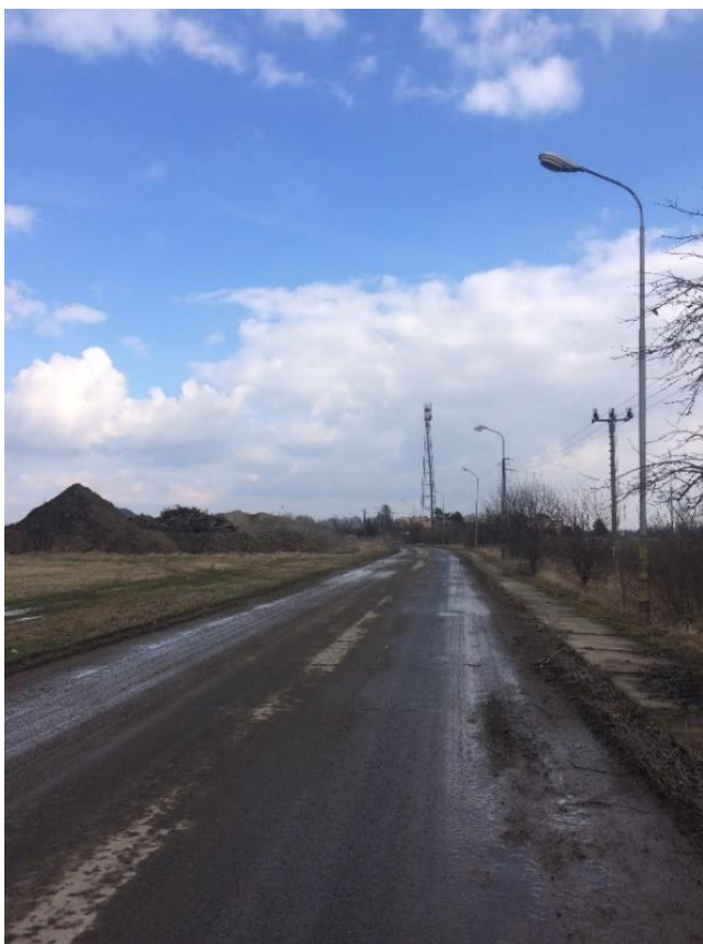
Obrázek č. 2: Cesta k ubytovně
