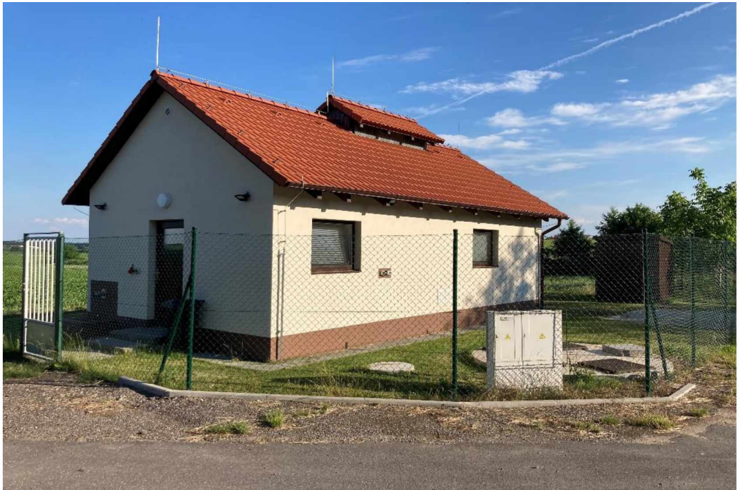
Obrázek 5: Budova ČOV Kasalice
