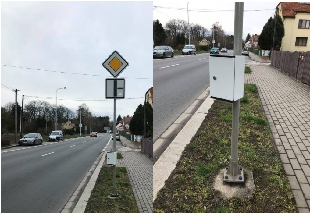
Obrázek 30 Fotografie radaru na úseku 1
