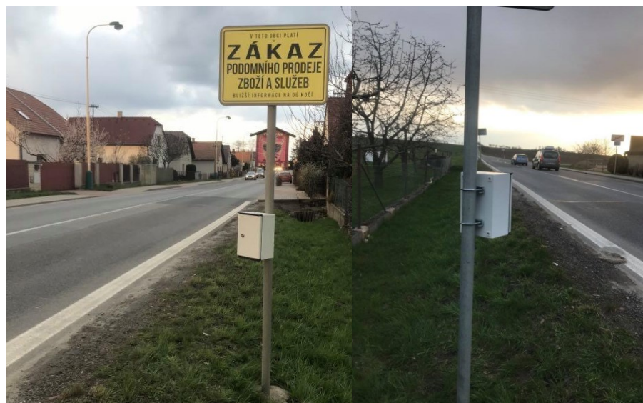
Obrázek 33 Fotografie radaru na úseku 2
