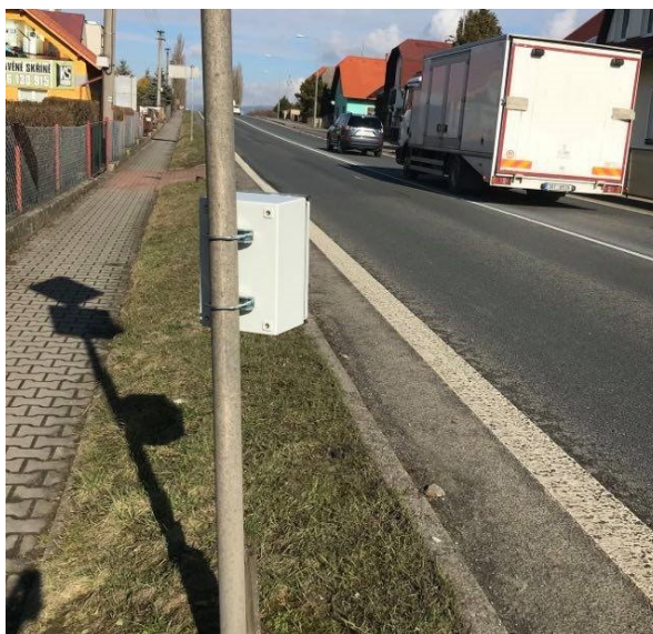
Obrázek 15 Fotografie nainstalovaného radaru na svislém dopravním značení
