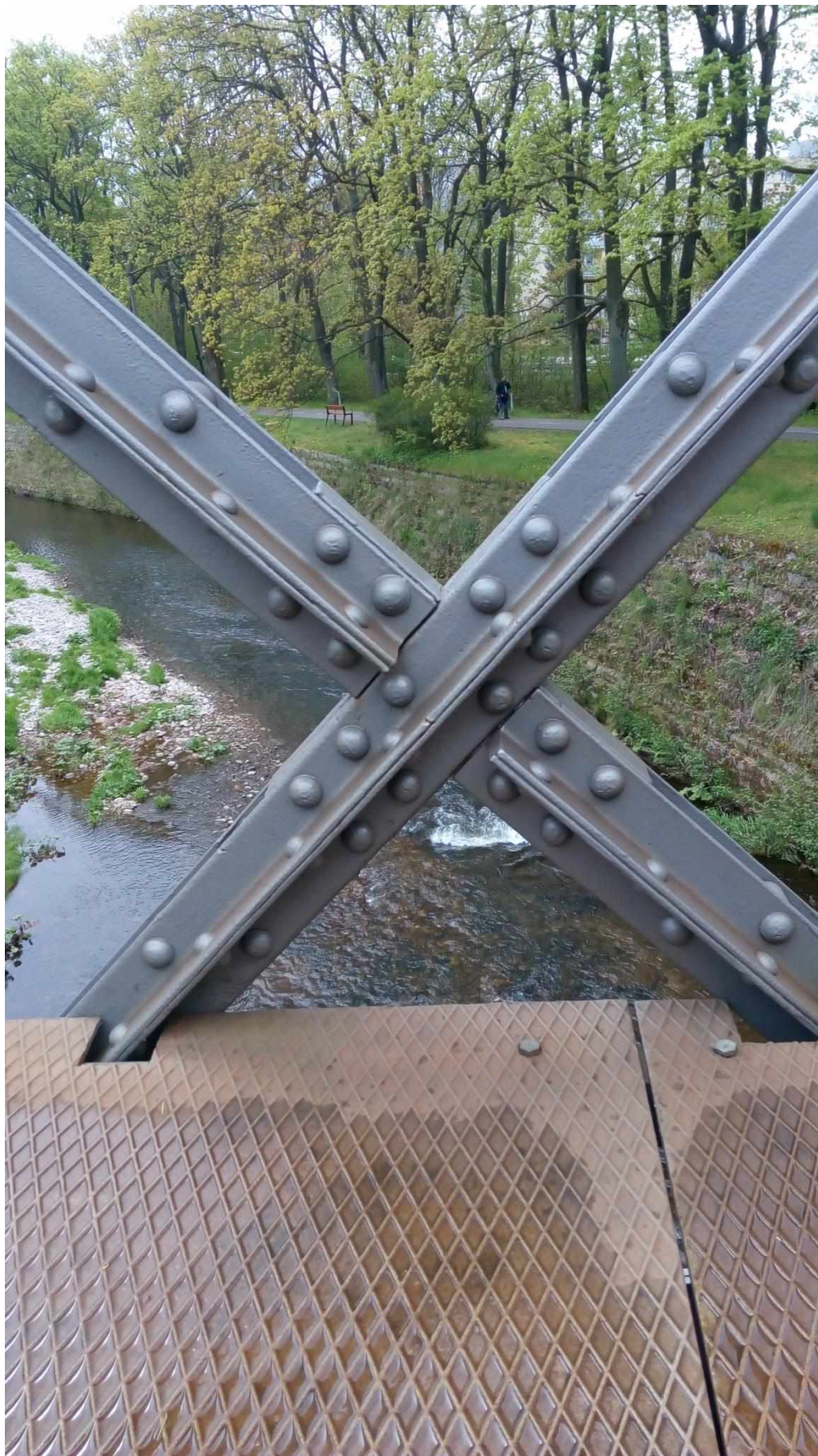
Obrázek 17: Detail křížení diagonál v prostředním poli
