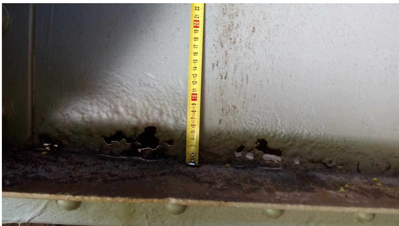
Obrázek 19: Detail největšího oslabení příčniku na opěrou 01 (2)
