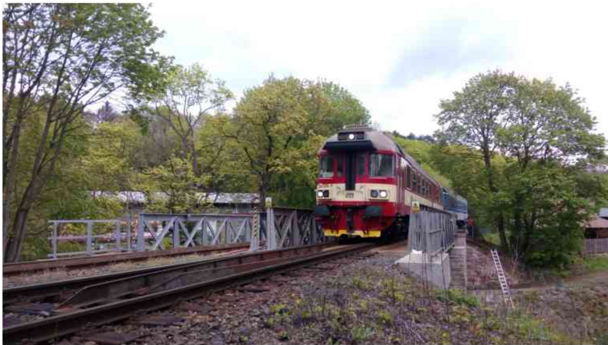
Obrázek 20: Konstrukce zatížená dopravou
