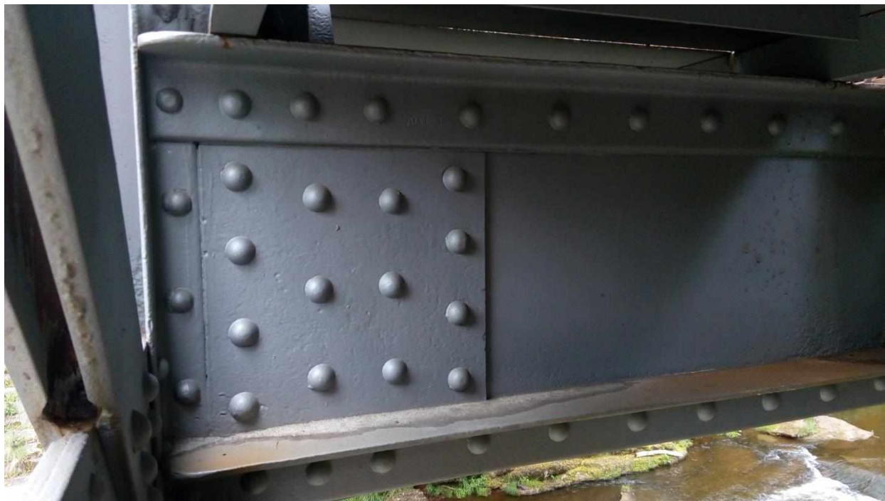
Obrázek 13: Detail připojení příčnicku k hlavnímu nosniku
