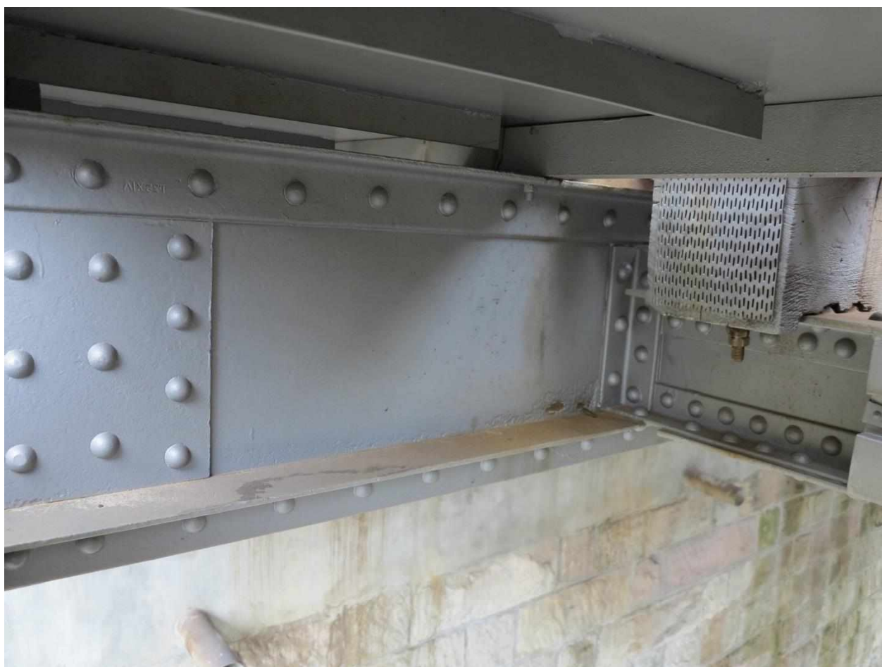
Obrázek 14: Detail připojení podélníku k příčnicku
