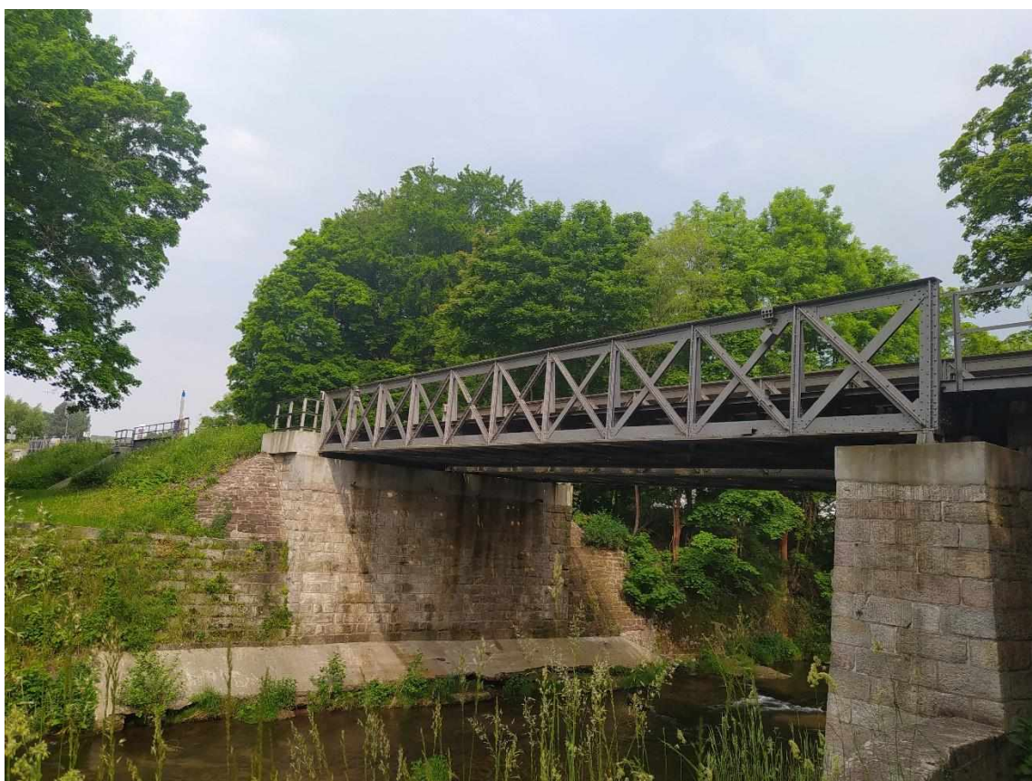
Obrázek 6: Pohled na konstrukci zprava
