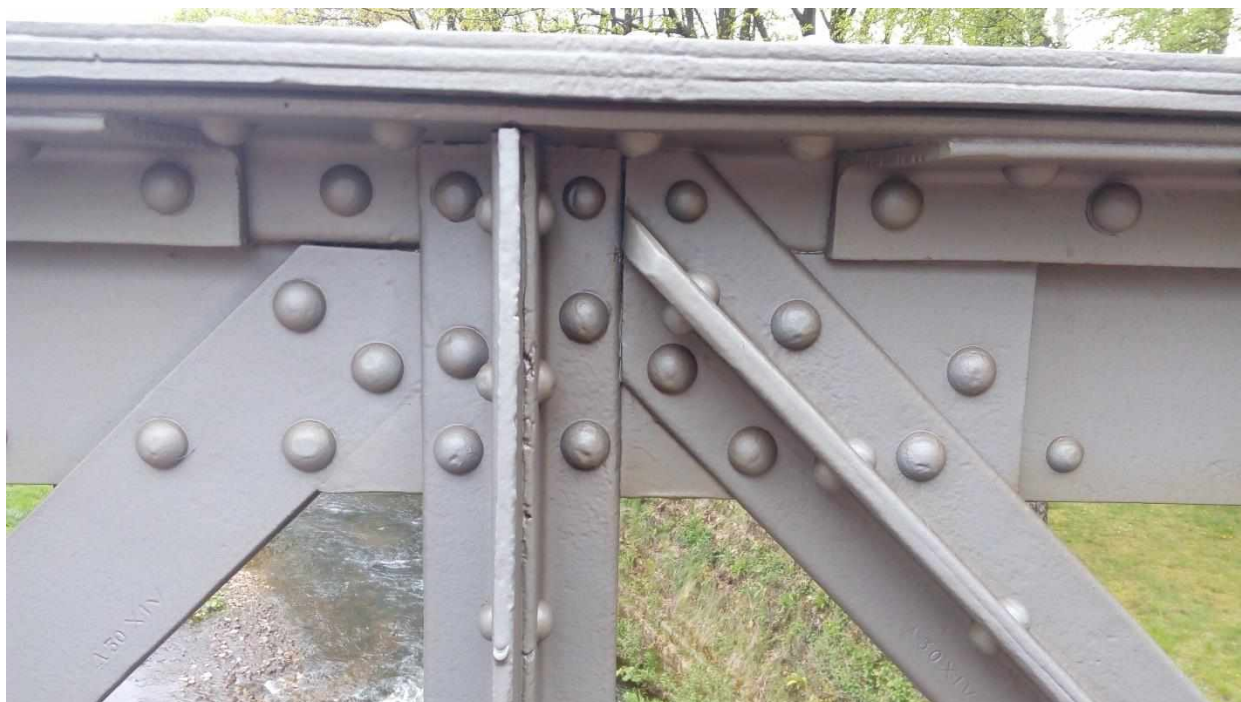
Obrázek 16: Detail styčnicku připojení horního pásu s diagonálami a svislicí
