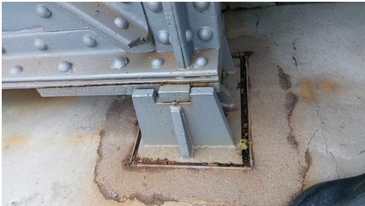
Obrázek 11: Detail pevného ložiska
