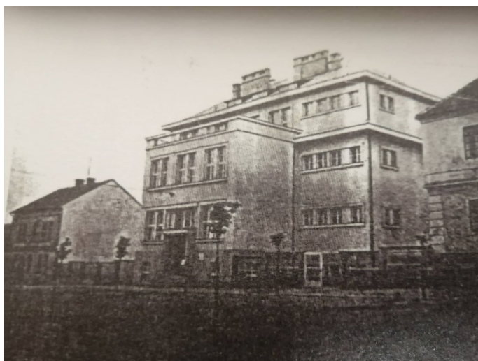
Příloha č. 7: Pohled na novou školní budovu z přední části.
