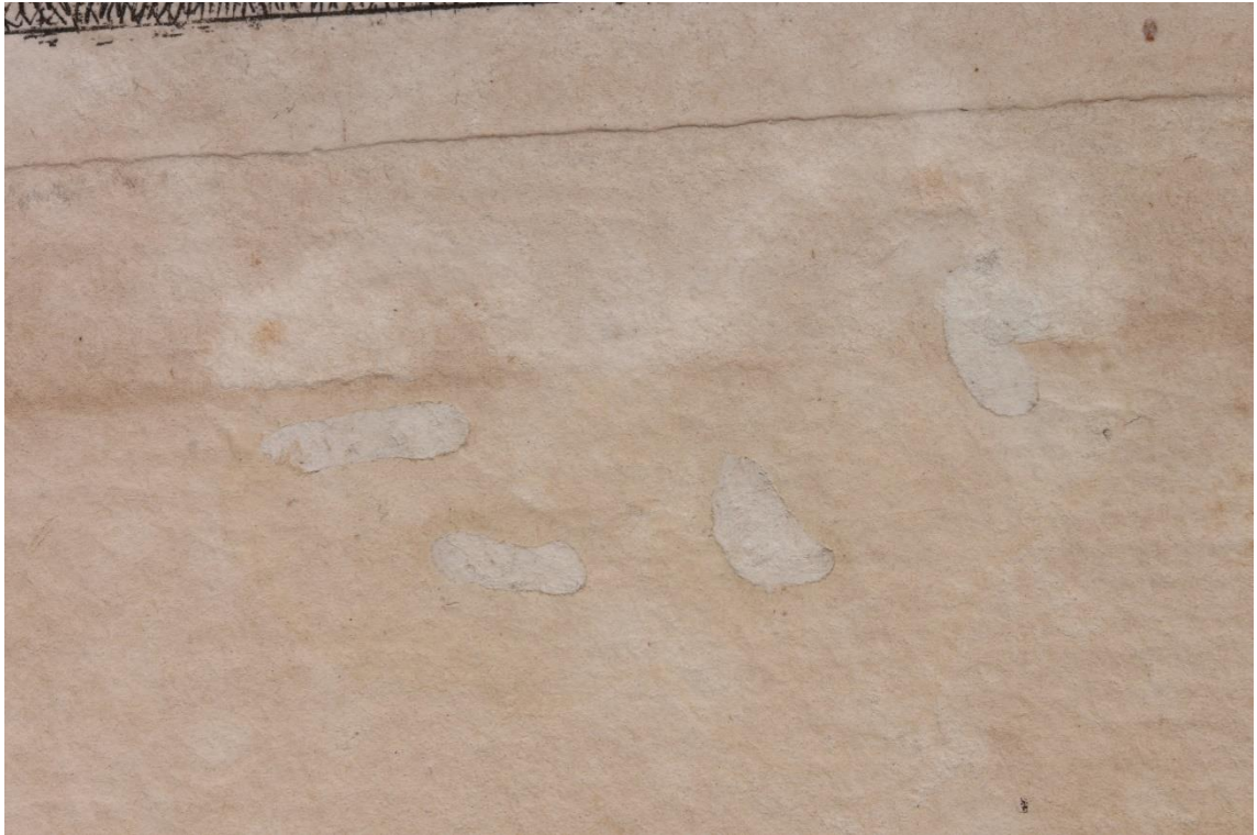
Obr. 21 Detail předchozího restaurátorského zásahu, líc díla
