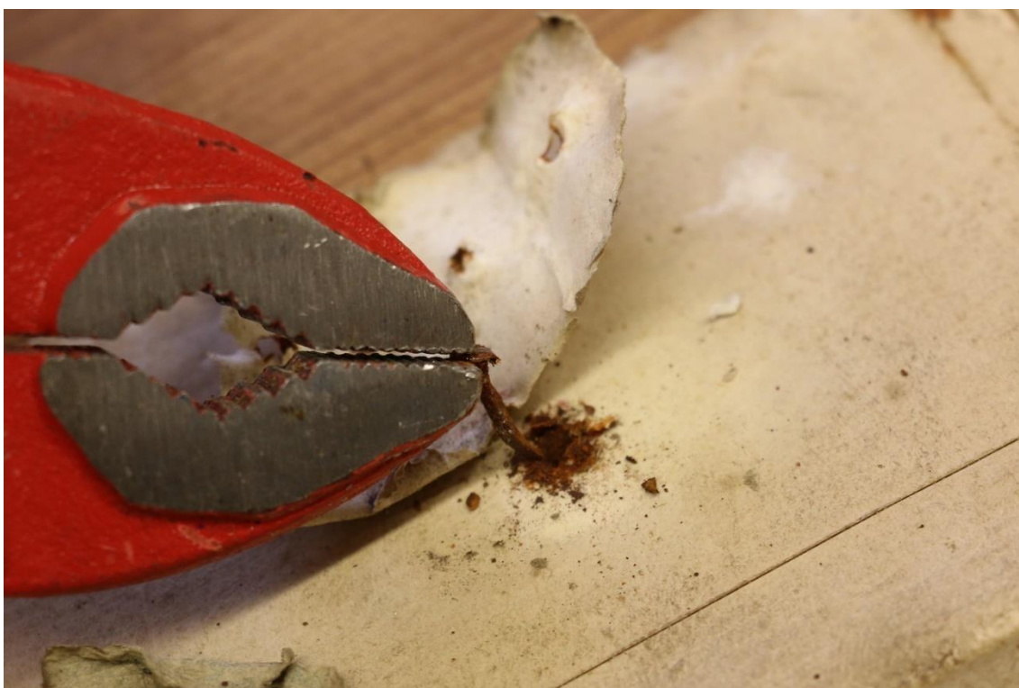
Obr. 139 Odstraňování zkorodovaných hřebíků
