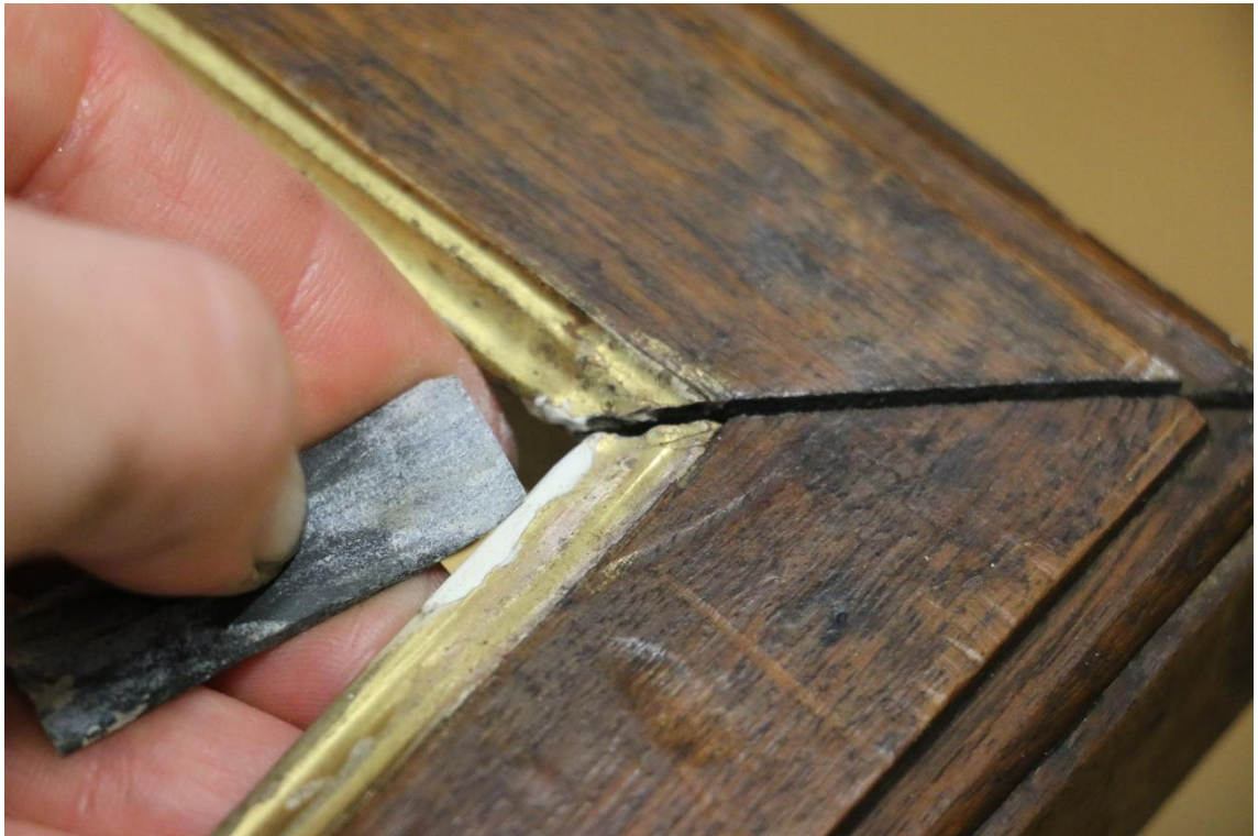
Obr. 157 Broušení tmelů na rámu
