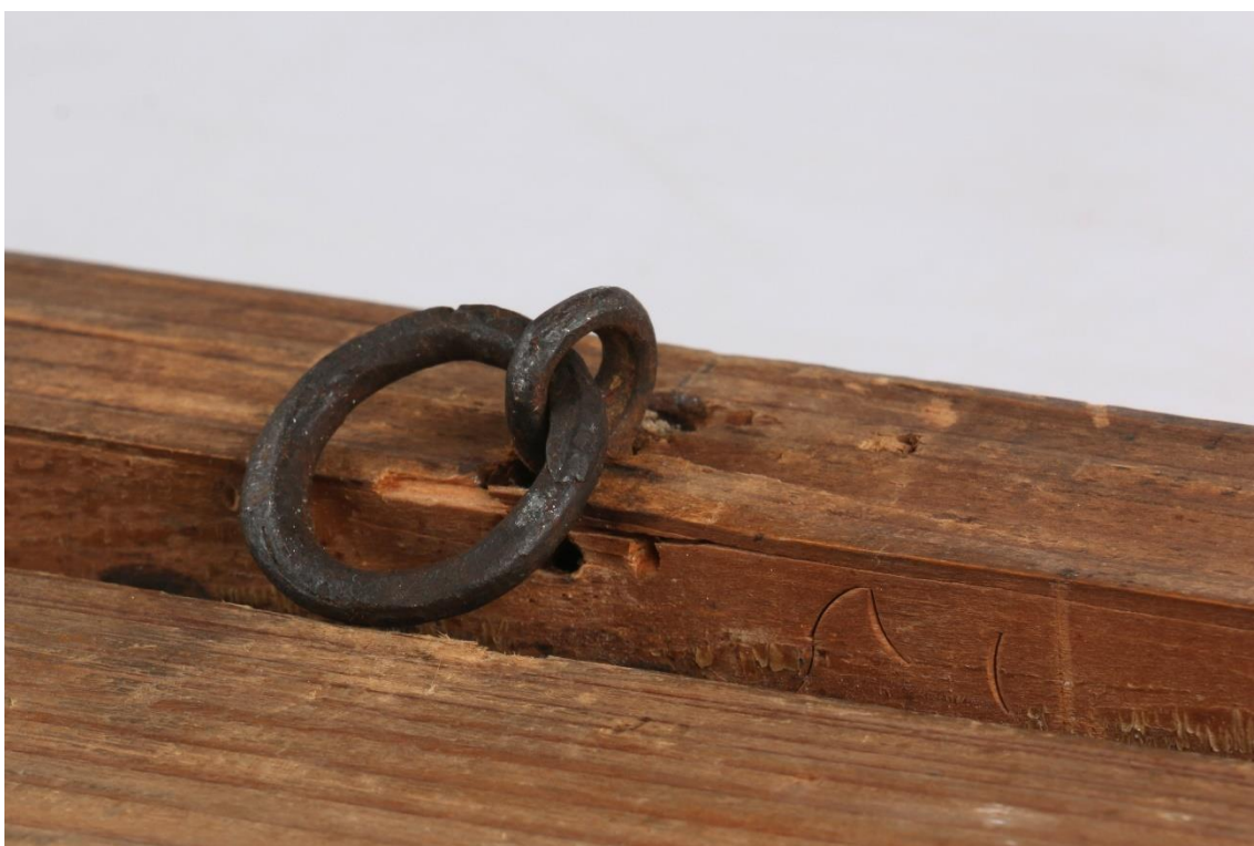
Obr. 67 Detail závěsného systému před restaurováním, rub
