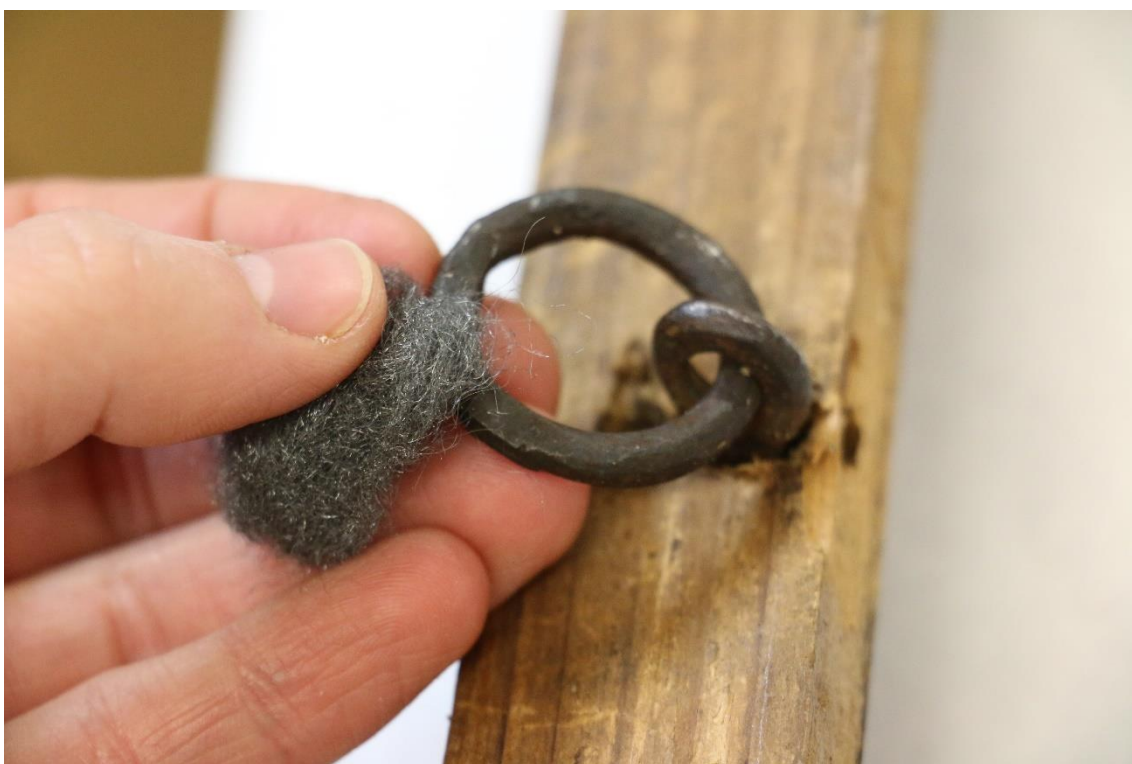
Obr. 103 Odstraňování korozních produktů ocelovou vatou 0000
