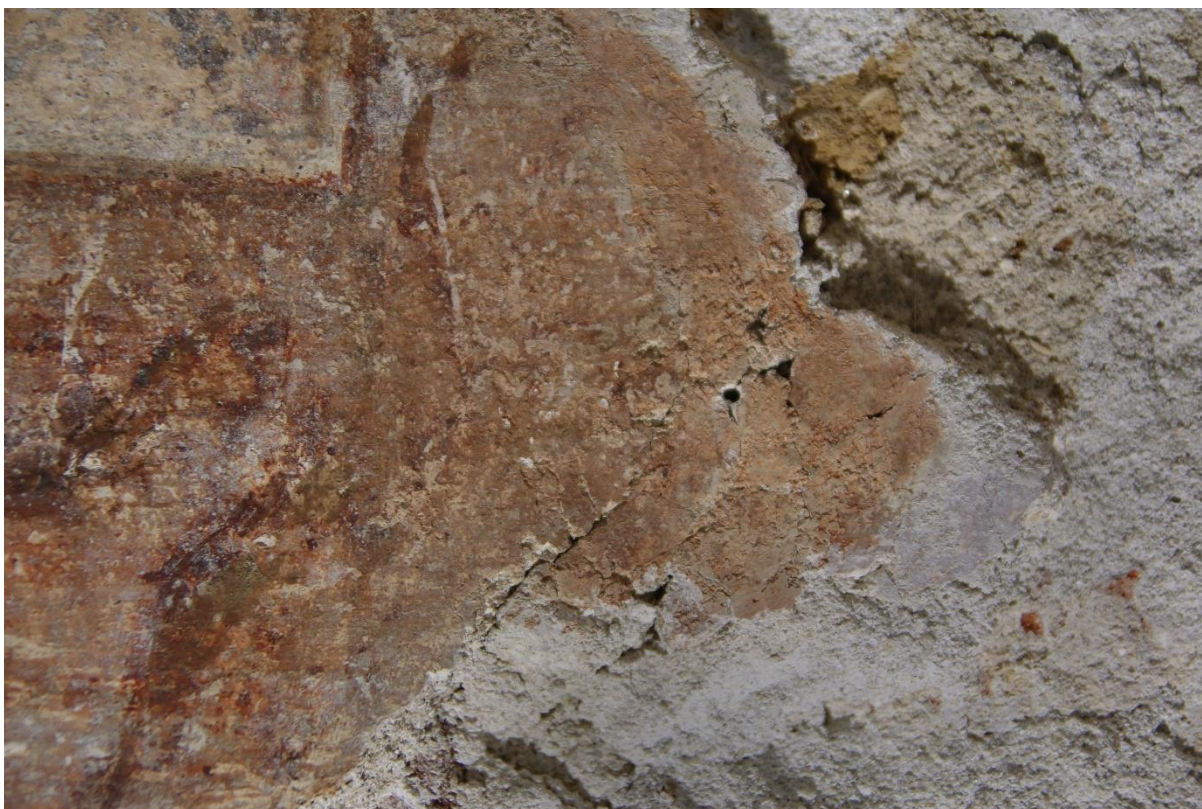
Obrázek č. 27 – Pravá horní část výjevu, odstraňování druhotných nevyhovujících tmelů, přibližně uprostřed místo injektáže z roku 1992.
