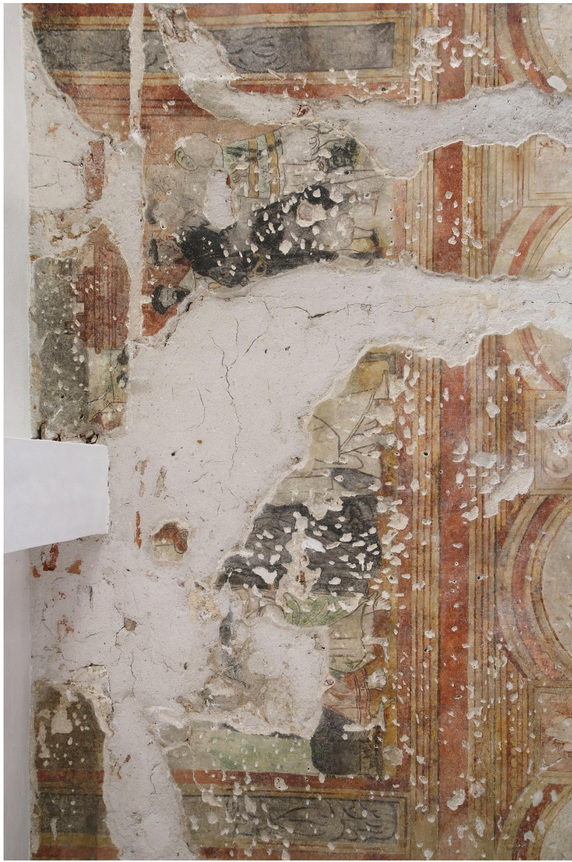
Obrázek č. 34 – Východní stěna místnosti, výjev Uzdravení setníkova syna v Kafarnaum, stav po odstranění druhotných nevyhovujících tmelů a provedení injektáže.
