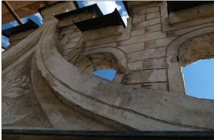
Obr. 186 Intonaco a bianco z restaurátorské opravy provedené roku 1990 na atice - intonaco neprobarvené uhlím a bianco nesoudržné k podkladu.
