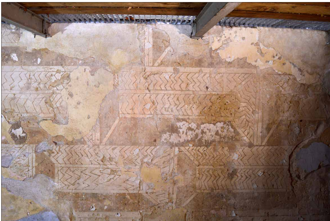
Obr. S23 Fotografie renesančního psaníčka s vertikálně ostře zubatě zalamovanými liniemi.
