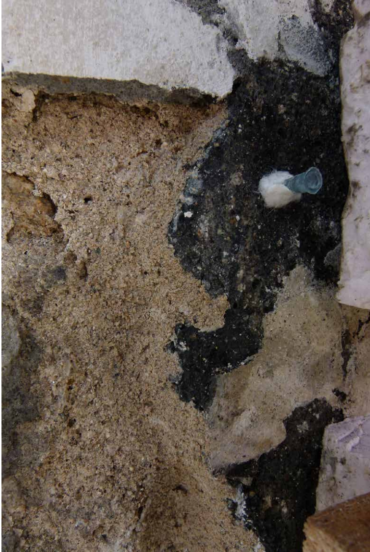
Obr. 107 Detail injektáže původních omítek - obtmelení vápenným tmelem a místo vpichu injektážní jehly.
