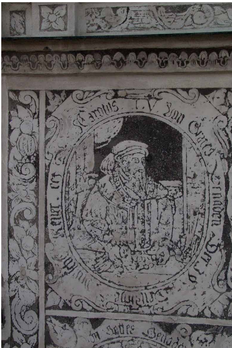
Obr. 49 Vzhledem k rozsáhlému poškození sgrafit v minulosti a četností restaurátorských zásahů je původní kresba a nápisy velmi deformované a často nečitelné. Medailon č.1 - Karel V.
