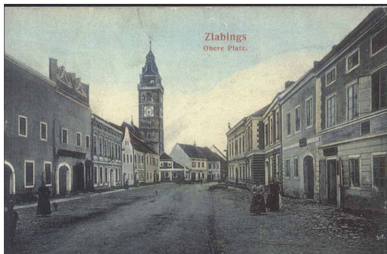
Obr. 9 Pohled na Horní náměstí od brány. Mladší foto (vedlejší domy bez atiky, ještě čtvercové hodiny na věži). Sgrafita jsou zakrytá. Vstup domu v přízemí patrně původní, okna přízemí upravená. ( http://www.slavonice-zlabings.eu )
