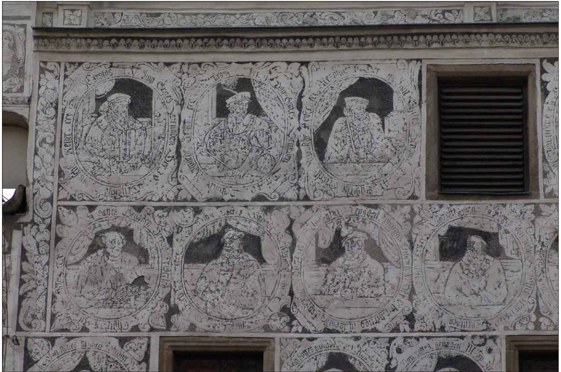
Obr. 91 Levá horní část fasády před restaurováním.
