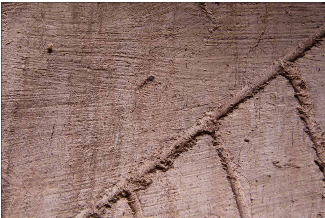
Obr. 215 Bianco je nanесeno viditelně jako nátěr štětkou. Tahy jsou vedeny spíše horizontálními směry.
