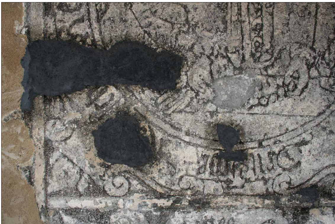
Obr. 119 Detail medailonu č. 1 - Karel V. Habsburský, tmelení intonaca.
