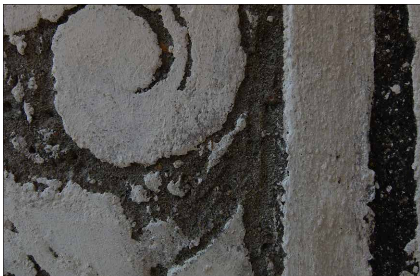
Obr. 184 Intonaco a bianco z restaurátorské opravy provedené roku 1990 - dobře patrný způsob rytí a povrch bianca (hutná vrstva nanesená filcem).
