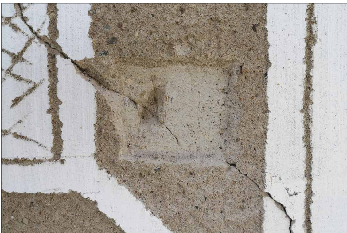
Obr. 270 Detail stratigrafické sondy do novodobých vrstev sgrafita na východní fasádě. Dobře patrný, do hladka stržený povrch jádrové omítky.
