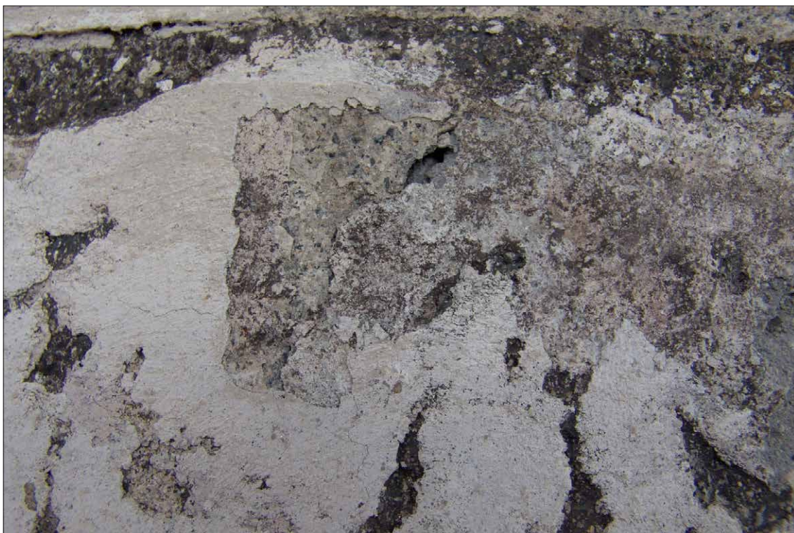
Obr. 48 Původní intonaco je zakryto několika vrstvami druhotných nátěrů (bianco z pozdějších oprav), které jsou nesoudržné. Je patrná černá scelovací lazura, která byla provedena vždy před "evokací" reliéfu v průběhu všech oprav.
