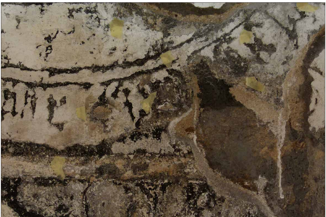
Obr. 108 Část původních omítek po hloubkové injektáži a přitažení k podkladu. Papírová lepenka označuje místa vpichu a aplikace injektážní směsi, pro přesné zakreslení do grafické dokumentace.
