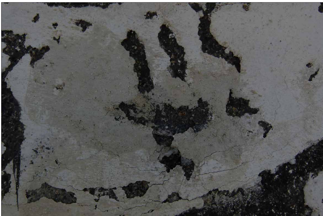
Obr. 190 Zajišťovací zásah provedený v roce 1997. Detail bodového tmelu a retuše modifikovaným vápenným nátěrem (Porokalk).
