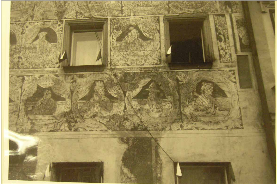
Obr. 33 Stav medailonu v roce 1990. Stav po opravě 1974, těsně před opravou 1990 (Archiv MÚ Slavonice, neutříděno).
