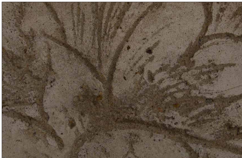
Obr. 188 Intonaco a bianco z restaurátorské opravy provedené roku 1990 na atice - dobře patrný způsob rytí.
