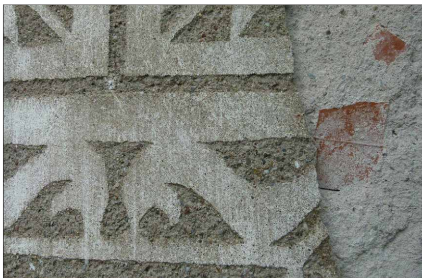
Obr. 237 Poměrně hluboké rytí (cca 1 - 1,5 mm), které má mírně "otřepené" okraje. Hrany odryté plochy jsou také původně hrbolaté, pouze druhotně ohlazené dešti.
