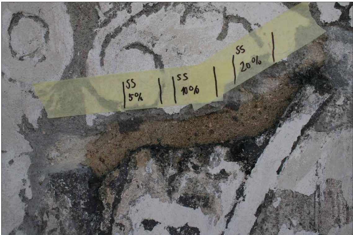
Obr. 66 Zkouška koncentrace Sebosilu S.
