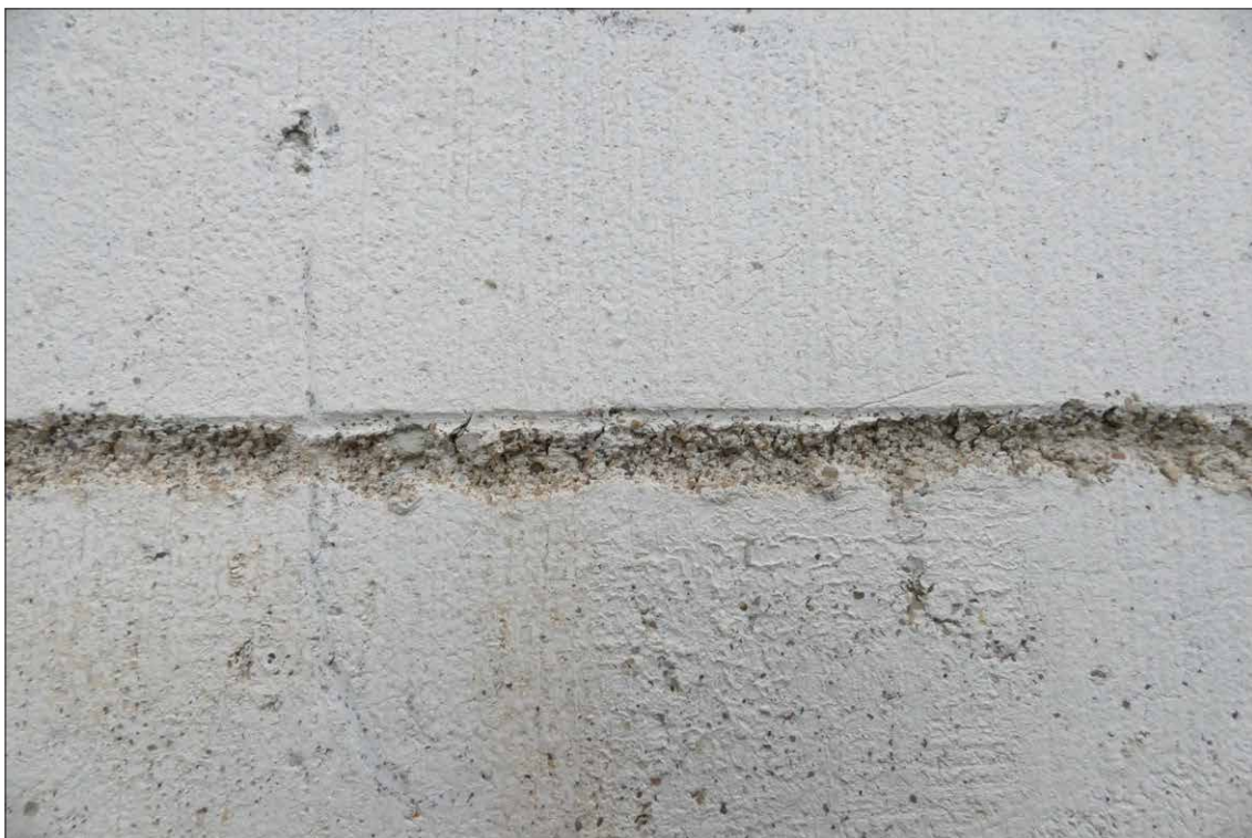
Obr. 277 Detail novodobého sgrafita na východní fasádě. Dobře patrná vtačená rozkresba psaníček.
