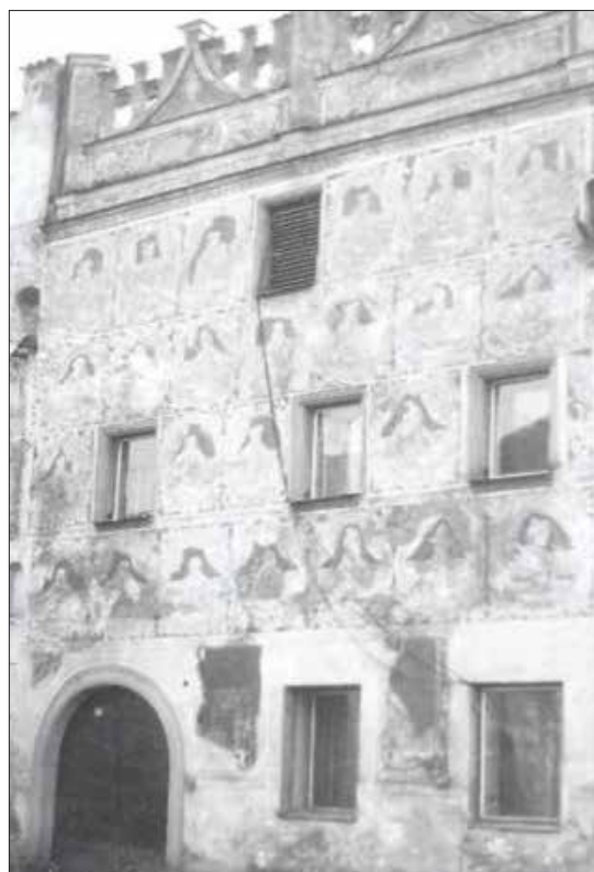
Obr. 15 Pohled na fasádu čp. 536 v roce 1988.
