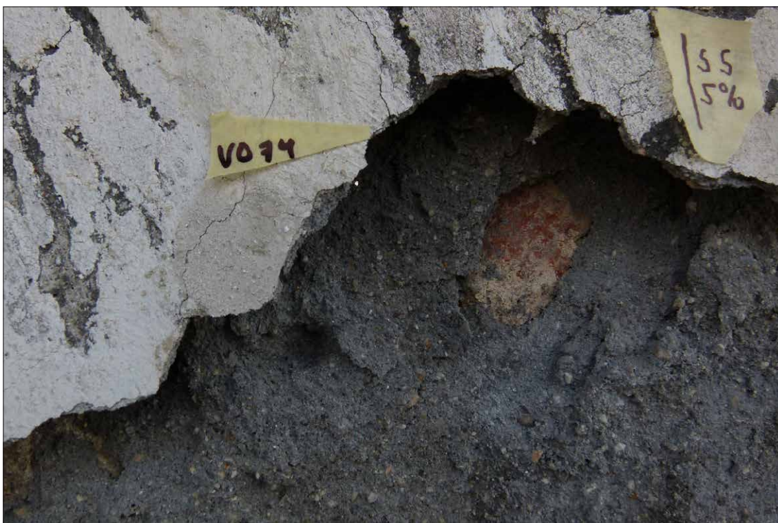
Obr. 181 Intonaco z restaurátorské opravy provedené roku 1974 a místo odběru vzorků VO2 a VO5 pro technologické analýzy.
