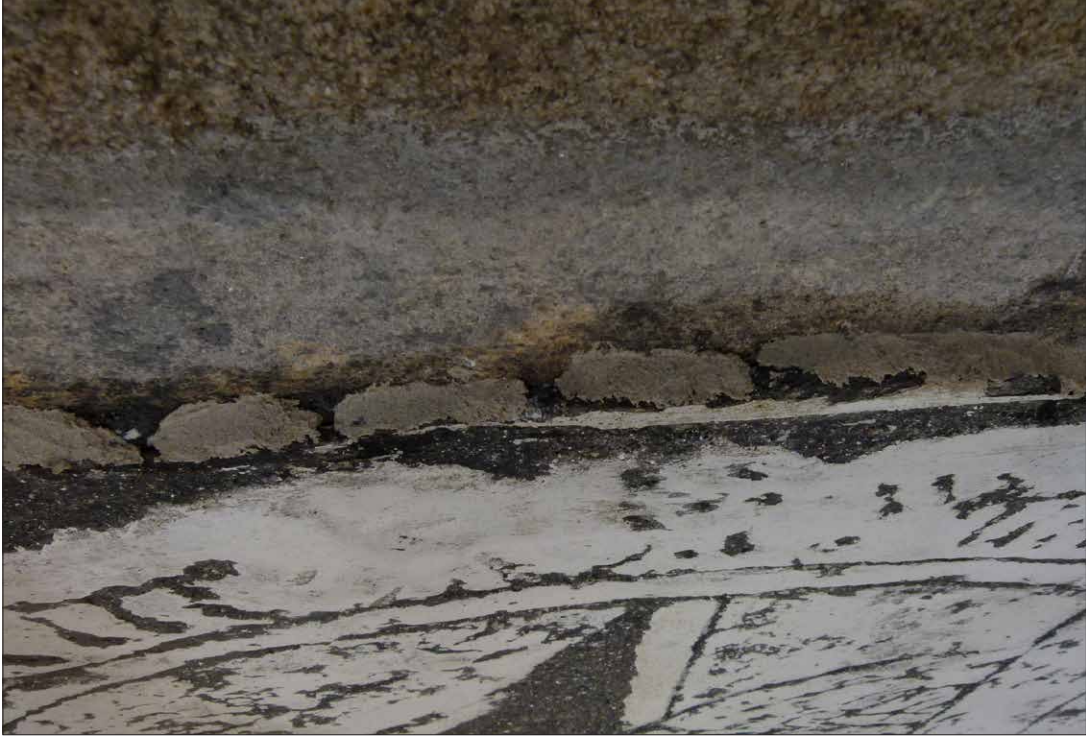
Obr. 103 Průběh injektáže původního intonaca. Obtmele- ní vápenným tmelem s ponechanými otvory pro snadnou aplikaci injektážní směsi.
