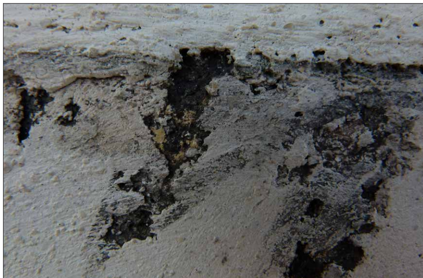
Obr. 176 Fragmenty fasádních nátěrů. Nepatrné nálezy na atice, na vlysu a pod korunní římsou. N5 okrová (oranžová) vrstva na bílém podkladu.
