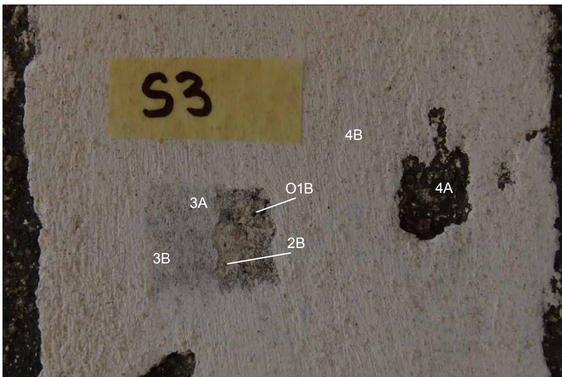
Obr. 39 Detail sondy S3 - O1B intonaco (původní - 80. léta 16. století), 1 bianco chybí, 2B bílá lomená okrem, 3A světle šedá lazura, 3B bílá lomená, silnější vrstva, 4A černá lazura (sjednocující pozadí), 4B bílá silnější.
