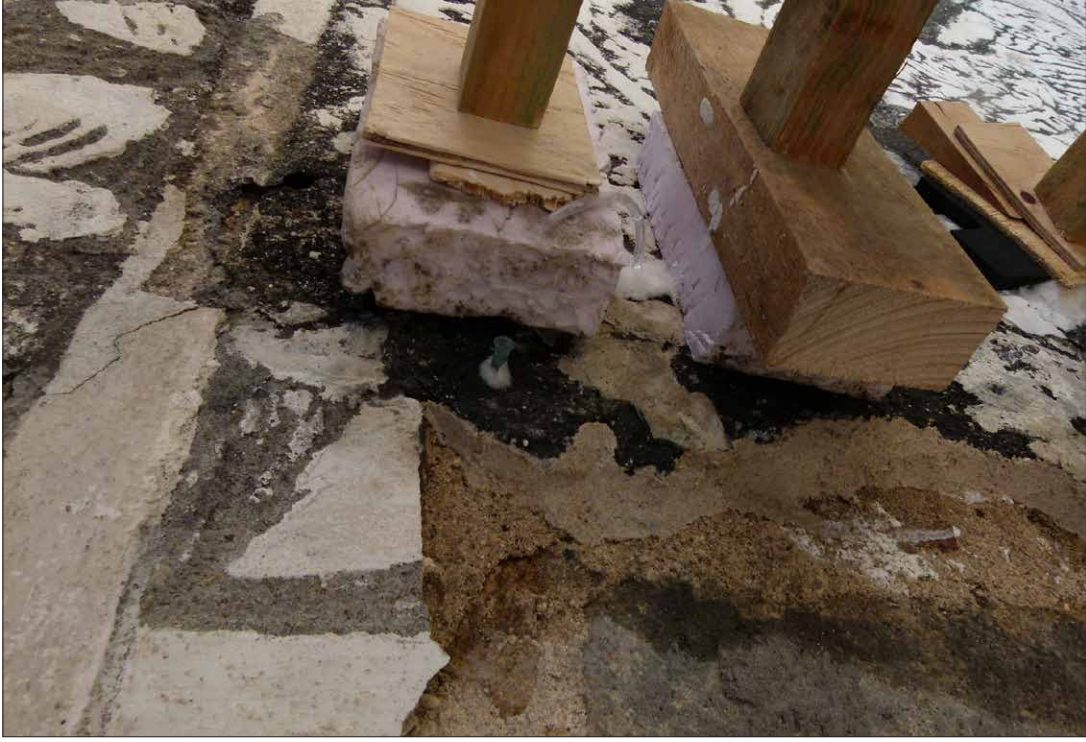
Obr. 105 Detail injektáže původních omítek na horním levém rohu medailonu č. 17.
