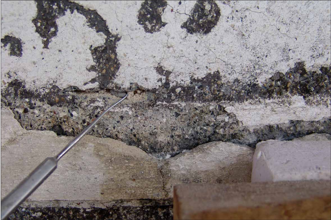
Obr. 99 Detail degradovaného původního intonaca v průběhu hloubkového zpevnění. Odstraňování sypkého jádra a druhotných tmělů zpoza intonaca a položení zpět na podklad (vpravo průběžně tlakováno).
