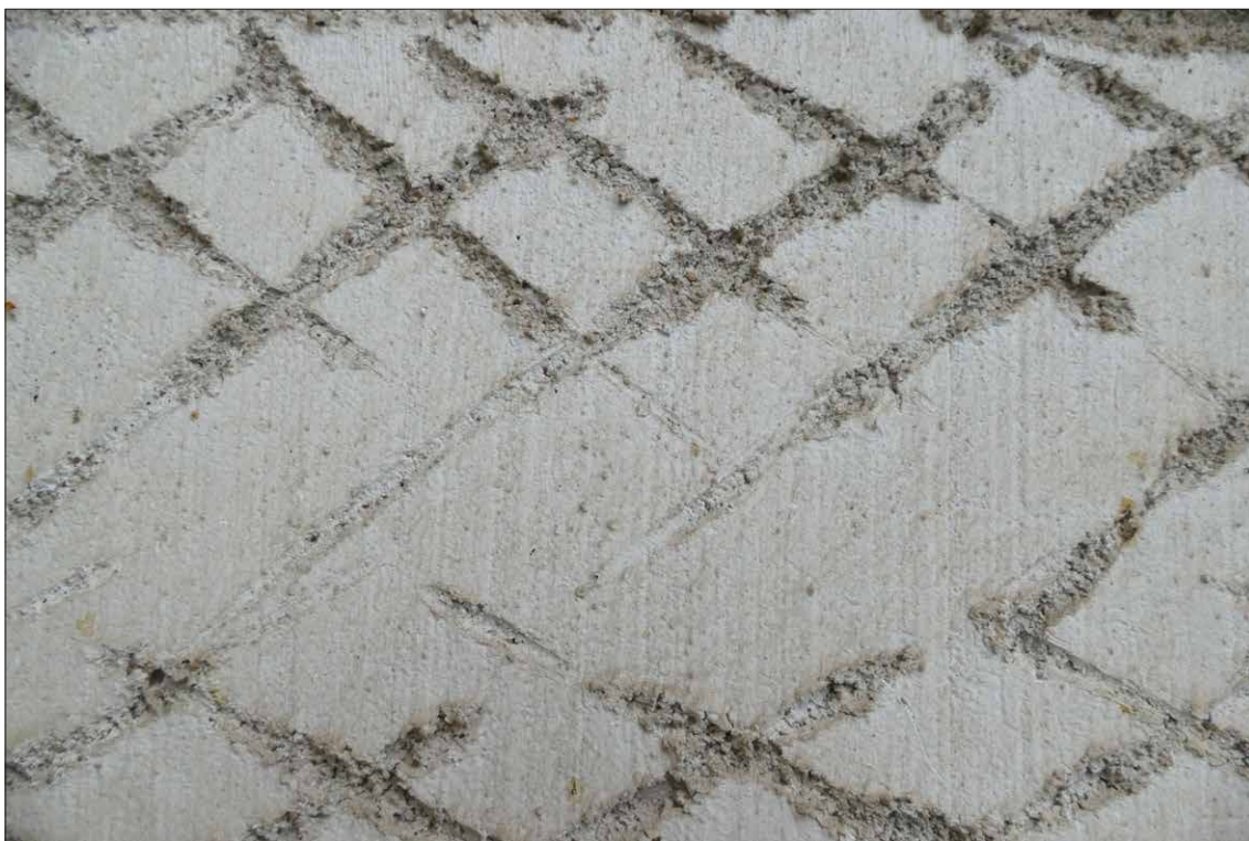
Obr. 276 Detail rytí novodobého sgrafita. Psaníčka na fasádách jsou poměrně rustikálně tvrdě vyrytá s hlubokými linkami s rozštěpenými okraji (docházelo k vytrhávání zrn omítky intonaca).
