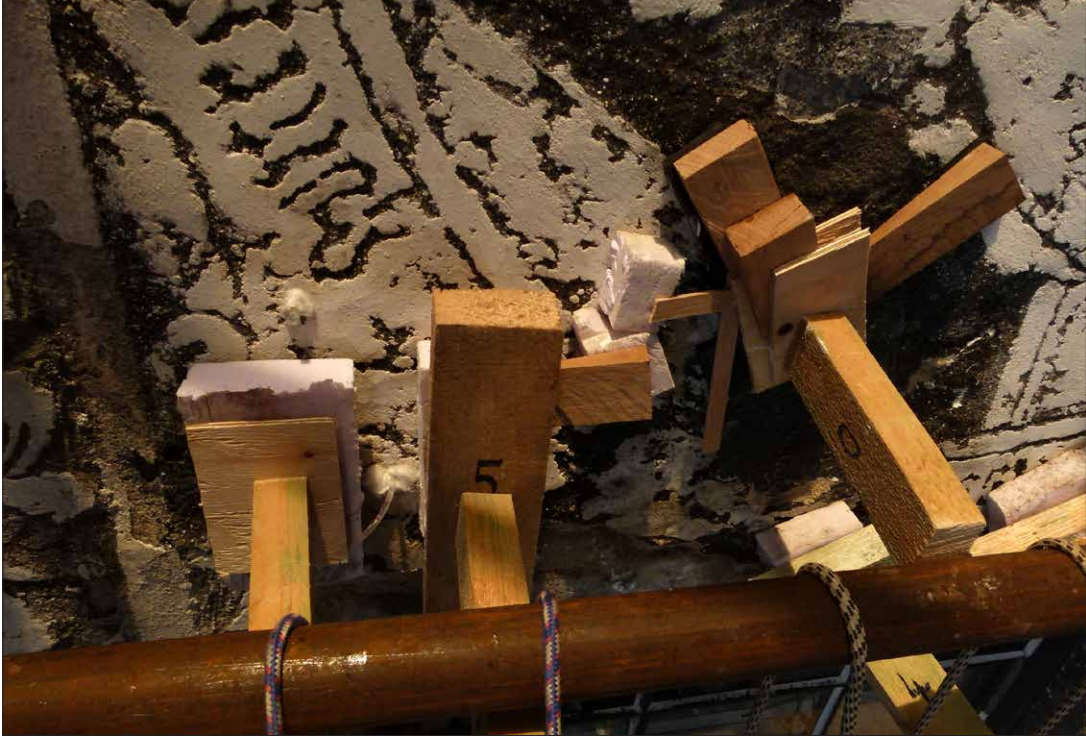
Obr. 106 Pohled na tlakovací mechanismy a průběh injektáže původních omítek na horním levém rohu medailonu č. 17.
