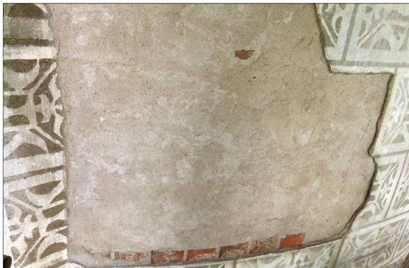
Obr. 232 Jádrová omítka ze 70. let 20. století je světlá, nahnědlá, poměrně tvrdá. Il. nádvoří.
