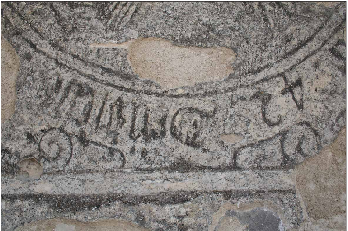
Obr. 124 Detail medailonu č. 4 - Rudolf II. Habsburský, tmelení jádrovou omítkou a retuše bianca na původním intonacu.
