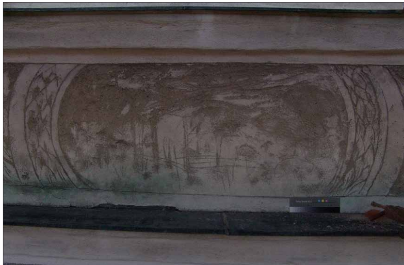
Obr. 187 Intonaco a bianco z restaurátorské opravy provedené roku 1990 na atice - veduta města v oválném medailonu.
