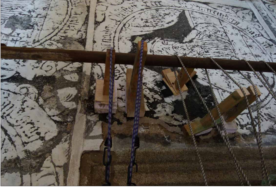
Obr. 104 Průběh hloubkového zpevnění na medailonu č.17.
