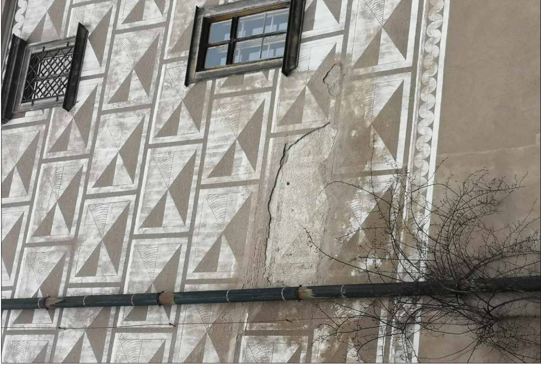
Obr. 210 SZ Náchod. Západní fasáda Piccolominského traktu. Samovolně odhalený fragment původního renesančního sgraffita velikosti cca 2 m 2 .
