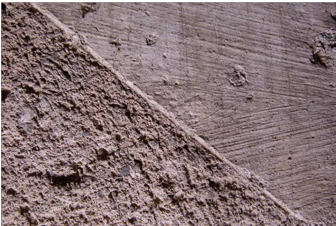
Obr. 220 Způsob rytí. Odrytá plocha versus nátěr bianca. Poměrně tenká vrstva odstraněna, patrně za čerstva.
