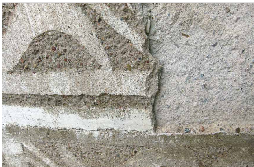
Obr. 234 Omítka intonaca ze 70. let 20. století je světlá, nahnědlá, velmi tvrdá omítka. Il. nádvoří.
