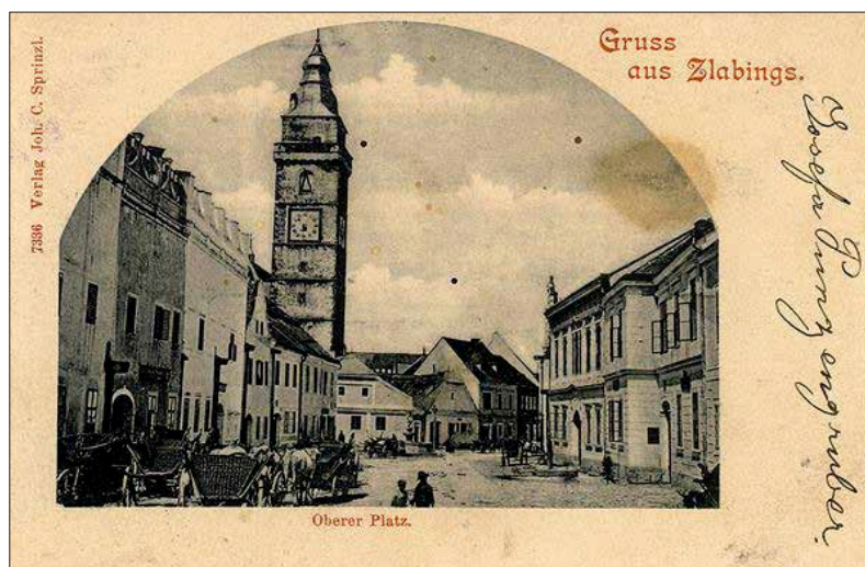
Obr.8 Pohled na Horní náměstí od brány. Nejstarší nalezené foto (vedlejší domy ještě s atikou, čtvercové hodiny na věži). Sgrafita jsou zakrytá. Vstup domu i okna v přízemí patrně původní, okno a chřlív v patře zadržané. ( http://www.slavonice-zlabings.eu )
