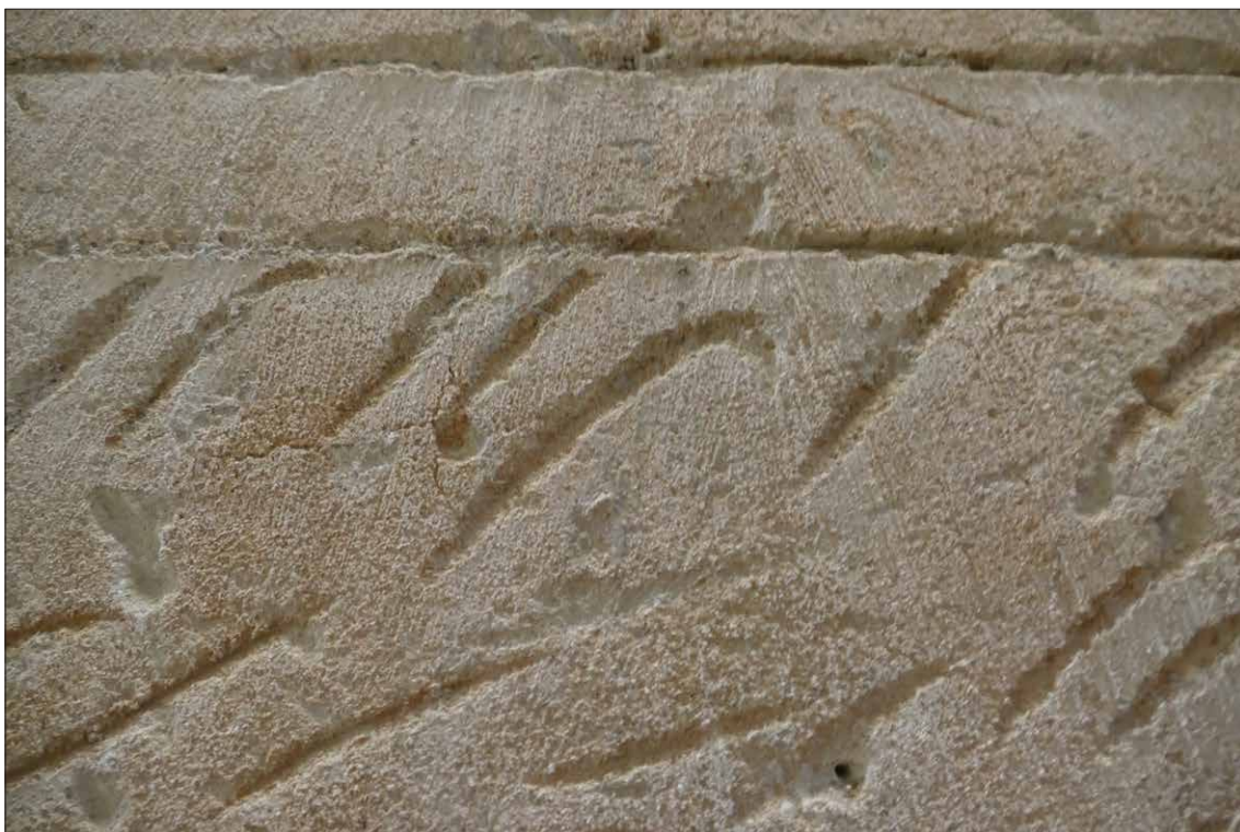
Obr. 268 Fotografie renesančního psaníčka. Šrafura je redukována na nepravidelná věčka. Poměrně razantní, uvolněný rukopis. Hrany nejsou ostré, okraje jsou mírně roztřepené vytrh-lými zrnky písku.
