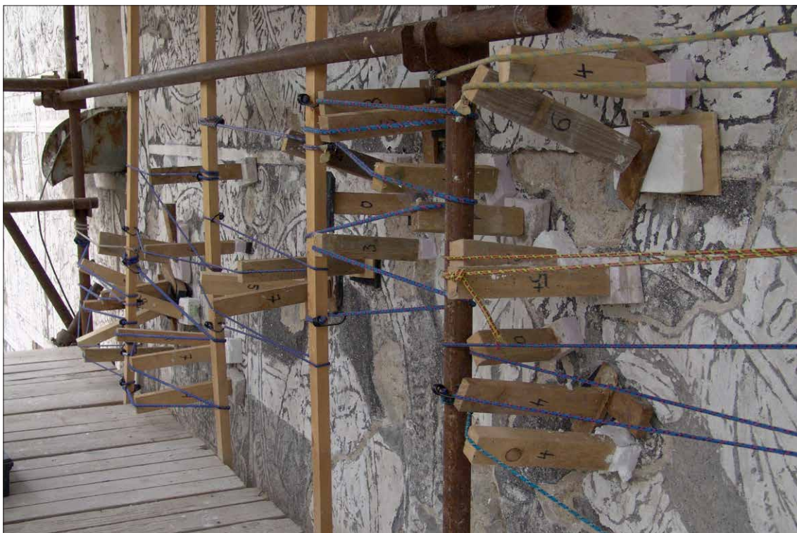
Obr. 109 Pohled na tlakovací mechanismy v průběhu injektáže původních omítek.
