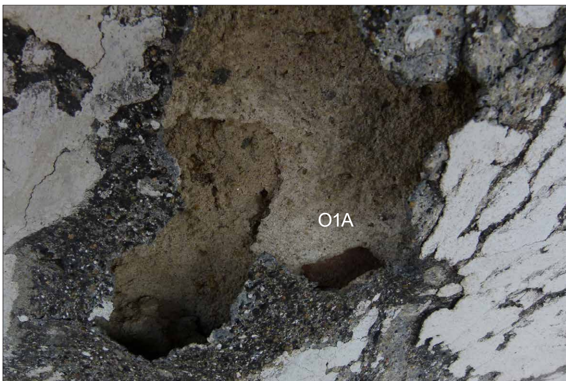
Obr. 42 Detail původní jádrové omítky O1A.
