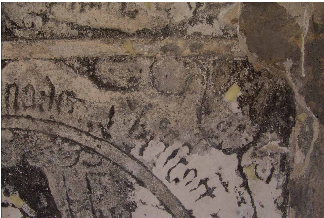
Obr. 111 Horní pravý roh medailonu č. 17 po provedené konsolidaci omítek a v průběhu odkryvu.
