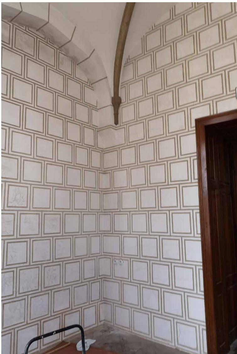
Obr. 269 Pohled do interiéru věže. Rekonstrukce, 90. léta.
