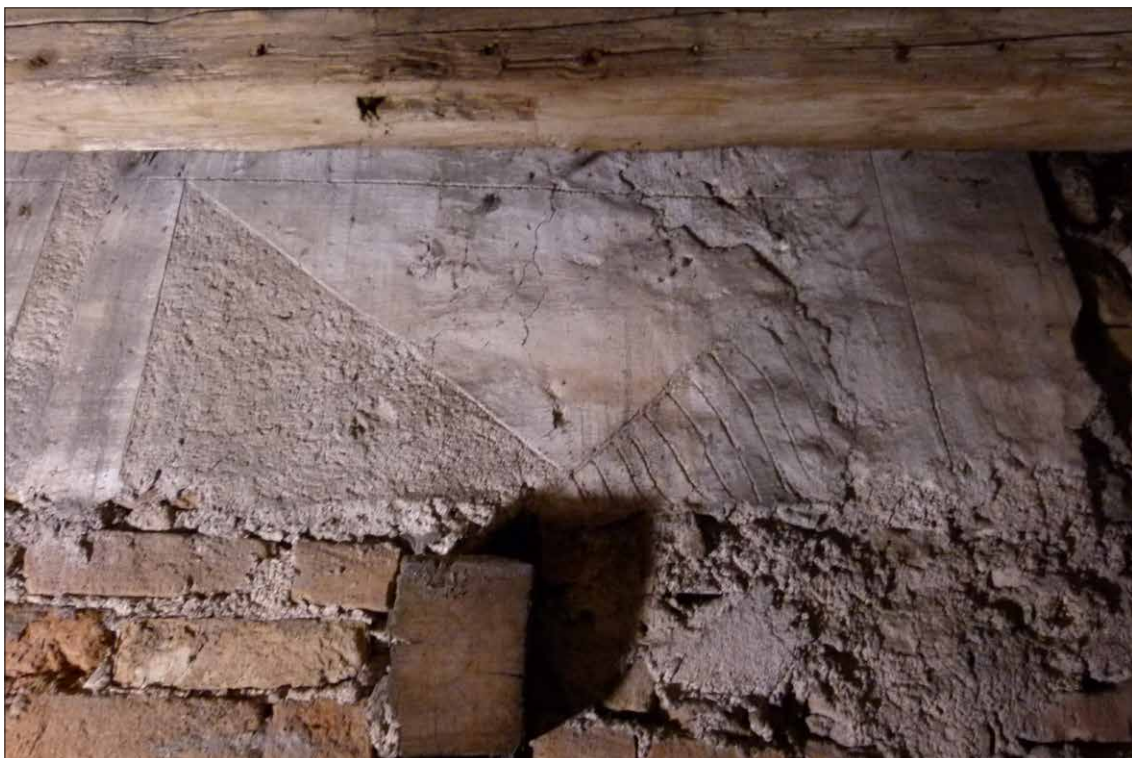
Obr. 217 Na půdě byl pozorován okraj nanesení, rozetření omítky. Dle tohoto fragmentu lze usuzovat, že postup nanášení byl seshora dolů.
