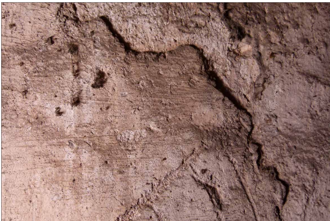
Obr. 218 Detail denního dílu na fragmentu renesanční omítky na půdě.
