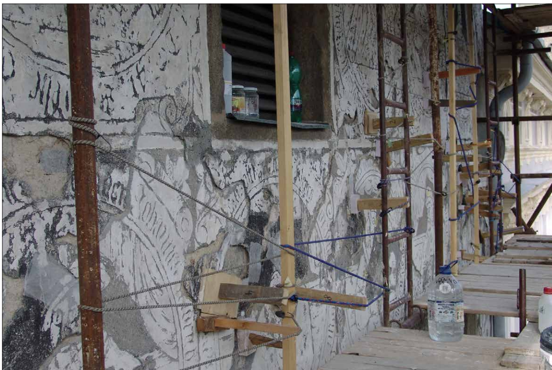
Obr. 67 Zkoušky tlakovacích mechanismů a vyvinutí speciálního způsobu tlakování. K lešení byly přichyceny latě v rozestupu cca 1-1,5 m, mezi nimi byly napnuty silné gumy v potřebné hustotě sítě.
