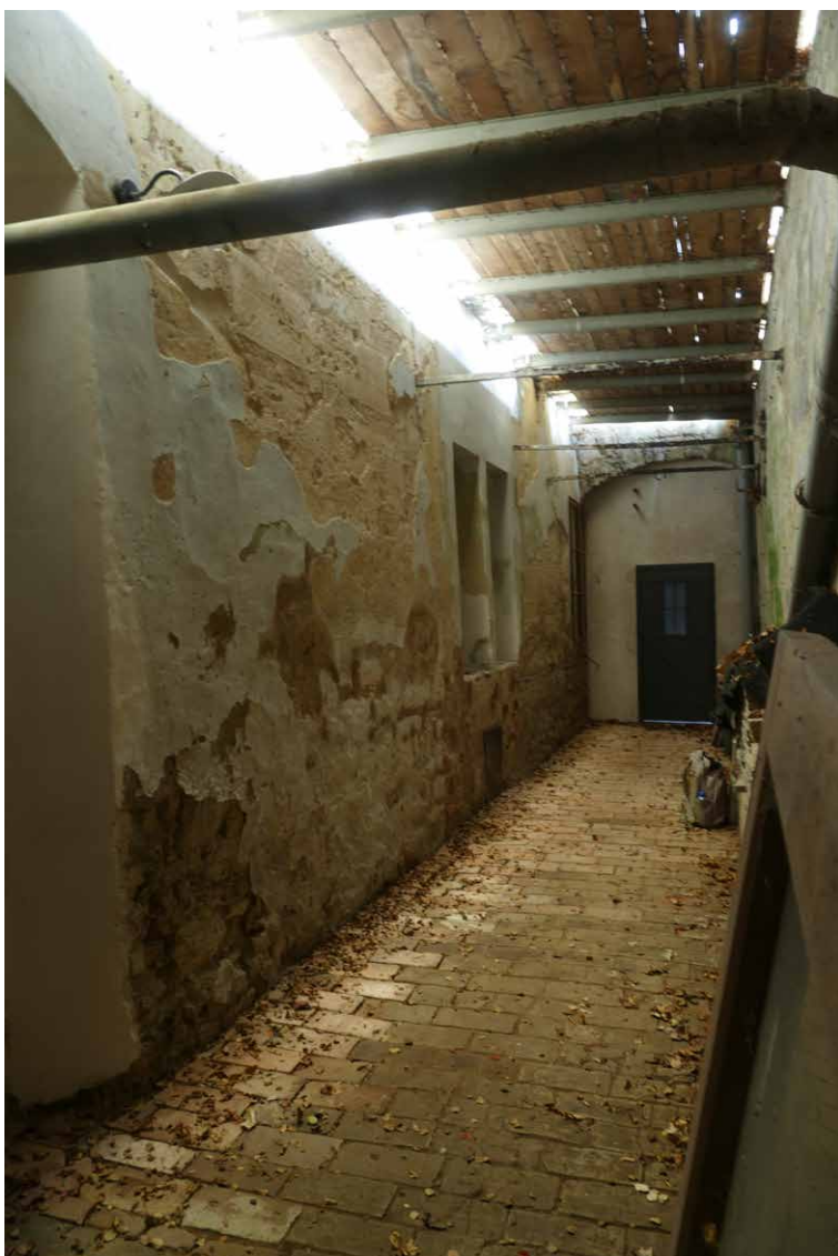
Obr. S8 Slatiňany. Pohled do tzv. anglického dvorku. Na levé části fotografie stěna s dochovanými fragmenty renesančních sgrafit, na původně pohledové jižní fasádě zámku.
