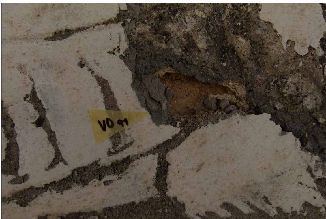
Obr. 182 Intonaco a bianco z restaurátorské opravy provedené roku 1990 a místo odběru vzorků VO6 pro technologické analýzy.
