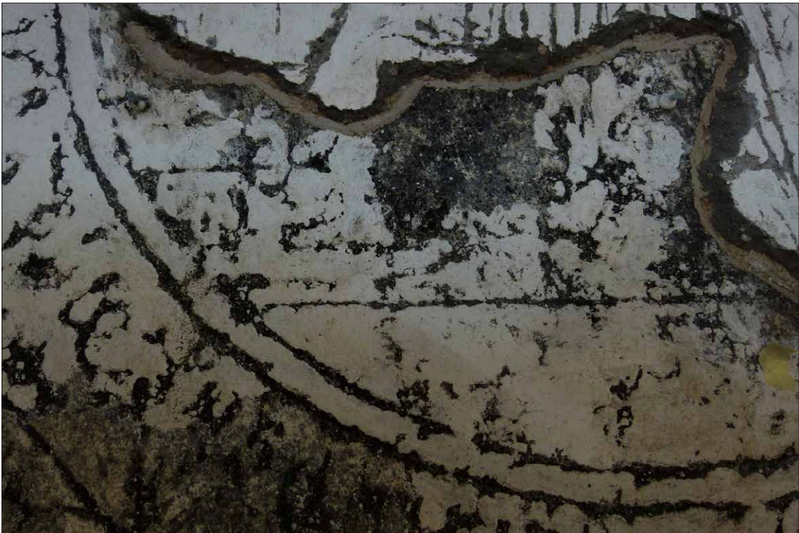
Obr. 100 Nejprve byly odhaleny okraje původních omítek, obtmeleny vápenným tmelem a průběžně konsolidovány.
