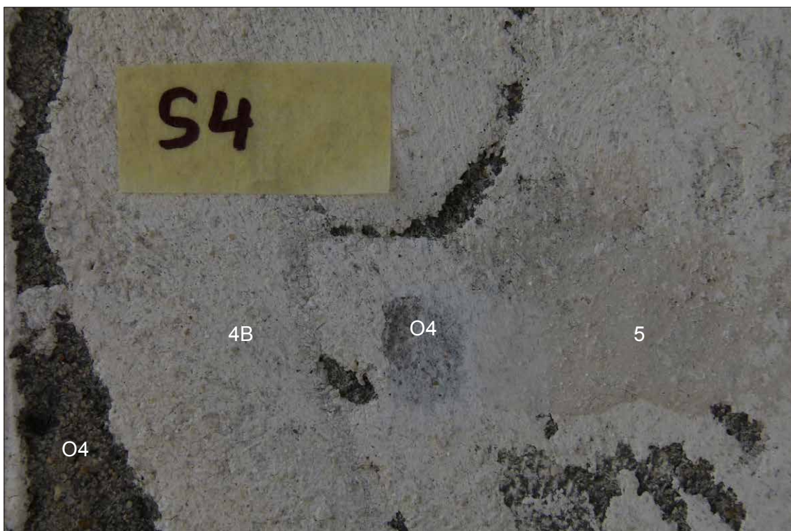
Obr. 40 Detail sondy S4 - O4 světle šedá pevnější malta, 4B bílá silnější, 5 ztmavlá bílá.
