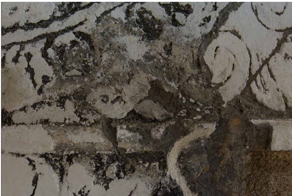
Obr. 101 Detail degradovaného odhaleného původního intonaca v průběhu hloubkového zpevnění. Lokálně obtmelení intonaca vápenným tmelem.
