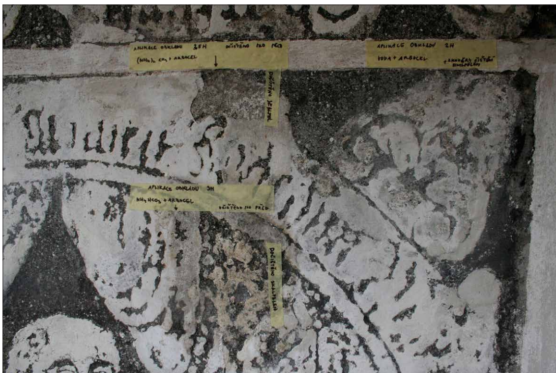
Obr. 63 Zkoušky chemického čištění v obkladu z Arbocelu - voda (2 hod), (\text{NH}_4)_2\text{CO}_3 (3,5 hod), \text{NH}_4\text{HCO}_3 (25 minut, 3 hod), iontoměnič Amberlit 4400OH (5 minut, 20 minut, 30 minut), iontoměnič IR 120H (5 minut, 20 minut, 30 minut) Pouze zábal \text{NH}_4\text{HCO}_3 - 3 hod měl efekt. Zábal druhotné nátěry naměkčil, tak, že je bylo posléze snazší skalpelem odstranit. Ostatní neměli efekt.
