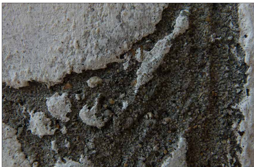
Obr. 183 Intonaco a bianco z restaurátorské opravy provedené roku 1990 - dobře patrná struktura intonaca a bianca.
