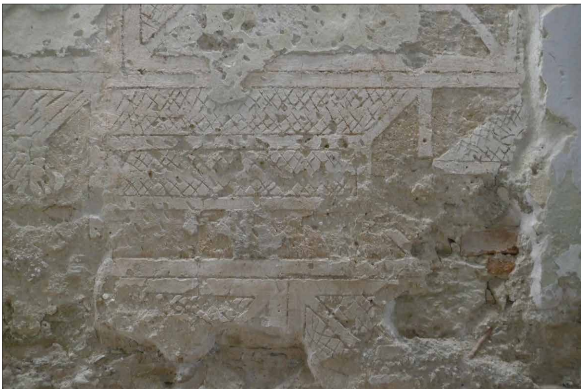
Obr. 265 Fotografie renesančního psaníčka s křížovou šrafurou.
