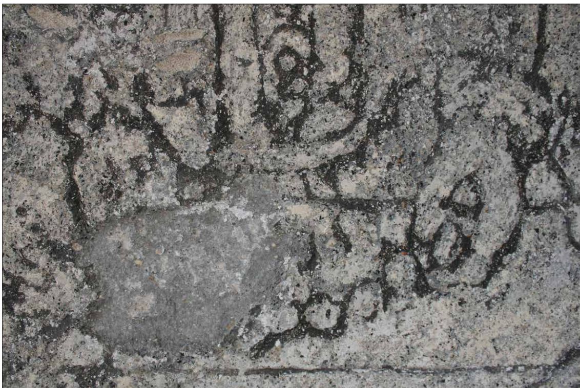
Obr. 121 Detail medailonu č. 1 - Karel V. Habsburský, tmelení intonaca (provedeno rytí).
