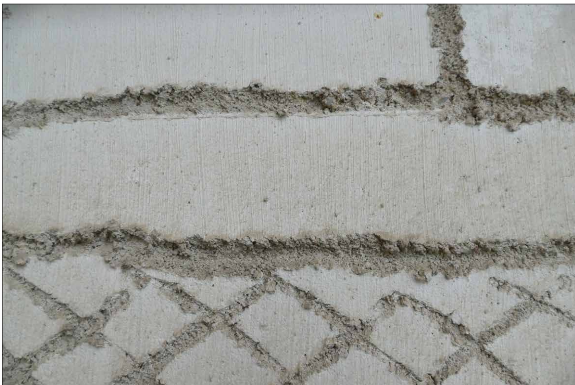
Obr. 273 Fotografie detailu novodobého psaníčka východní fasády z opravy roku 1990. Bianco s viditelnými vertikálními stopami štětce.
