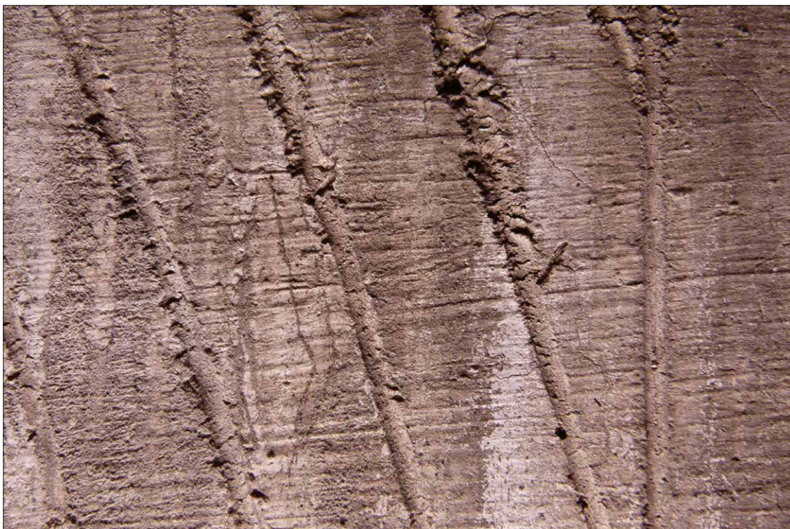
Obr. 219 Způsob rytí. Jedná se o poměrně hluboké rytí (cca 2 mm), respektive spíše vtlačení nástroje. Linka není hladká, ale má mírně "otřepené" okraje.
