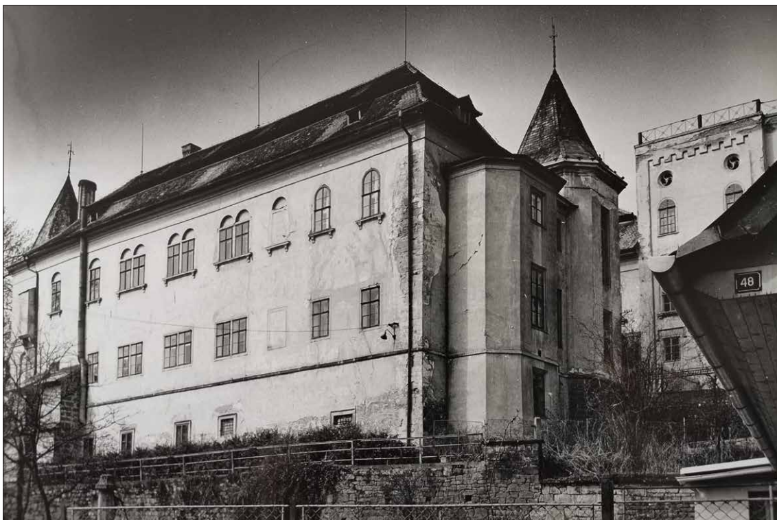
Obr. 245 Pohled na severní část východního křídla s přístavkem. Foto 1978. Archiv kastelána Jaroslava Bušty, SZ Slatiňany.
