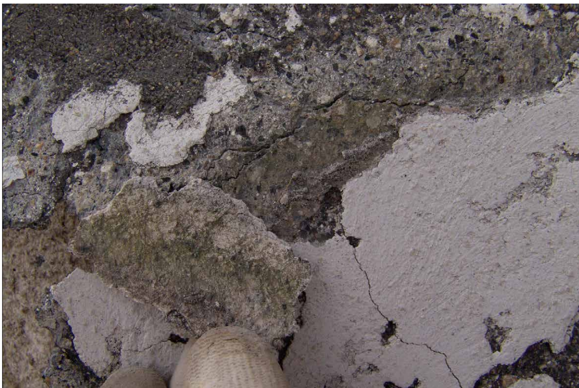
Obr. 61 Lokálně bylo identifikováno biologické poškození - bakterie, řasy...
