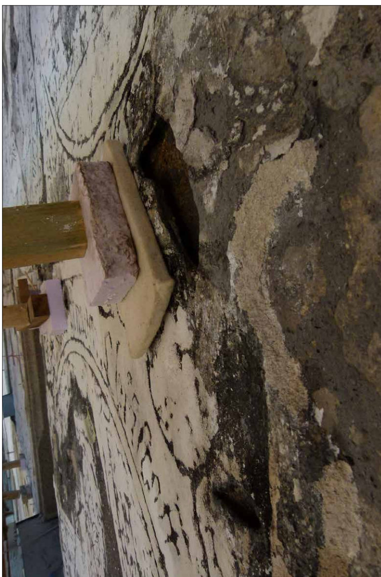
Obr. 101 Detail degradovaného odhaleného původního intonaca v průběhu hloubkového zpevnění. Lokálně obtmelení intonaca vápenným tmelem.
