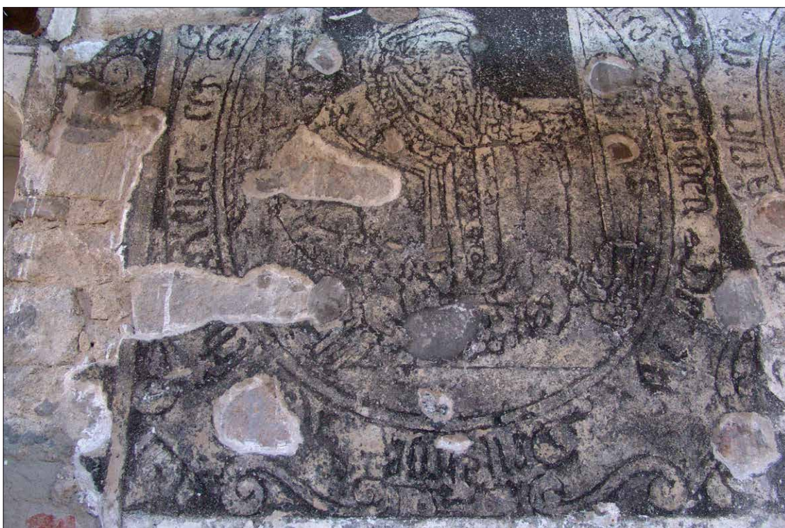
Obr. 114 Medailon č. 1 - Karel V. Habsburský, v průběhu retuší bianca na původním intonacu (příprava na tmelení větších defektů).
