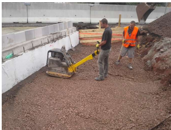
Obr. 31 – Hutnění zásypu za opěrou
