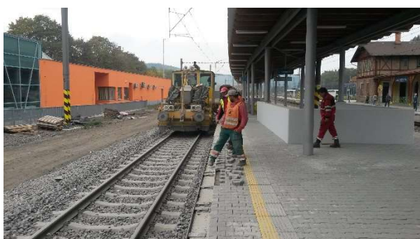
Obr. 93 – Uvedení koleje do původního stavu
