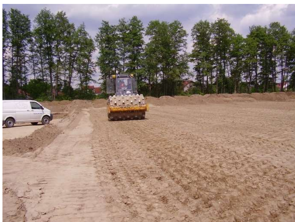
Obr. 66 – Hutnění vrstvy zeminy
