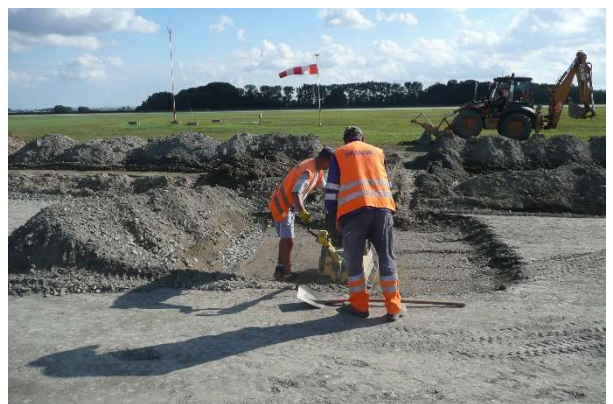
Obr. 77 – Sanace zemní pláně
