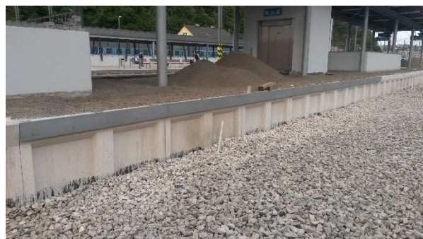
Obr. 90 – Odřezaná a nově namontovaná hrana
