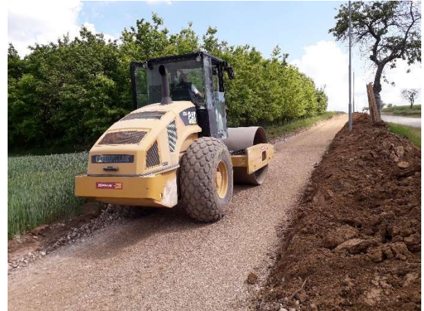
Obr. 53 – Hutnění upravené zemní pláně
