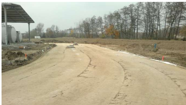
Obr. 70, 71 – Zhutněná a upravená zemní pláně areálových komunikací
