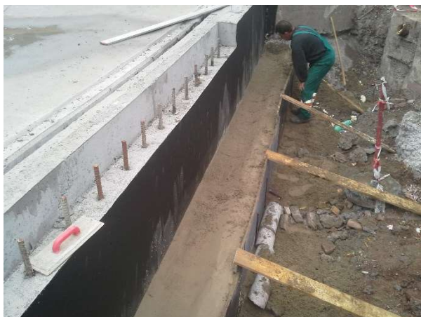
Obr. 34 – Podkladní beton pod drenáž
