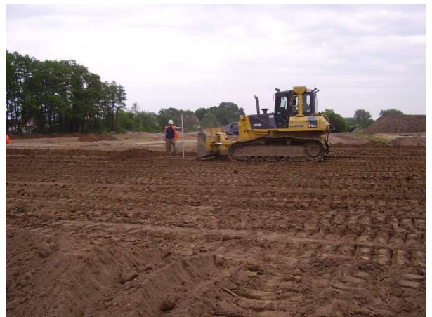
Obr. 65 – Rozhrnování zeminy a kontr. tl. vrstvy
