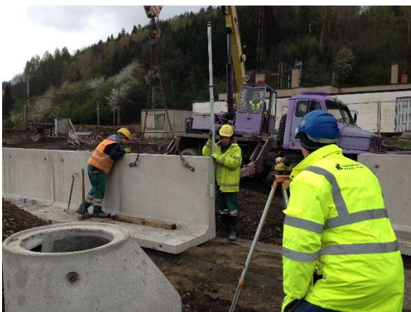
Obr. 83 – Pokládka nástupištních prefabrikátů
