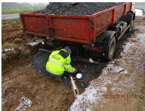
Obr. 49 – Ověřovací stat. zk. na vrstvě štěrkodrtě
