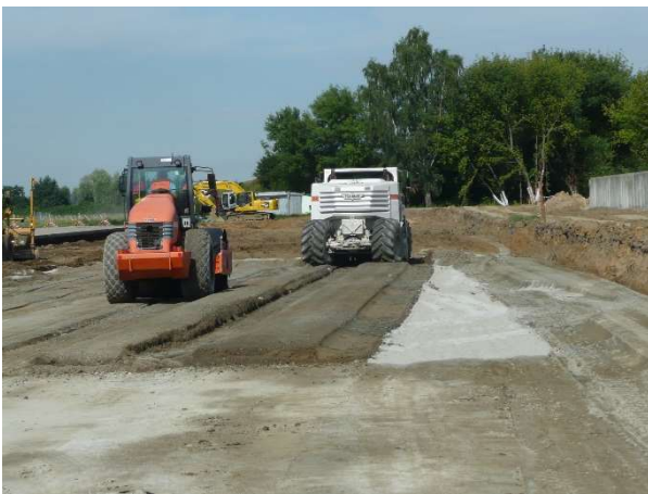
Obr. 74 – Vápnění a hutnění zemní pláně APN
