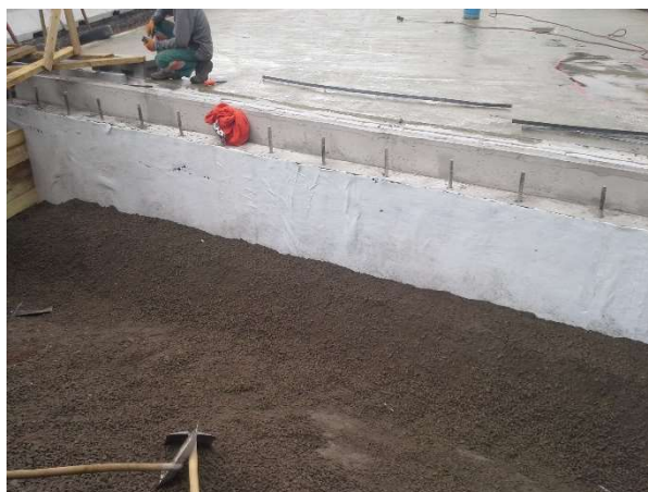
Obr. 35 – Drenážní vrstva (mezerovitý beton)
