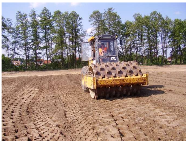
Obr. 58 – Hutnění vrstvy zeminy
