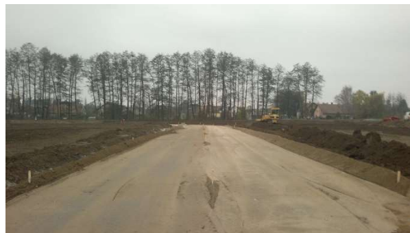
Obr. 70, 71 – Zhutněná a upravená zemní pláně areálových komunikací
