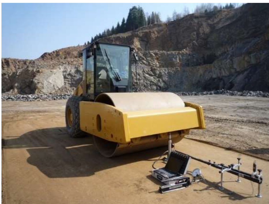
Obr. 25 – Statická zatěžovací zkouška [10]
