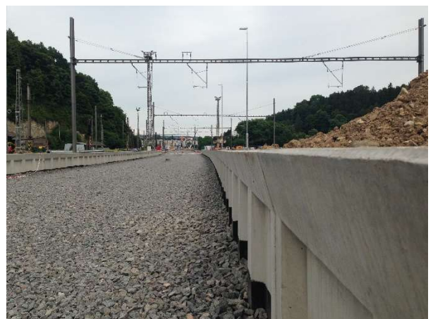
Obr. 84 – Nástupiště včetně kolejového lože
