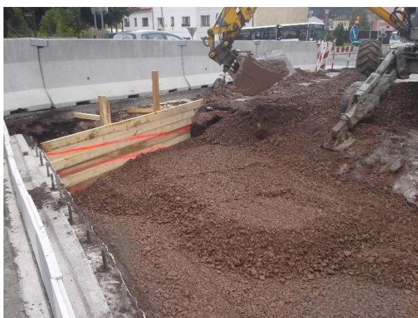
Obr. 32 – Zásyp za opěrou (jednotlivé vrstvy)
