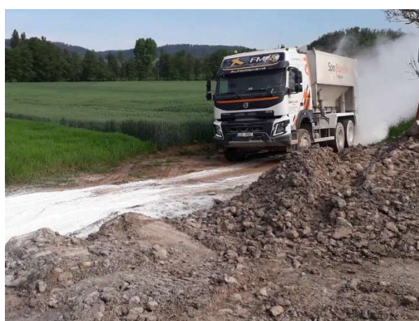
Obr. 51 – Dávkování vápna pomocí distributoru
