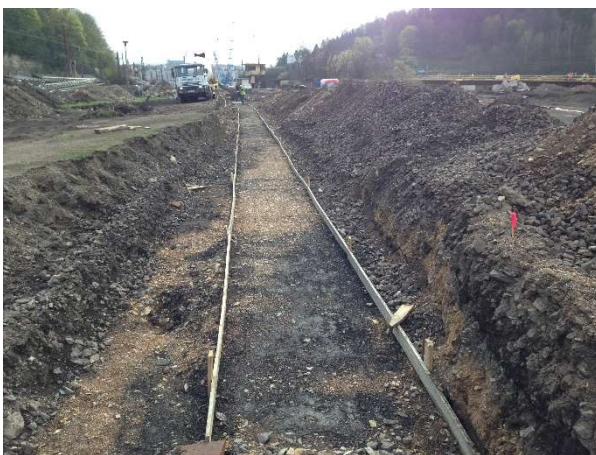
Obr. 81 – Zhutněná pláň pod nástupiště
