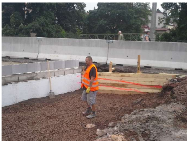
Obr. 30 – Zásyp za opěrou
