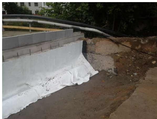
Obr. 29 – Těsnící vrstva, ochranná izolace
