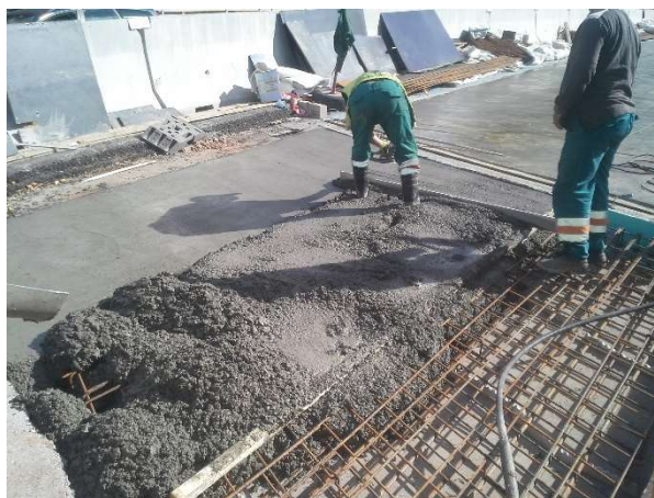
Obr. 39 – Betonáž přechodové desky
