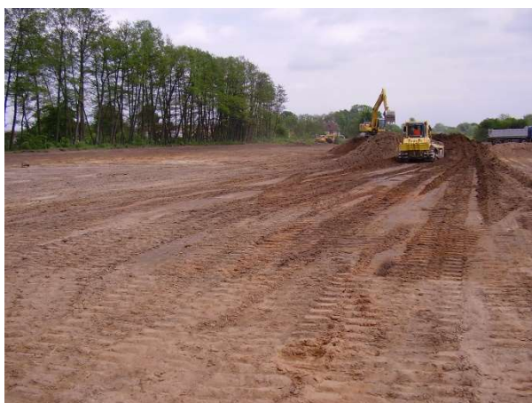
Obr. 56 – Hrubé terénní úpravy
