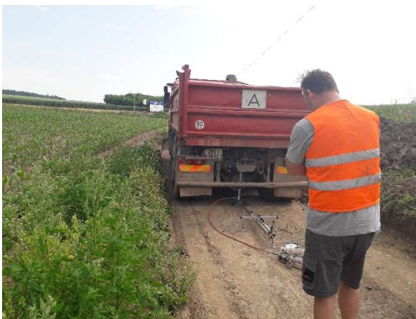
Obr. 54 – Statická zkouška na zemní pláni
