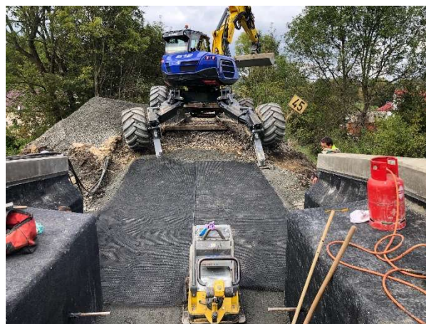
Obr. 43 – Vyztužení zásypu rubu opěry geomříží
