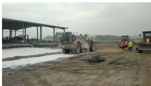
Obr. 69 – Vápnění zemní pláně areálových kom.
