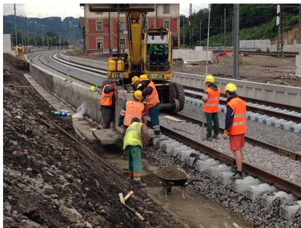
Obr. 86 – Nově osazená nástupištní hrana
