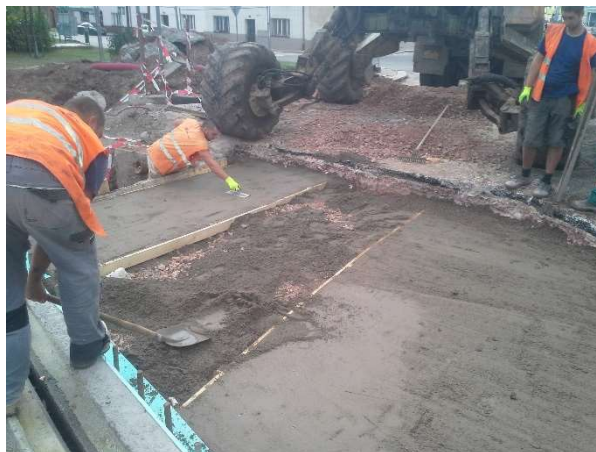
Obr. 37 – Podkladní beton pod přecho. desku
