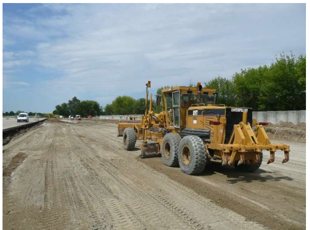
Obr. 75 – Rovnění zemní pláně APN
