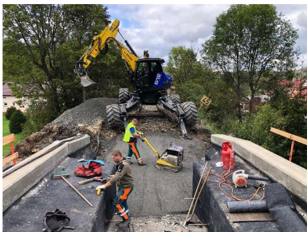
Obr. 42 – Zásyp rubu opěry
