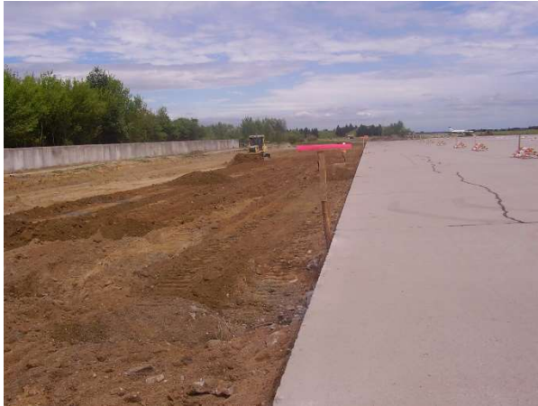
Obr. 72 – Hrubé terénní úpravy APN
