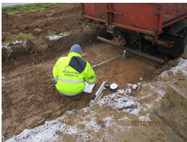
Obr. 48 – Ověřovací statická zkouška pláň
