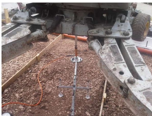
Obr. 33 – Statická zatěžovací zkouška
