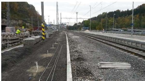
Obr. 91 – Vrty nízkotlaké injektáže
