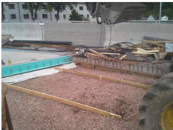
Obr. 36 – Vodítka pro podkladní beton
