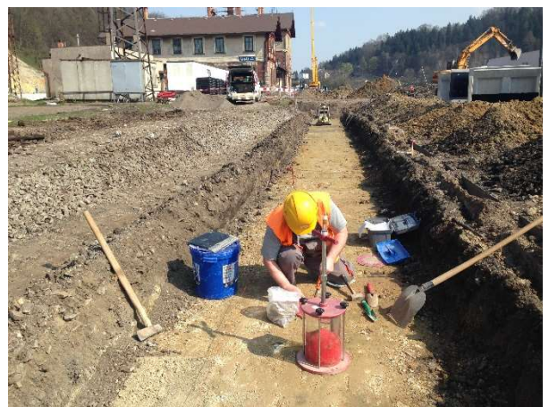
Obr. 82 – Zkoušky zemní pláně
