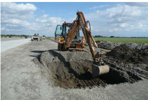
Obr. 76 – Sanace zemní pláně
