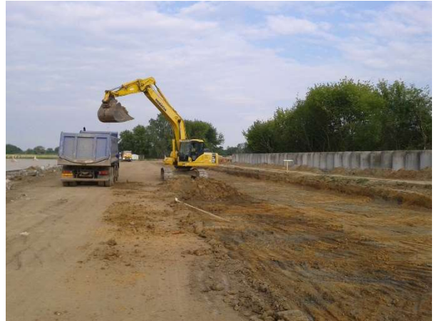
Obr. 73 – Hrubé terénní úpravy APN
