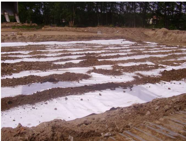
Obr. 64 – Vytužení násypu geotextilií
