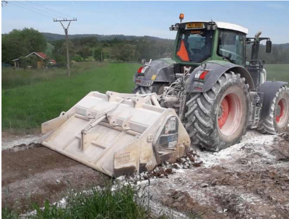
Obr. 52 – Úprava zemní pláně zemní frézou
