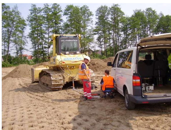
Obr. 59 – Statická zatěžovací zkouška
