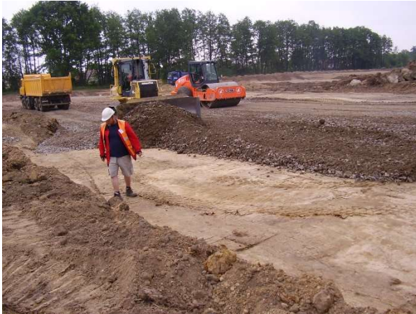
Obr. 60 – Vrstvení hrubozrnné zeminy
