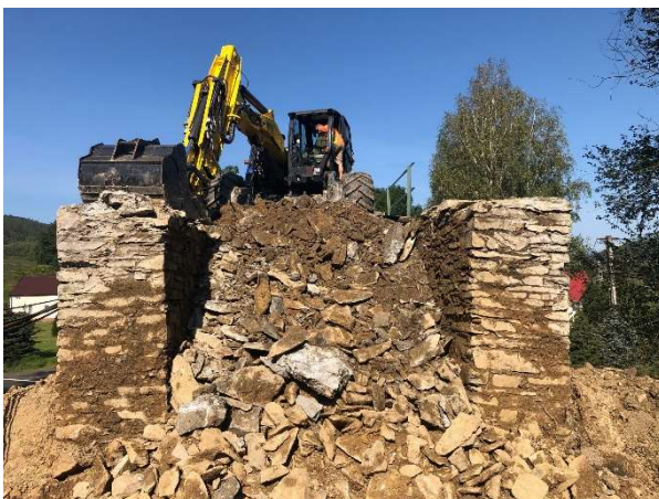
Obr. 40 – Stávající zásyp za opěrou
