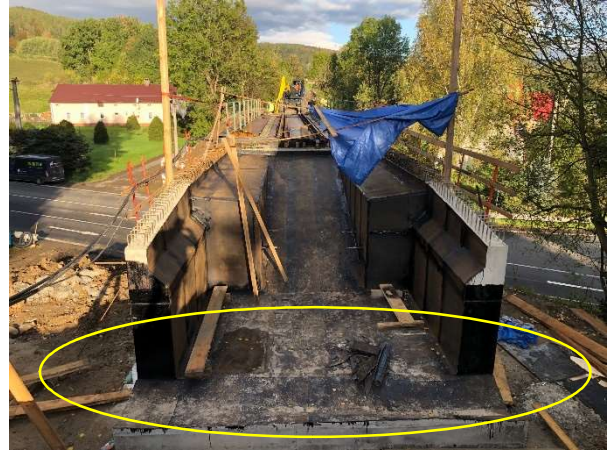
Obr. 45 – Izolace rubu opěry
