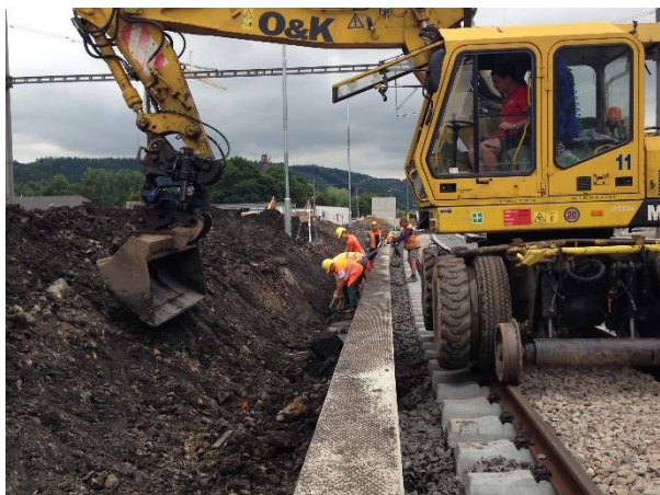
Obr. 85 – Rozebrání nástupištní hrany
