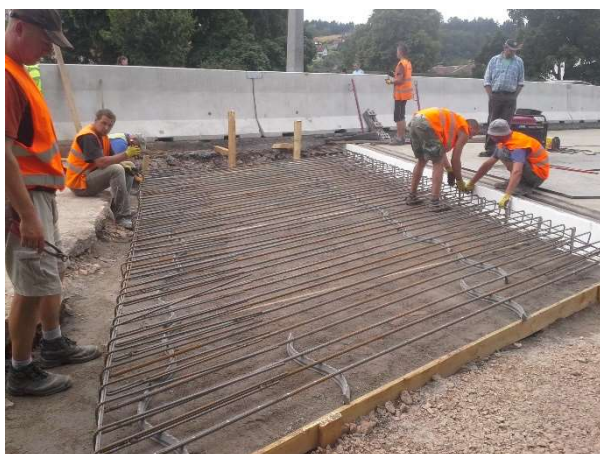
Obr. 38 – Vázání armatury přechodové desky
