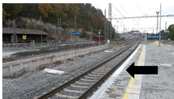
Obr. 94 – Dokončená hrana nástupiště
