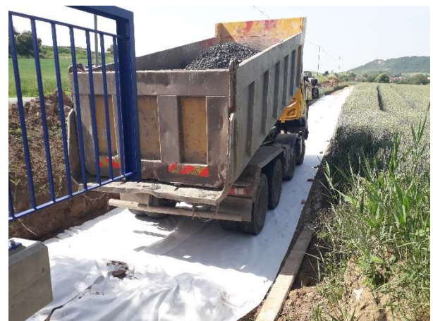
Obr. 55 – Ochrana zemní pláně geotextílií
