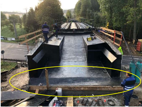
Obr. 44 – Odvodnění rubu opěry
