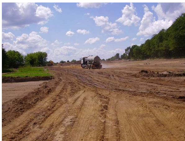
Obr. 57 – Úprava vlhkosti zeminy
