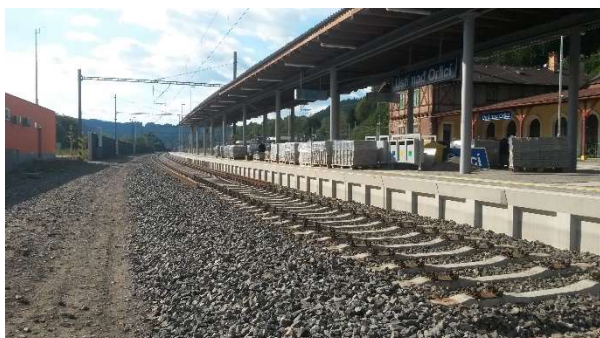
Obr. 89 – Snesení kolejového svršku
