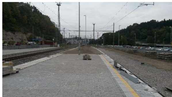
Obr. 92 – Dláždění nástupiště
