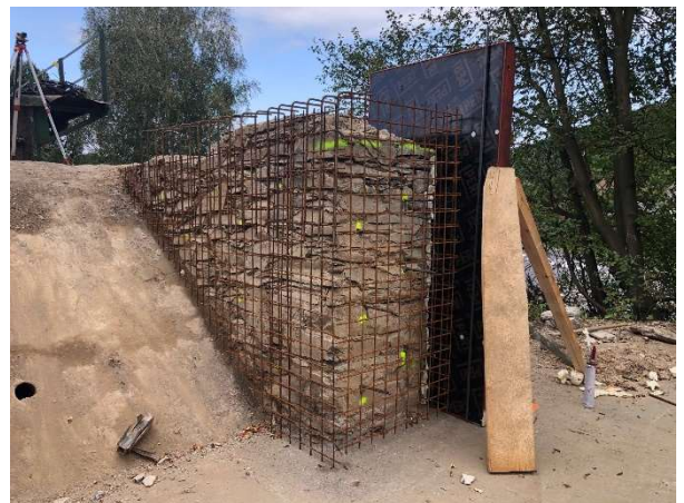
Obr. 41 – Oprava rozpadlého křídla
