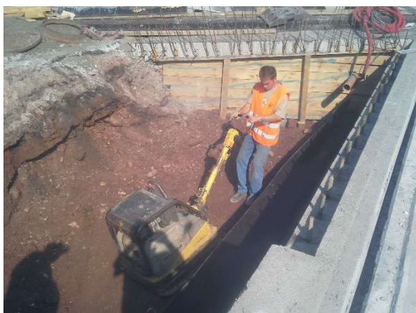
Obr. 26 – Hutnění zásypu základu
