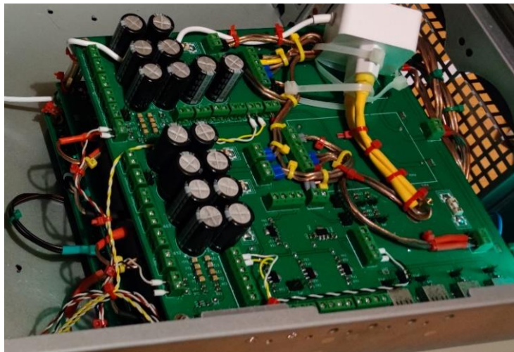
Obrázek 4.31 – Ukázka osazeného napájecího zdroje, po montáži v krabici.
