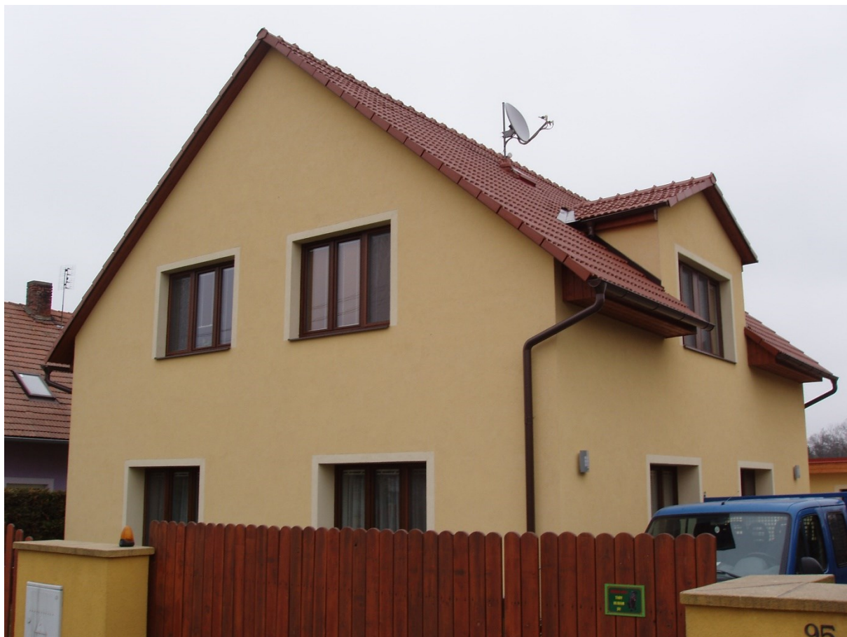
Obrázek 5: fotografie výše zmíněného rodinného domu po rekonstrukci společností Boss spol. s r.o.
