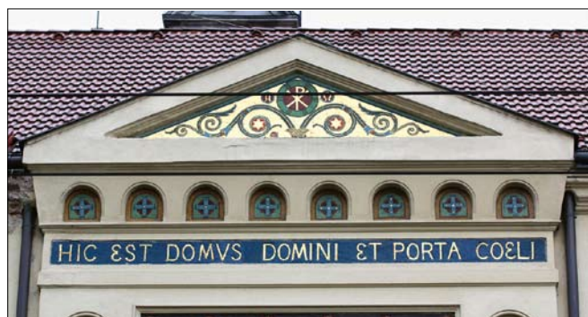
Obr. 9: Pohled na štít průčelí s dekorativní mozaikovou výzdobou, stav před restaurováním.
