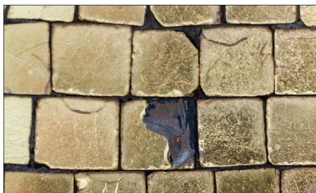
Obr. 24: Lokální ztráta svrchní tenké vrstvy skla (cartelliny) na žlutých kostkách, někdy i včetně zlaté fólie (foto archiv FR UPa, 2017).
