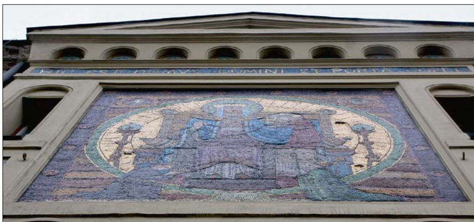
Obr. 18: Výrazné zvlnění a vyboulení povrchu mozaiky patrné při pozorování z bočního úhlu.
