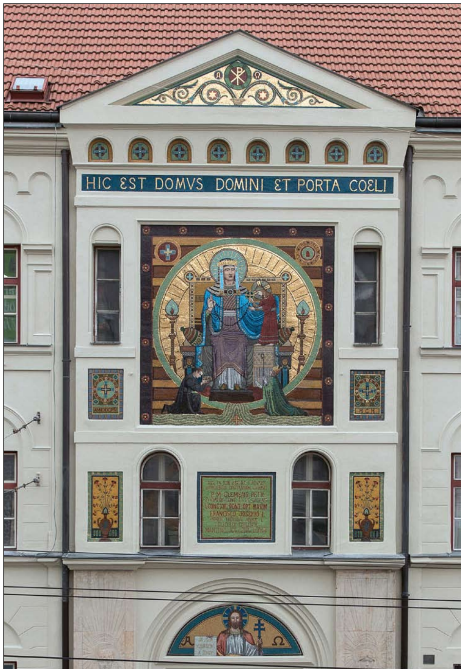
Obr. 28: Celkový pohled na průčelní fasádu s mozaikovou výzdobou po restaurování (foto archiv FR UPa, 2017).
