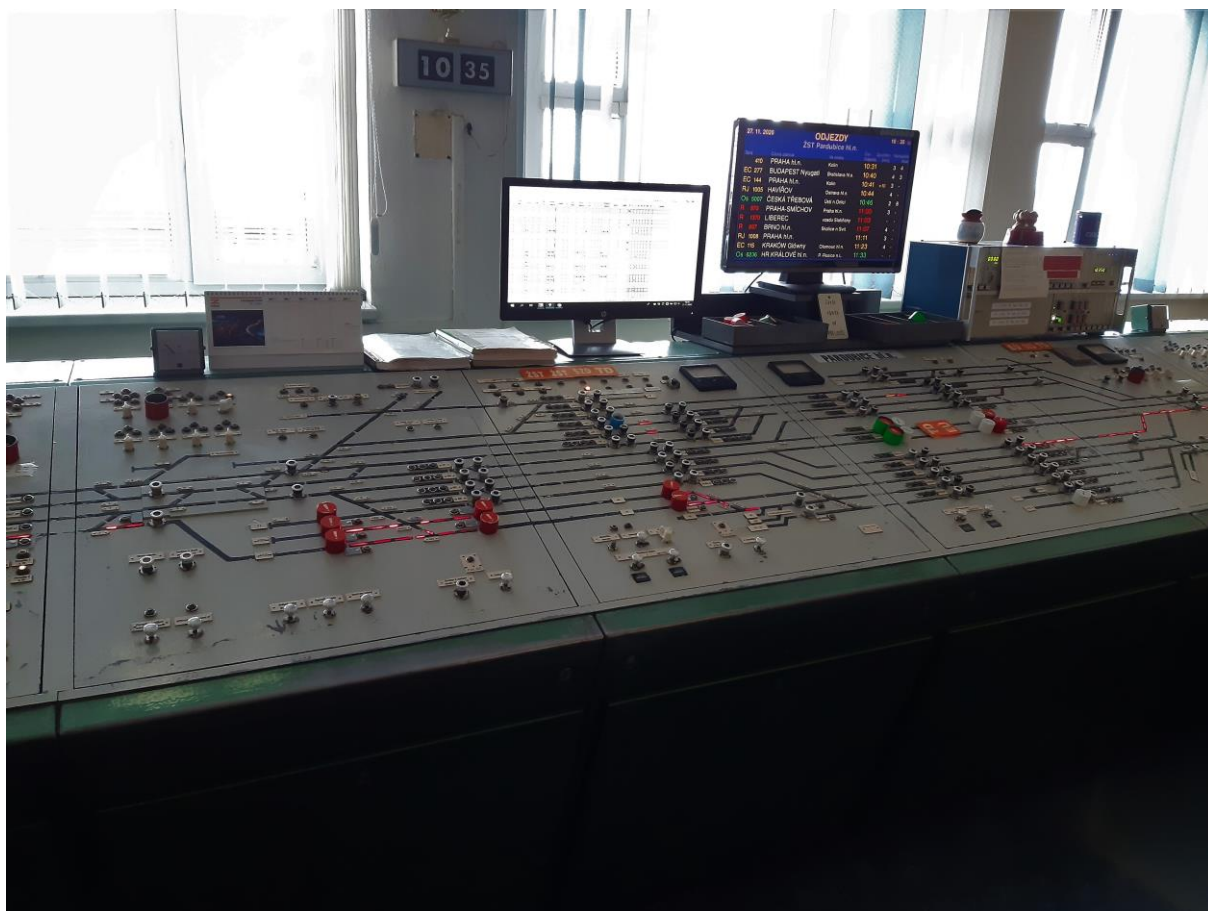
Obrázek 17 Reliéf kolejíště na panelu - reléovka
