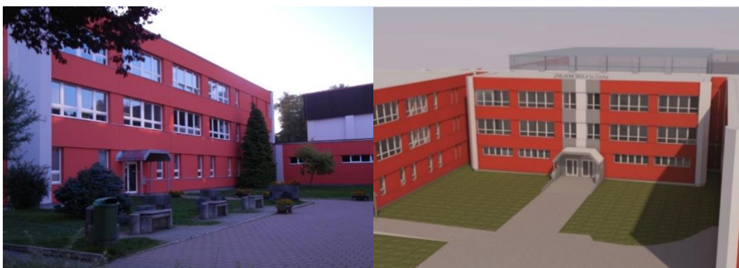
Obrázek 2: Přestavba Základní školy Sv. Čecha
