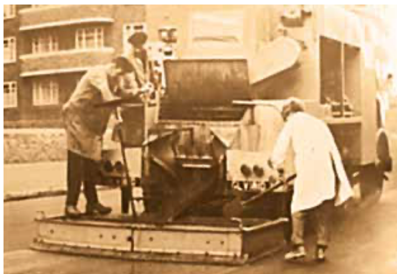
obrázek č. 1 – historická pokládka Slurry Sealu v USA [1]
