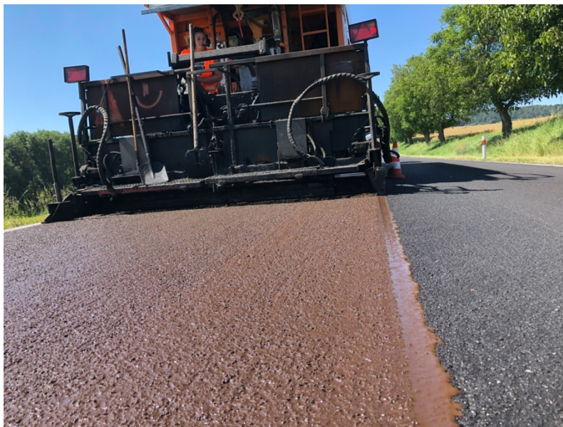
obrázek č. 13 – vlevo čerstvě položený EMK 0/5, vpravo pokládka z předešlého dne [18]
