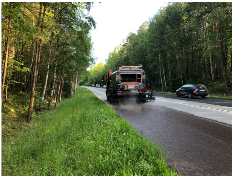
obrázek č. 12 – aplikace spojovacího postřiku na silnici I/3 u Plané nad Lužnicí [18]
