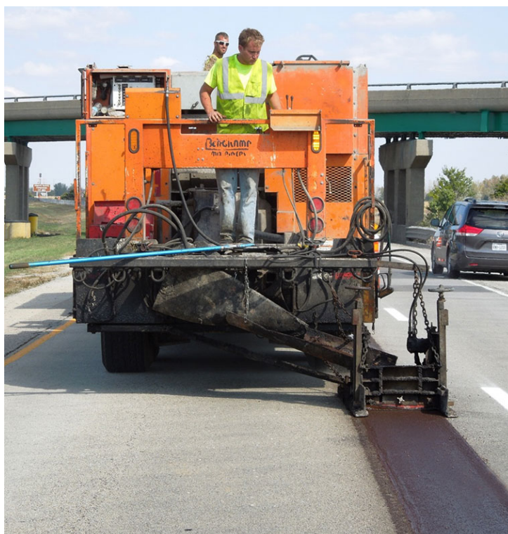
obrázek č. 22 – ošetření spojů metodou EMK v šířce 2 stop [26]
