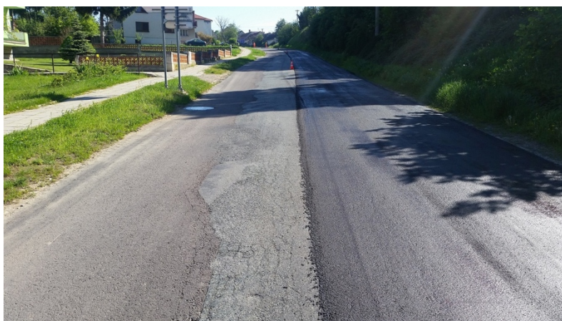
obrázek č. 2 –vlevo povrch vozovky před údržbou, vpravo po opravě technologií EKZ [4]
