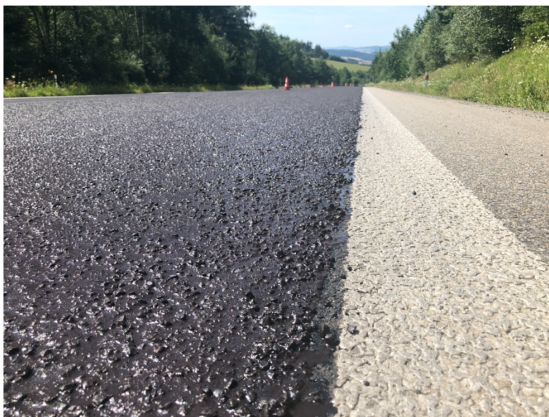
obrázek č. 14 – čerstvě položený mikrokoberec 0/5, začátek štěpení, směs je tmavě černá [18]
