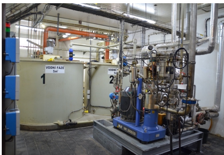
obrázek č. 5 – koloidní mlýn, v pozadí 2 nádrže na přípravu vodní fáze [20]
