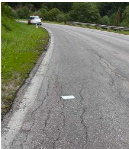
obrázek č. 26 – síťové trhliny před opravou technologií DUO-BELAG [27]
