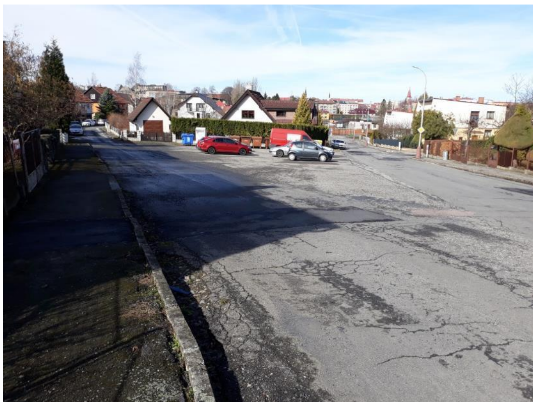
Foto č.17. - SO 02 Rekonstrukce parkoviště
