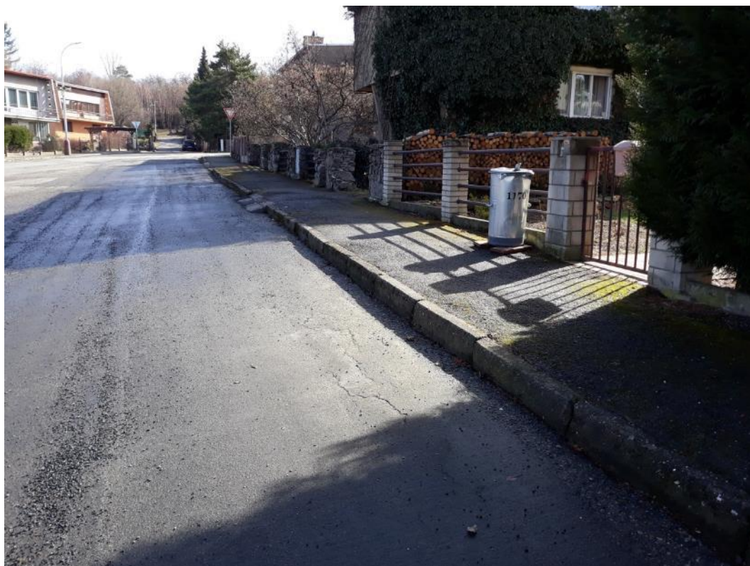
Foto č.16. - SO 02 Rekonstrukce parkoviště
