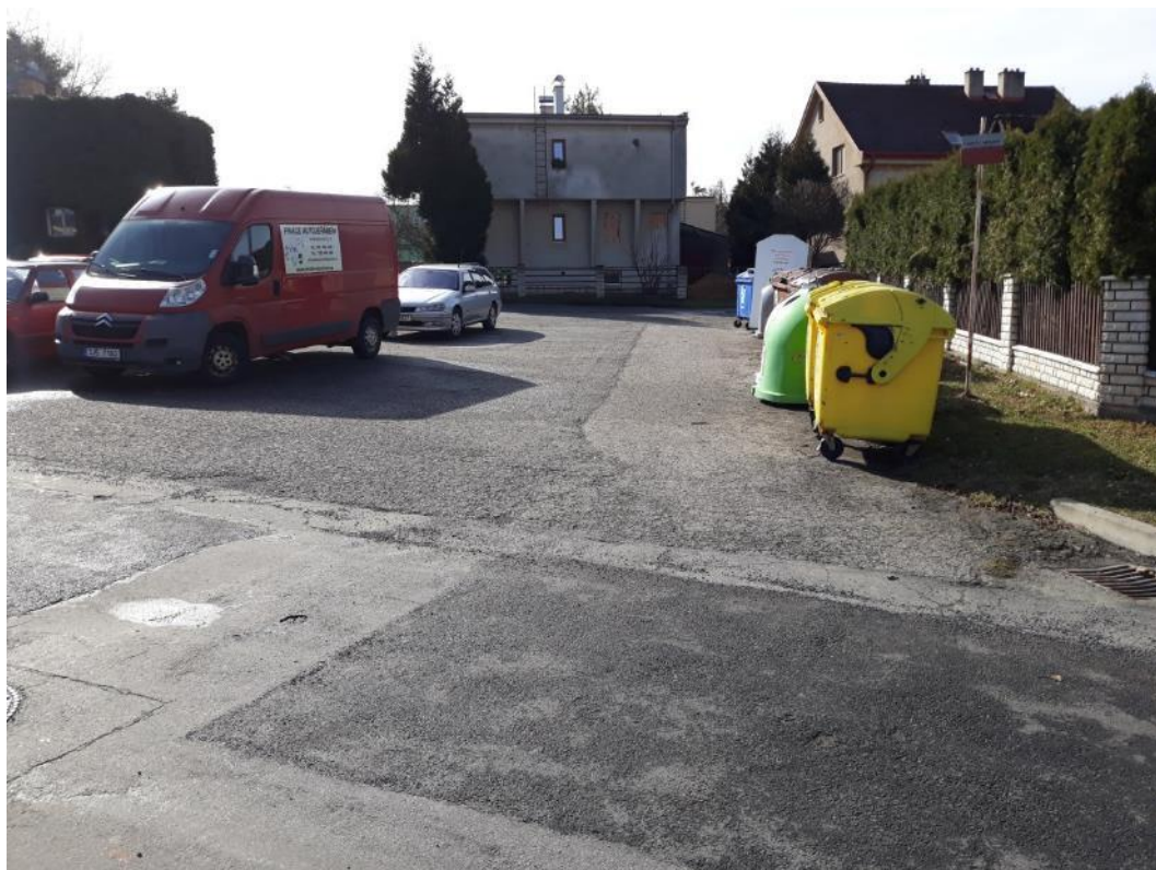
Foto č.13. - SO 02 Rekonstrukce parkoviště
