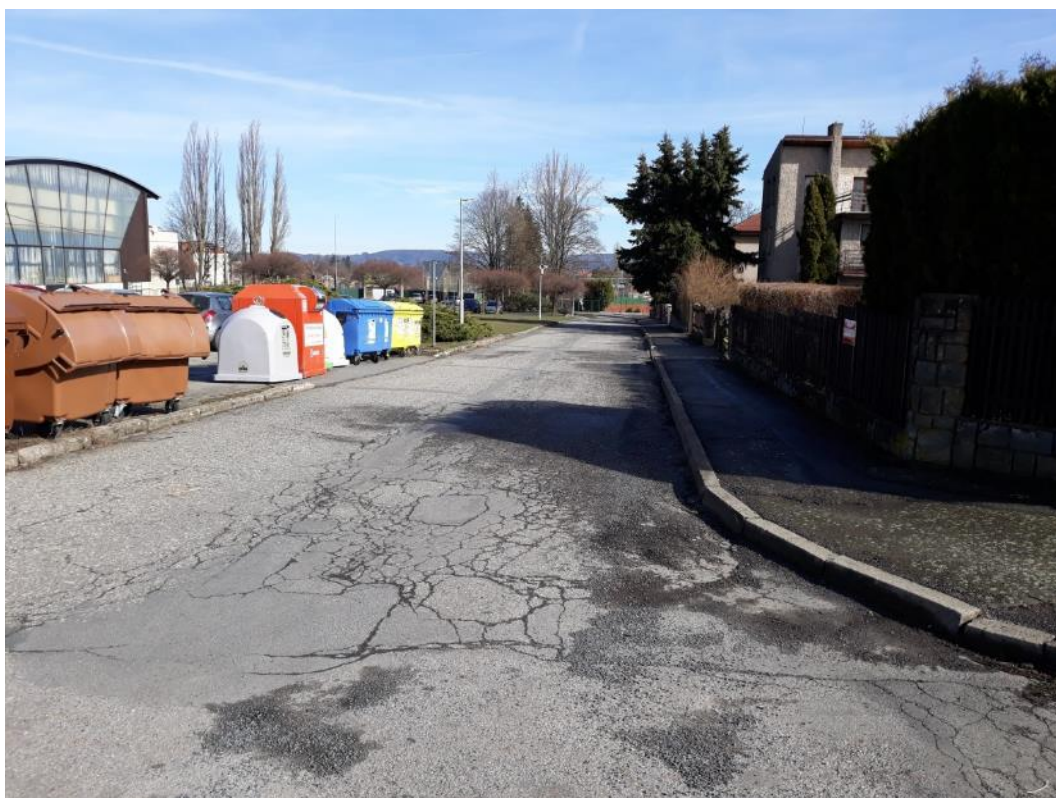
Foto č.1. - SO 01 ulice U Stadionu
