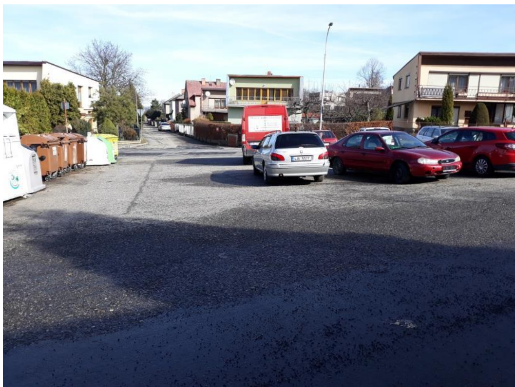
Foto č.15. - SO 02 Rekonstrukce parkoviště
