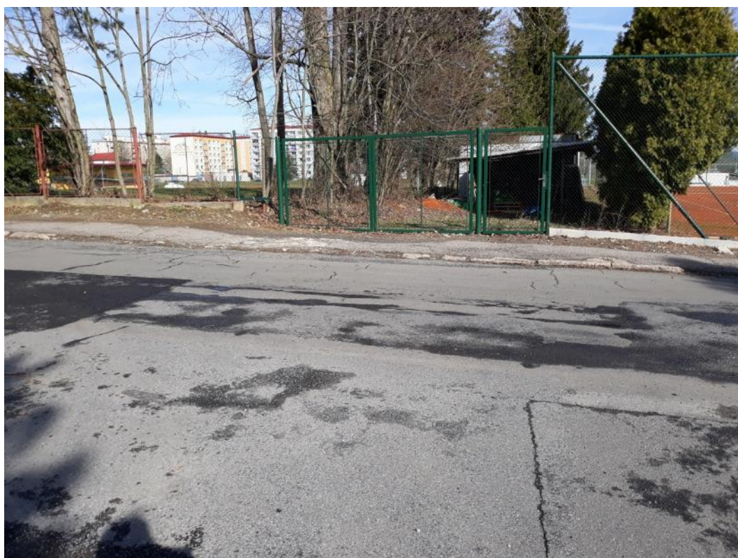
Foto č.4. - SO 01 ulice U Stadionu
