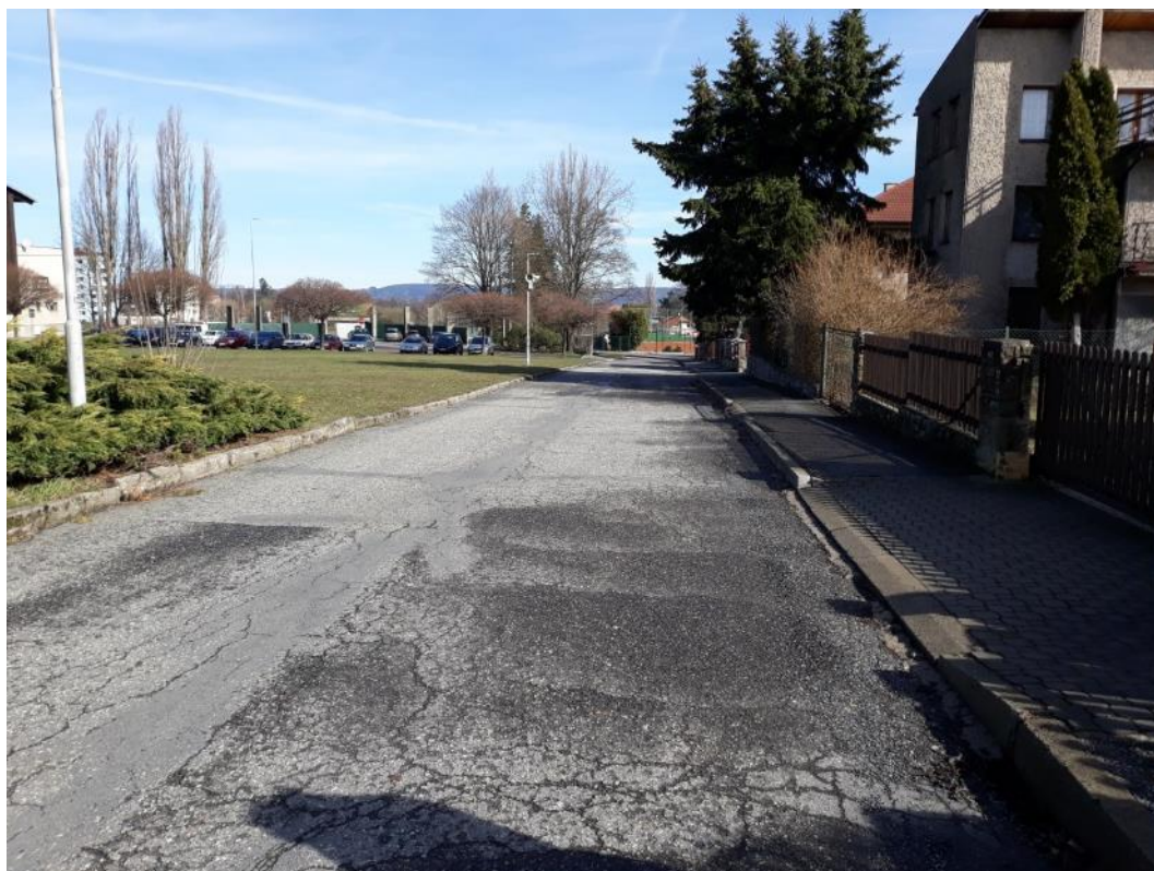
Foto č.2. - SO 01 ulice U Stadionu
