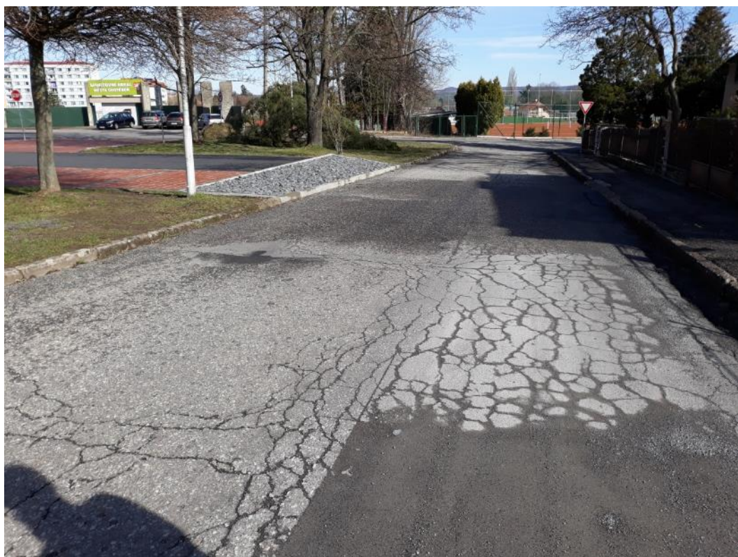
Foto č.3. - SO 01 ulice U Stadionu
