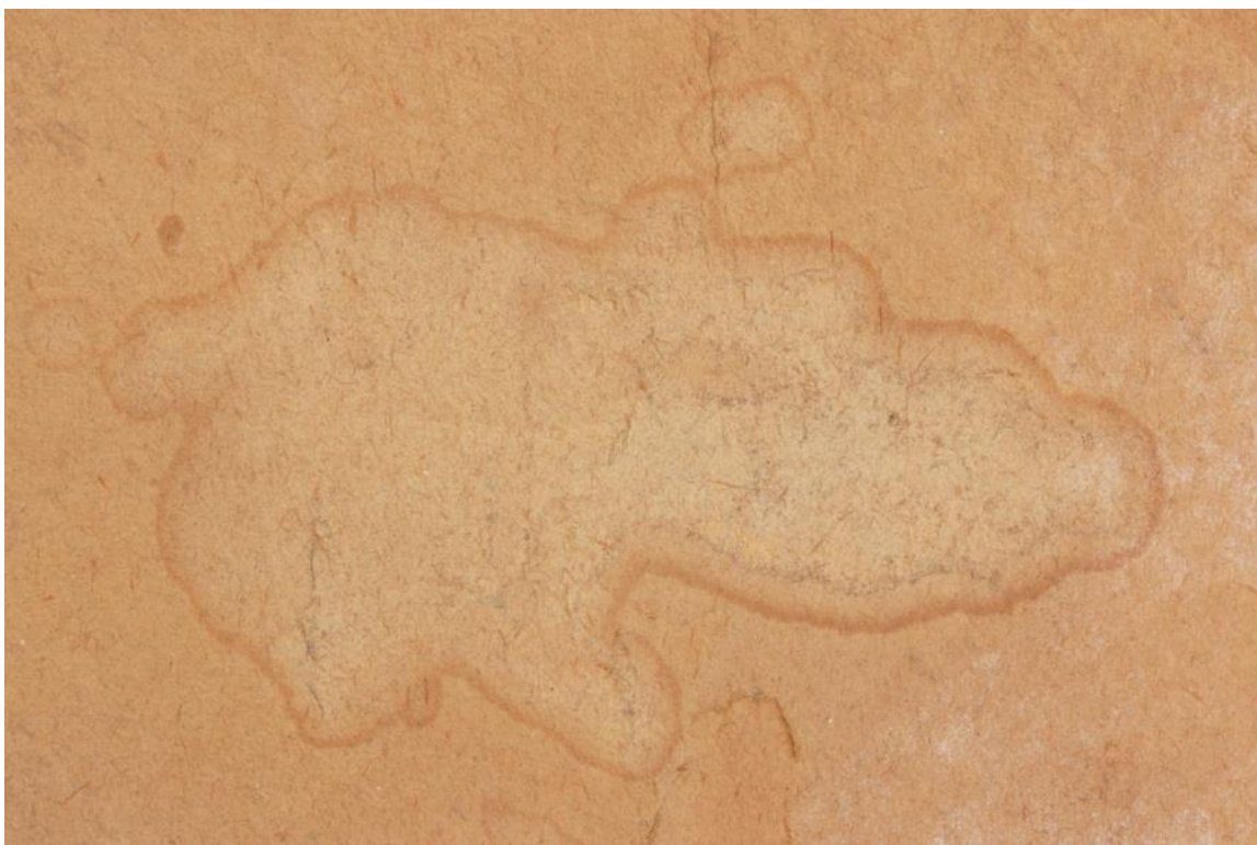
Obr. 27 Detail líce před restaurováním
