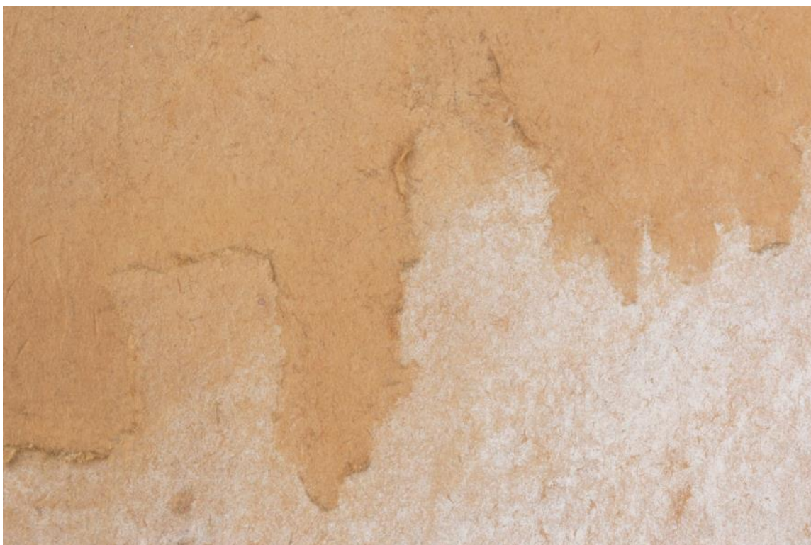
Obr. 29 Detail líce před restaurováním
