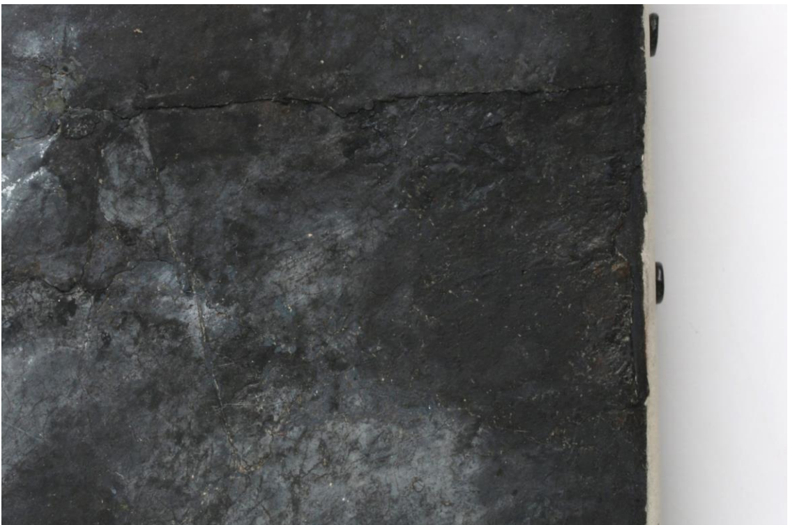
Obr. 76 Detail trhliny, po restaurování
