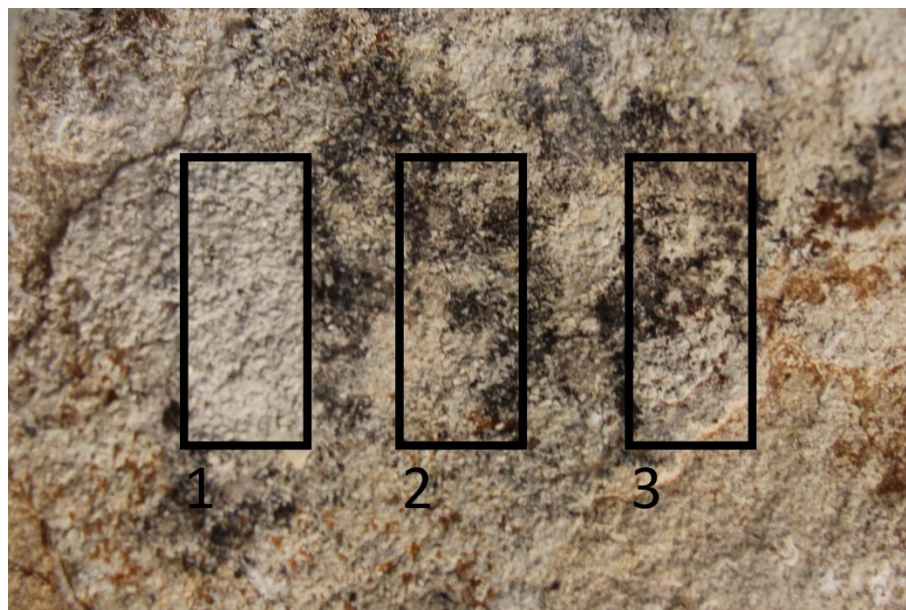
obr. 20 Zkouška čištění biologického napadení, 1. mikropískování bílým korundem 220 o 3 barů, 2. Čpavková voda a peroxid vodíku, 3. laser (Nd:YAG Q-switched laser Thunder art), nastavení: vlnová délka 1064 nm. při energii 300 mJ.
