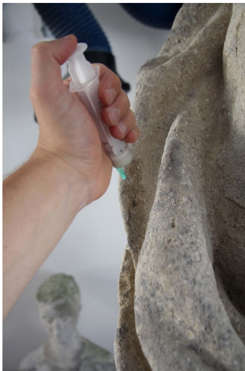
obr. 31 Detail, průběh aplikace konsolidačního prostředku
