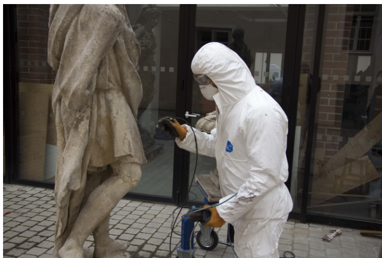
br. 28 čištění mikroabrazivní metodou, bílým korundem F 220, tlak 3 bary
