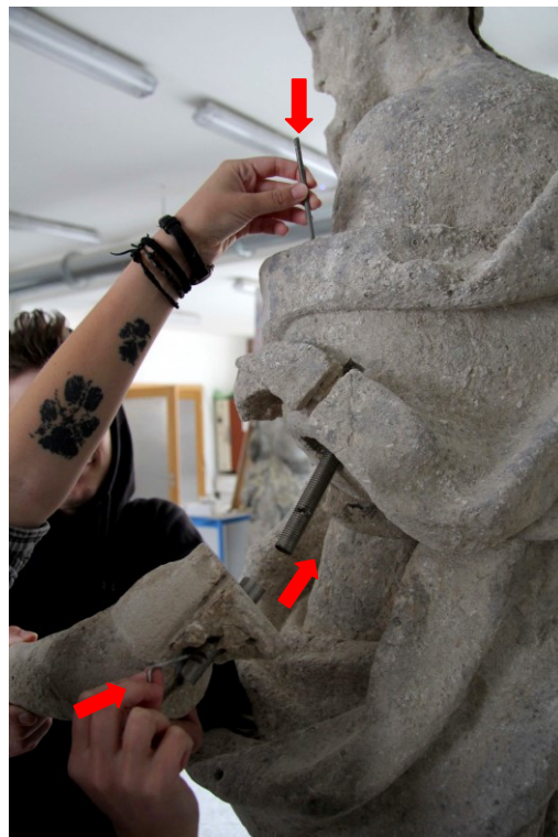
obr. 41 Způsob složení spoje
