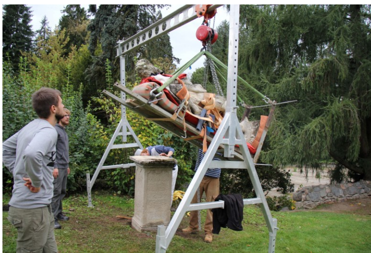
obr. 24 Demontáž mobilním jeřábem s řetězovým kladkostrojem
