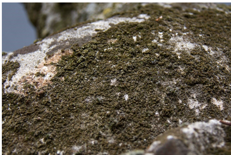
obr. 19 Detail biologického napadení
