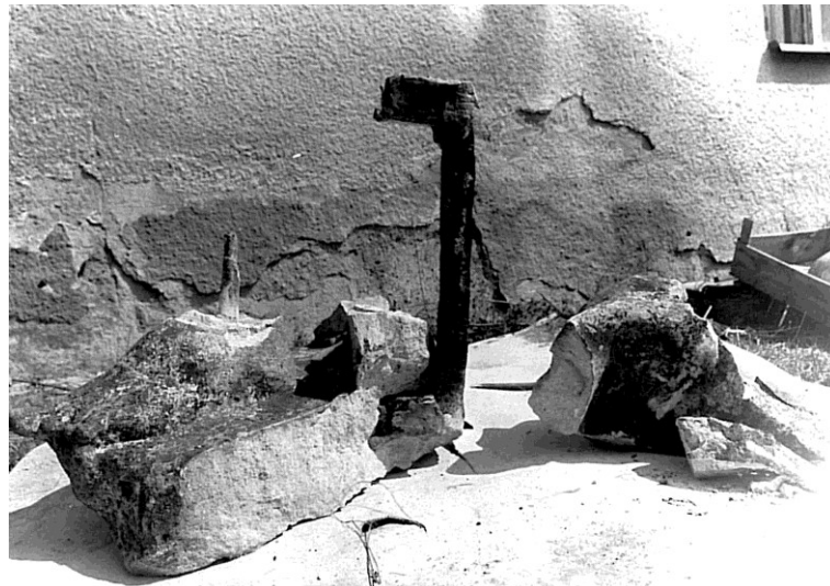
obr. 111 r. 1989 detail s armaturou 43
