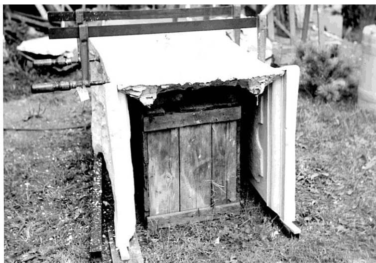
obr. 113 r. 1989 maketa nového soklu a výroba formy 44
