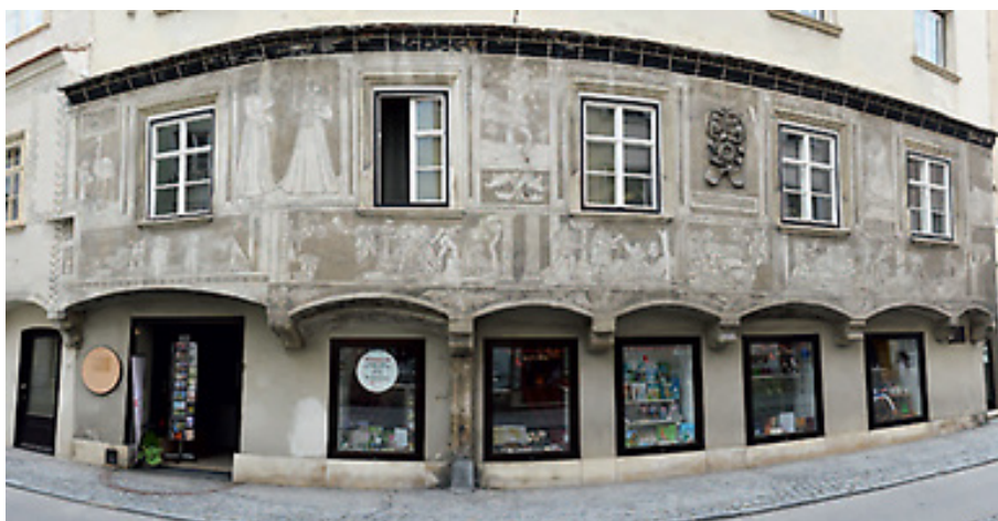
Obr. 86 Krems (Dolní Rakousko), Untere Landstrasse, čp. 67.
