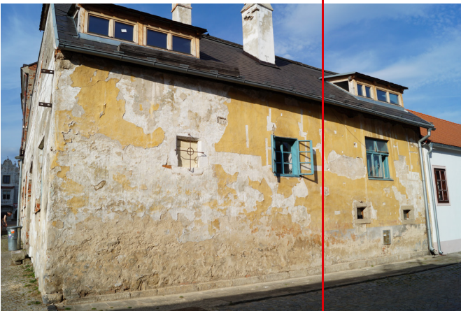
Obr. 54 Slavonice, býv. Růžová ul., dům čp. 545. Pohled na fasádu zleva před započítím prací. Červená čára značí přibližně stavební spáru mezi starší (vpravo) a přistavěnou částí.
