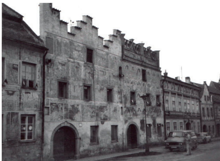
Obr. 13 Slavonice, Horní nám., domy čp. 536–538. Stav v 80. letech 20. století, kdy jsou fasády již prezentovány synteticky s principem vizuální integrity. Vykazují však značné poškození. Archiv města Slavonice.
