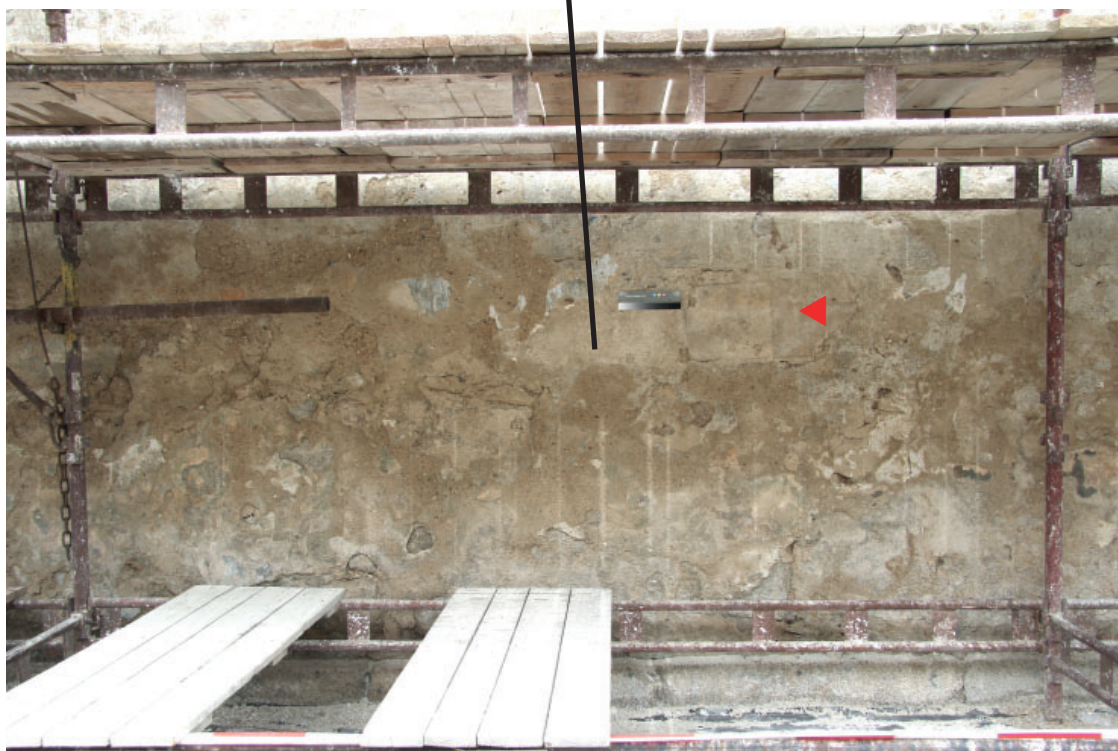
Obr. 67 Lokace zazděného kvádru v soklové partii přední části domu čp. 545.
