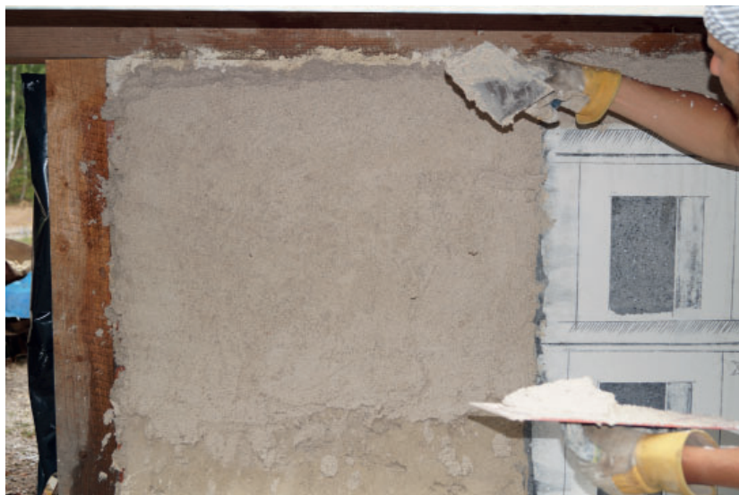
Obr. 21 Nanášení omítky zednickou lžící a nástrojem nazývaným rajblík či omítkářský talíř.
