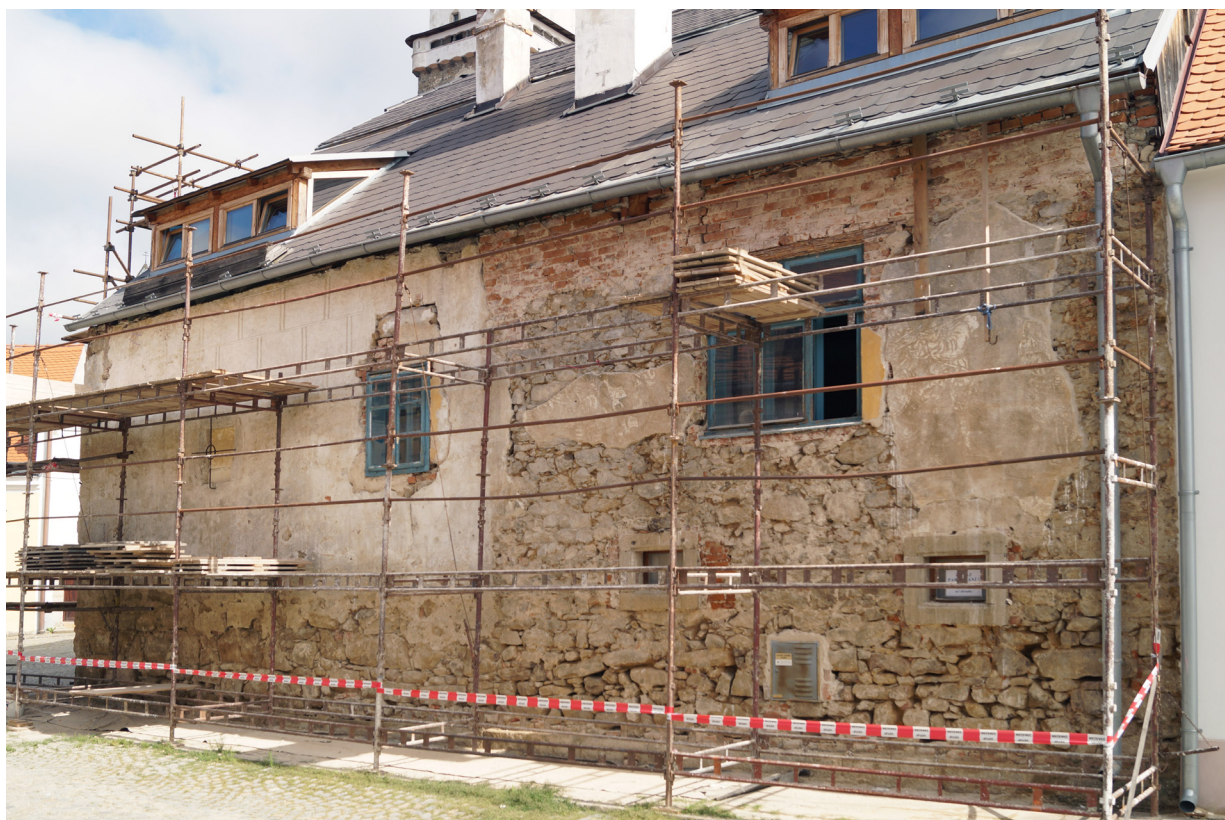
Obr. 103 Celkový pohled na boční fasádu po odkryvu v roce 2016.
