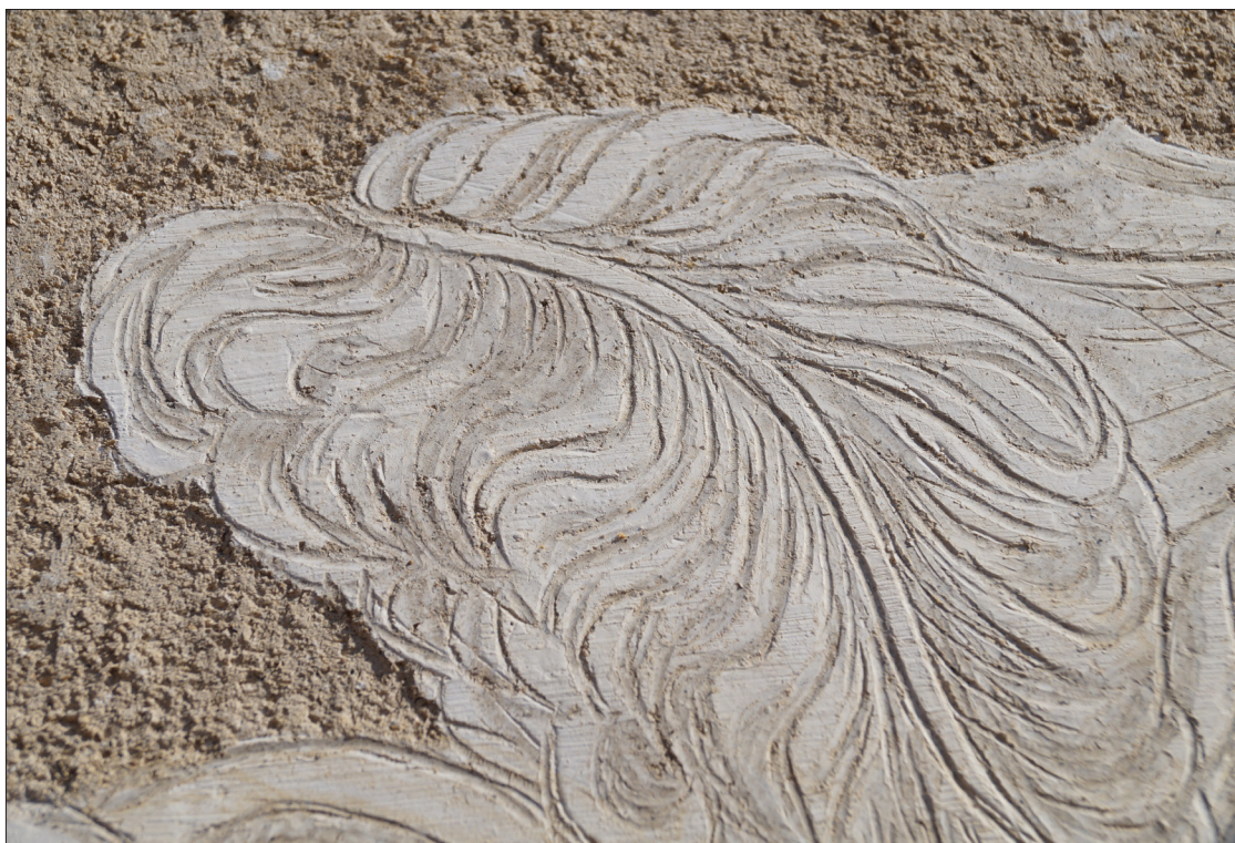
Obr. 171 Replikace trasologických stop, bianco má svoji typickou strukturu - prokletý, vodorovné tahy štětcem; vtačená šrafa, rytá šrafa.
