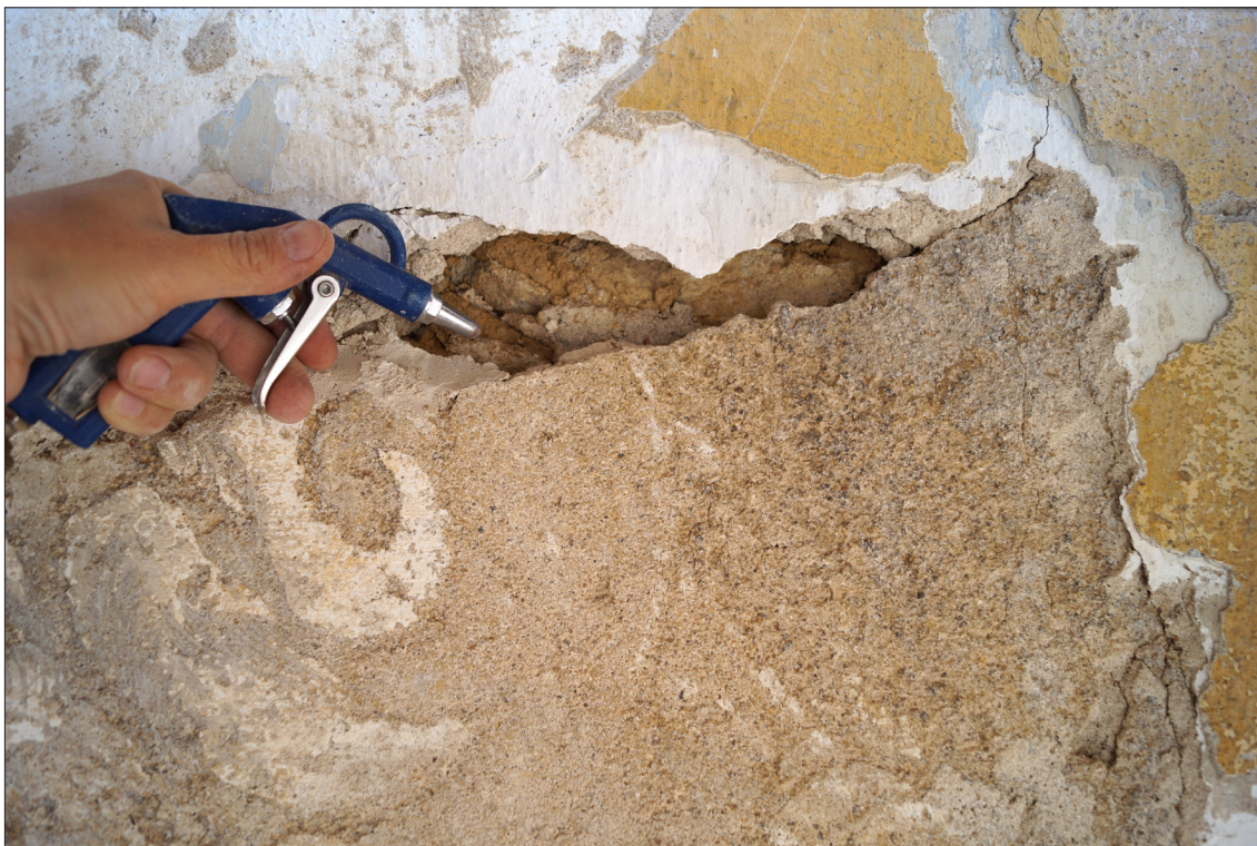
Obr. 117 Příprava na injektáž – obnažení okrajů, šetrné vyfoukání suti z jádrové omítky napadané za okraj.
