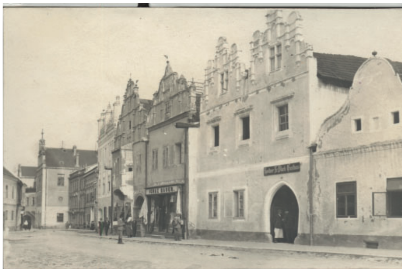
Obr. 9 Slavonice, Horní nám., jižní fronta domů (dolní část). Nedatováno, Archiv města Slavonice.
