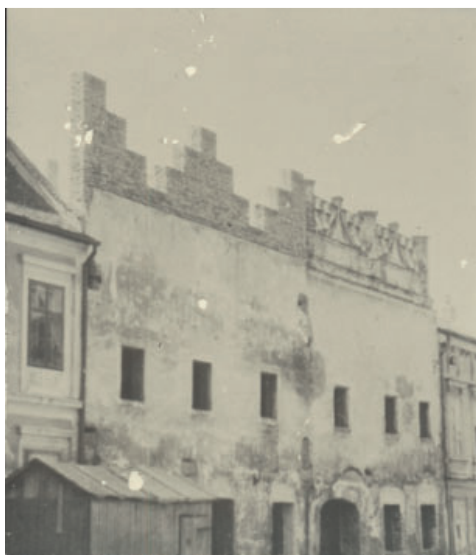
Obr. 12 Fotografie z let 1964–1965, kdy došlo k dostavbě štítu a novostavbě domů za fasádami. Fotografie zachycuje i objekt městského pivovaru čp. 536 (vlevo ještě s klasicistní, překryvnou úpravu pláště). Archiv města Slavonice.
