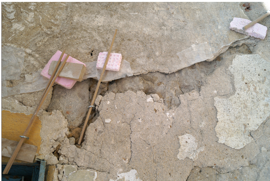
Obr. 115 Průběh odkryvu, zajištění okrajů tlakovací příchytanou konstrukcí a přelepý japonským papírem, výjev vlevo – muzikanti.
