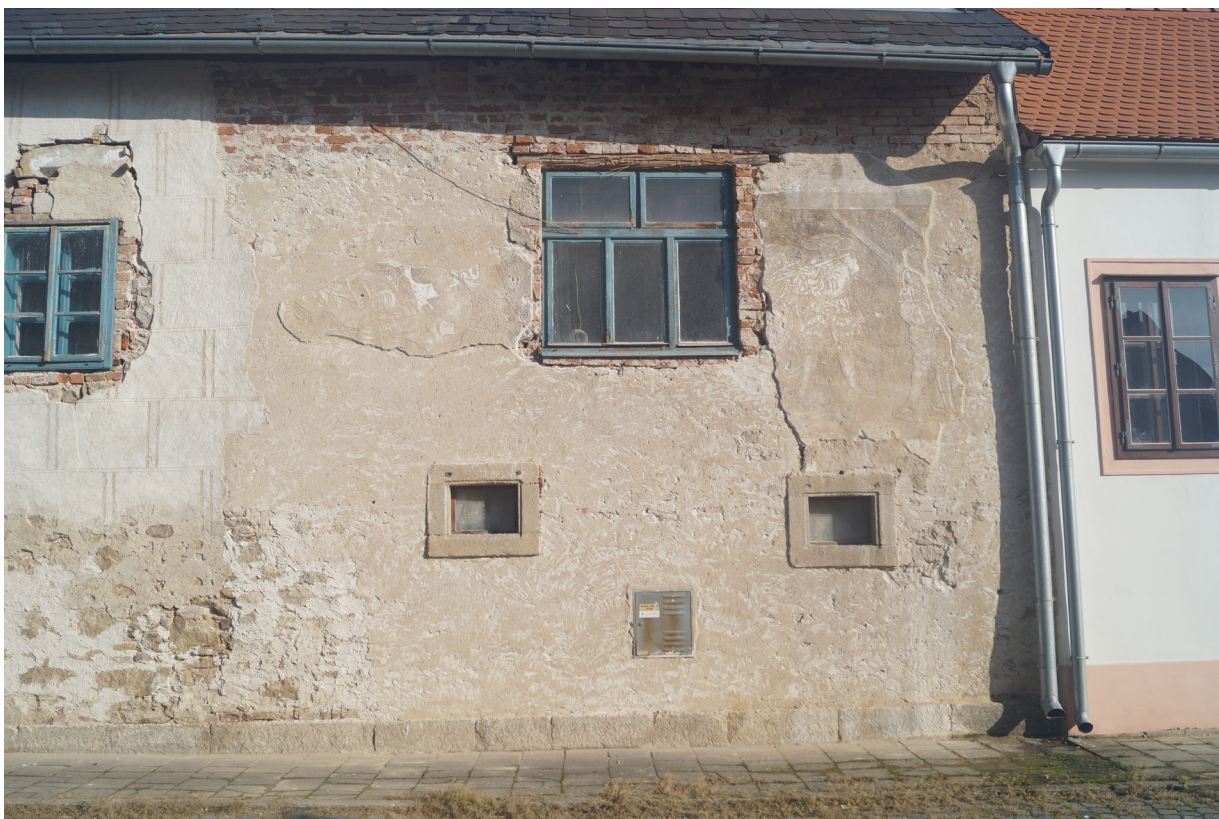
Obr. 104 Celkový pohled na boční fasádu po konzervaci fragmentů a aplikaci podzhozu jádrovou maltou v roce 2016.
