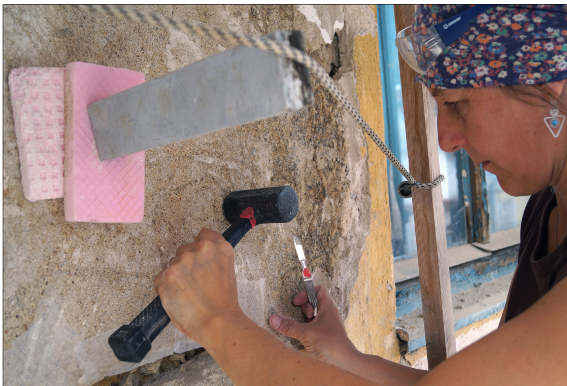
Obr. 116 Příprava na injektáž – přeplepy, zajištění tlakovacím zařízením, obnažení okrajů, šetrné vyklepávání suti z jádrové omítky napadané do dutiny.
