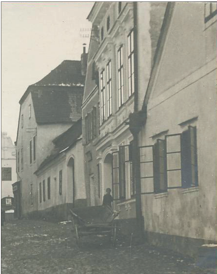
Obr. 62 Slavonice, ul. Boženy Němcové. Dům čp. 545 má otevřená šestidílná tabulková okna (později změněná za socialistická dvoukřídlá okna). Zřetelná je též část okna ve štítě a nedochované štukové římsičky nad okny. Archív NPÚ, Brno, inv. č. 6052, č. neg. 3027.
