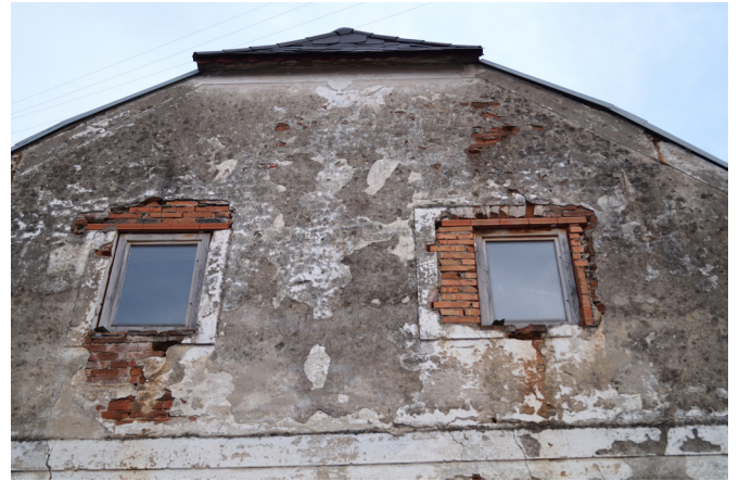
Obr. 53 Detail štítu s přestavěnými okenními otvory, u pravého okna štítu zřetelný zmíněný posun okna na fragmentu barokní/klasicistní fasety.
