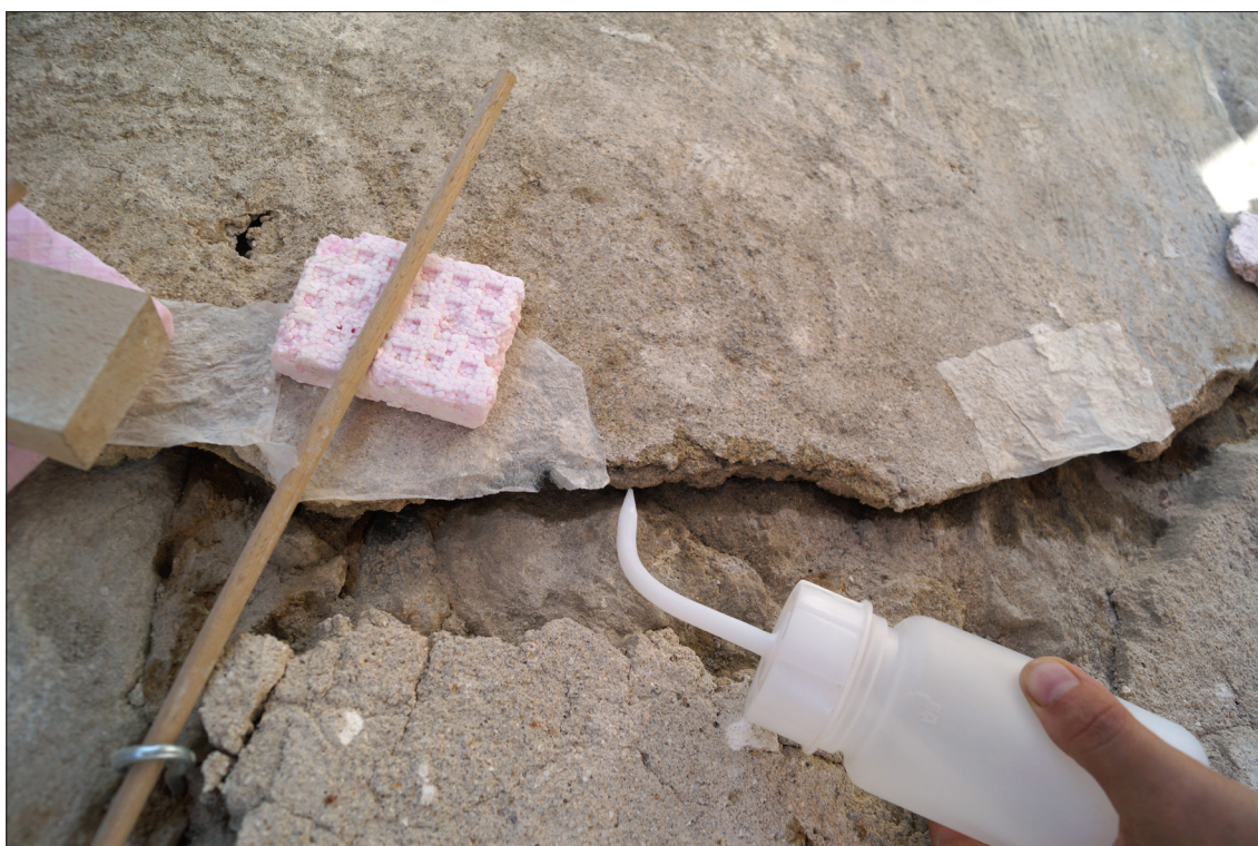
Obr. 118 Příprava na injektáž - obnažení okrajů, zpevnění vápennou nanosuspensí CaloSil.
