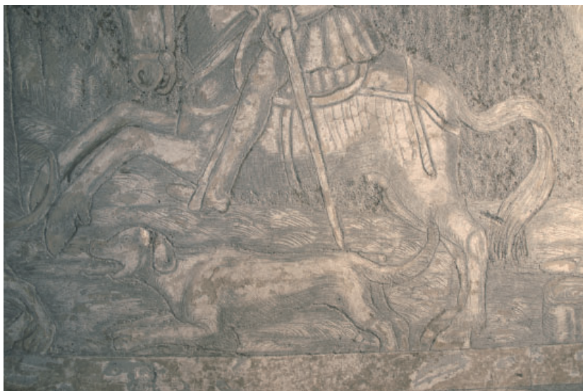
Obr. 19 Telč, zámek, Hodovní síň. Detail psa a jezdce na koni stínovaný prokletováním. Na povrchu jsou však zřetelné výrazné hnědé skvrny, které pocházejí z pozdějších zásahů. Barevné intonaco je šedé s pálenou slámou a uhlím.
