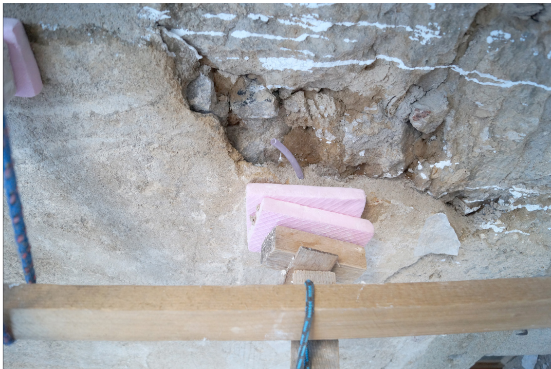
Obr. 121 Průběh injektáže minerálním groutem, odlehčeným přídavkem Perlitu, aplikace hadičkou instalovanou v obtmeleném okraji, následné přitlačení ke zdivu.
