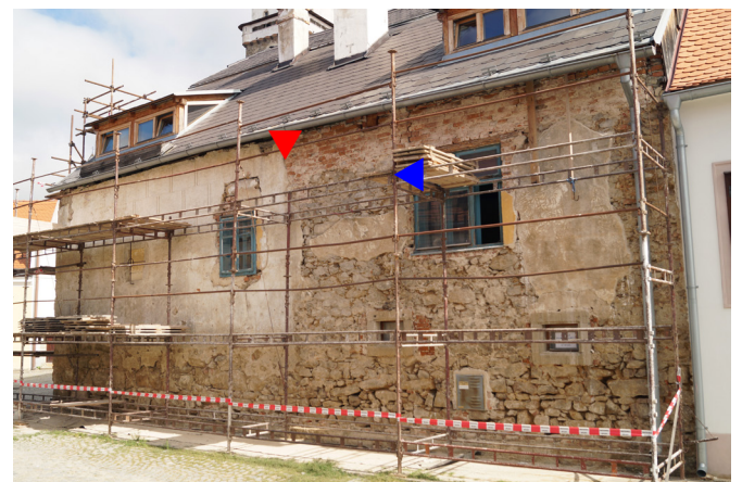
Obr. 57 Fasáda čp. 545 do ulice Růžová. Spára označena červenou šipkou, cihlová dostavba staršího nižšího domu do výšky přední renesanční části modrou šipkou. Na zdivu je zřetelné rozdílné ložení kamenného zdiva: starší nižší část má drobnější kameny s velkými spárami (jílová malta často vyplavená) přední část je z velkých kvádrů ložených do vápenné malty.
