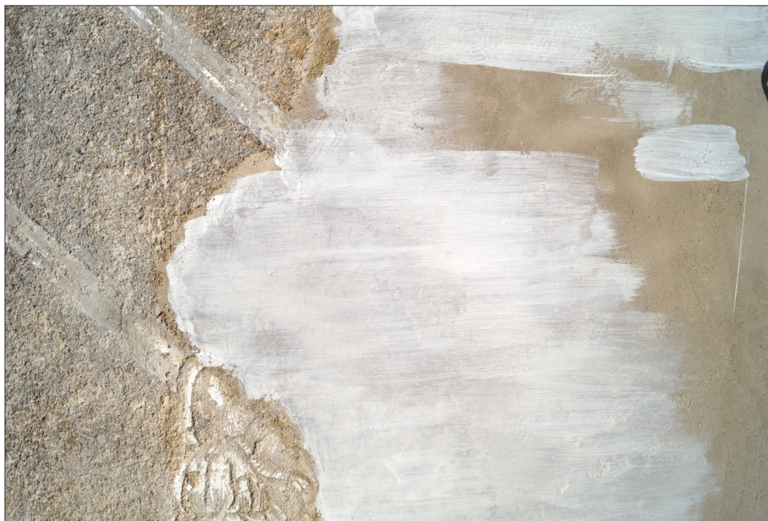
Obr. 165 Způsob nanášení bianca.
