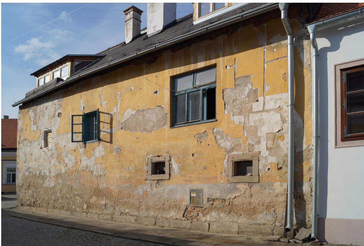
Obr. 102 Celkový pohled na boční fasádu před započatím restaurátorských prací v roce 2015.
