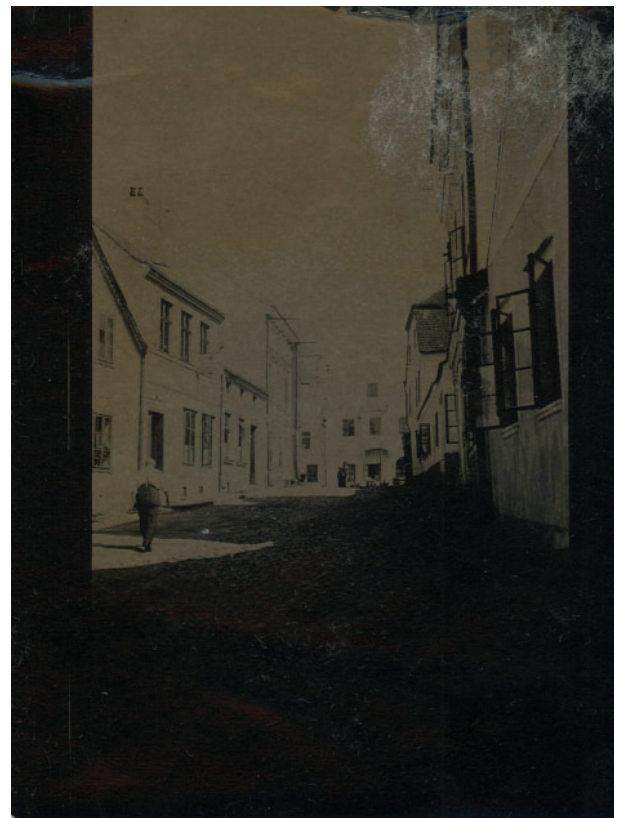
Obr. 63 Slavonice, ul. Boženy Němcové. Dům čp. 545 má otevřená šestidílná tabulková okna (později změněná na socialistická dvoukřídlá okna). Nad okny jsou zřetelné nedochované štukové římsičky a podparapetní římsy. Archív Města Slavonice.
