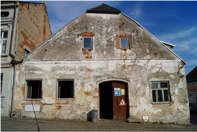
Obr. 52 Slavonice, ul. Boženy Němcové, dům čp. 545. Fasáda po několika zásazích: barokní štít a stavební otvor průjezdu, změna oken (kromě levého štítového okna není žádné v renesanční ani barokní pozici (úpravy v 1. a ve 2. pol. 20. stol).
