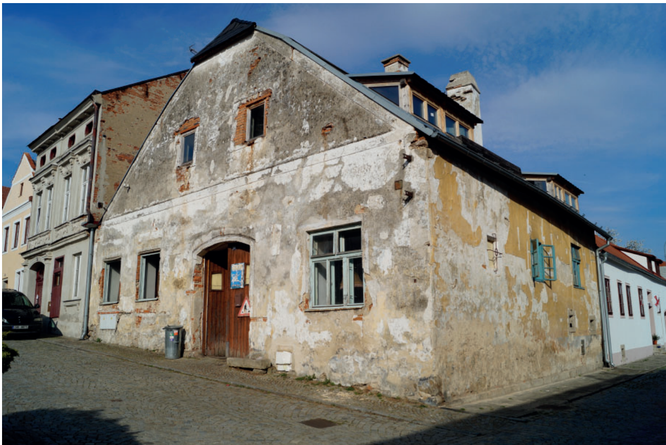
Obr. 1 Slavonice, dům čp. 545, celkový pohled na dům před započatím restaurátorských prací v roce 2015.
