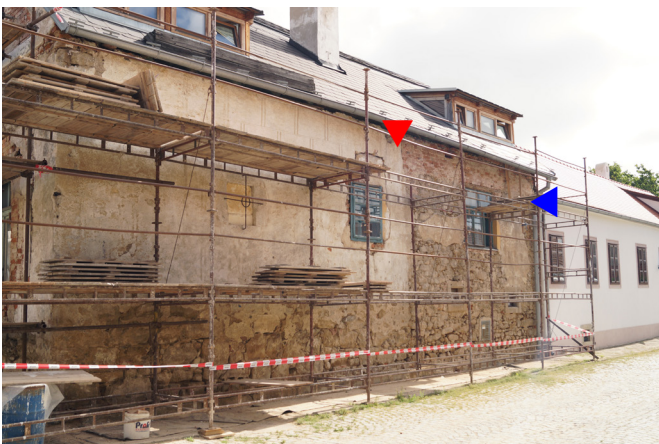
Obr. 56 Pohled na fasádu zleva během prací. Spára označena červenou šipkou, cihlová dostavba staršího nižšího domu do výšky přední renesanční části (v baroku?, v 19. stol.?) modrou šipkou.
