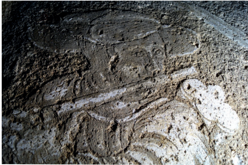
Obr. 18 Slavonice, ul. Boženy Němcové, dům čp. 545. Detail původního povrchu na dekoru stínovaném odebráním špachtlí (prokletováním bianca). Barevné intonaco je barvené přirozenou barevností písku.
