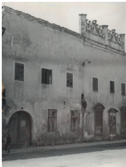
Obr. 11 Slavonice, Horní nám., domy čp. 538 a 537. Datovaná fotografie z roku 1963, kdy došlo k ubourání a přestavbě za fasádami. Sgrafita jsou pod překryvnou vrstvou, štít domu čp. 537 je ubouraný. Archiv města Slavonice.
