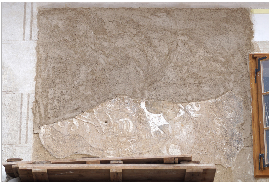
Obr. 159 Rekonstrukce vlajkonoše - první vrstva barevného intonaca se strženým povrchem.
