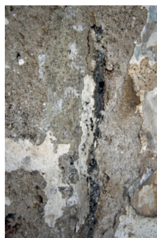
Obr. 72 Konstrukční prvky portálu – římsa a bosy, jejich otisky se dochovaly v negativu a byly provedeny uhlové omítce, zatímco okolní sgrafitová bosáž je v přírodně– pískové omítce.
