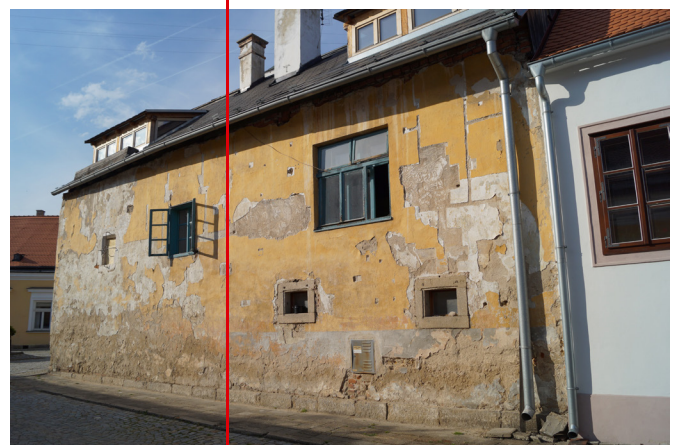
Obr. 55 Pohled na fasádu zprava před započítím prací. Červená čára značí přibližně stavební spáru jednotlivých stavebních etap.
