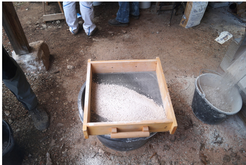
Obr. 94 Příprava vápna hašeného na prach pro barevné intonaco, síťování.
