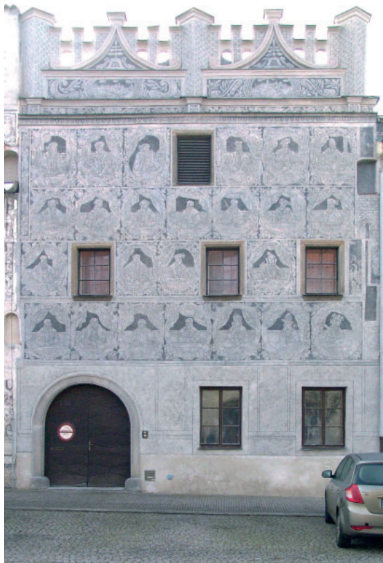
Obr. 26 Slavonice, Horní nám., dům čp. 538. Tzv. Kurfiřtská fasáda – k volitelům jsou přiřazeni další významné osobnosti 16. století.
