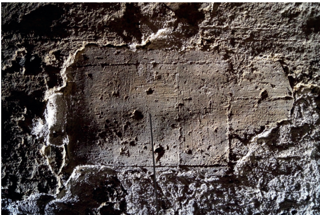
Obr. 66 Slavonice, dům čp 545. Soklové partie do boční ulice. Zazděný kvádr potažený sgrafitem z totožné omítky jako figury landsknechtů (potvrzeno laboratorní analýzou).
