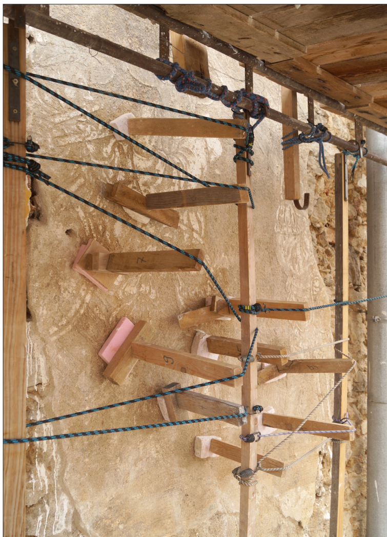
Obr. 122 Výjev s muzikanty – bodová injektáž s přitlačnými konstrukcemi.
