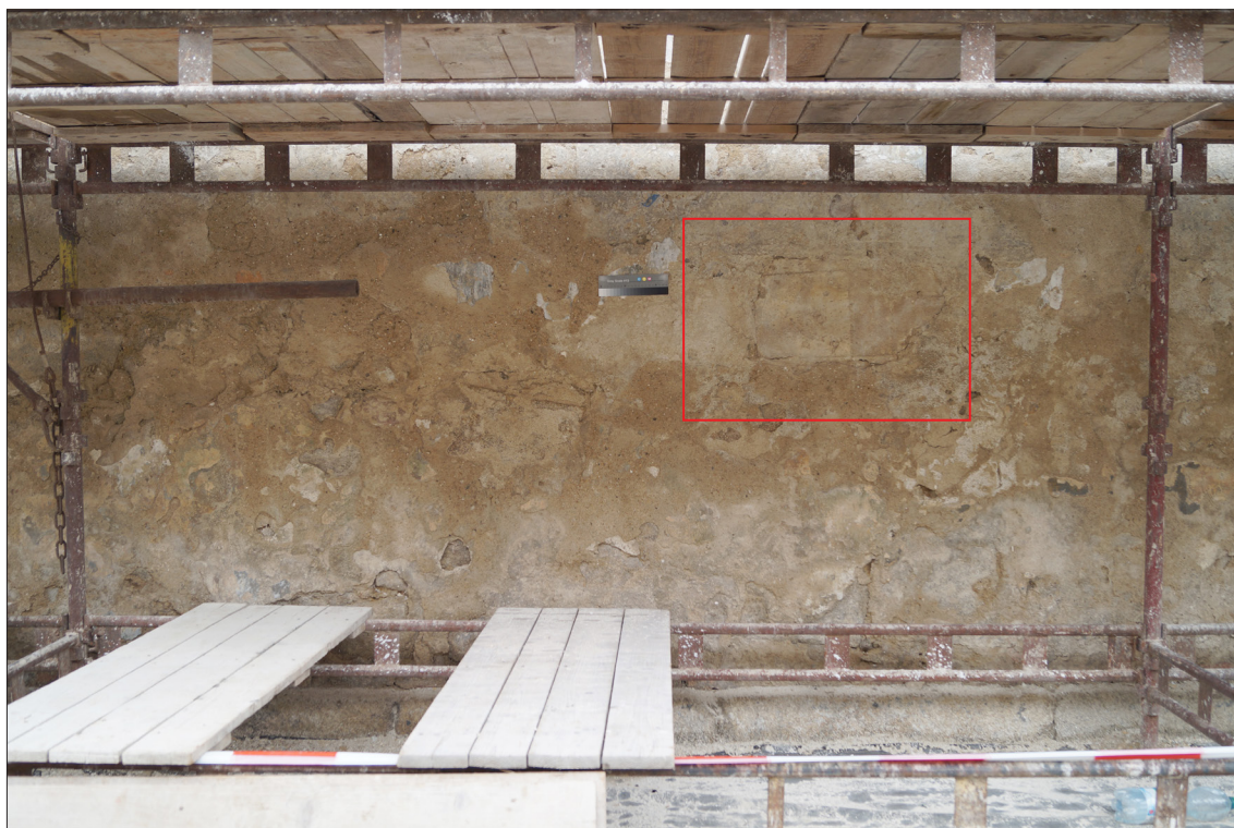
Obr. 111 Zazděný kámen potažený „landsknechtskou“ sgrafitovou omítkou v soklu přední části.
