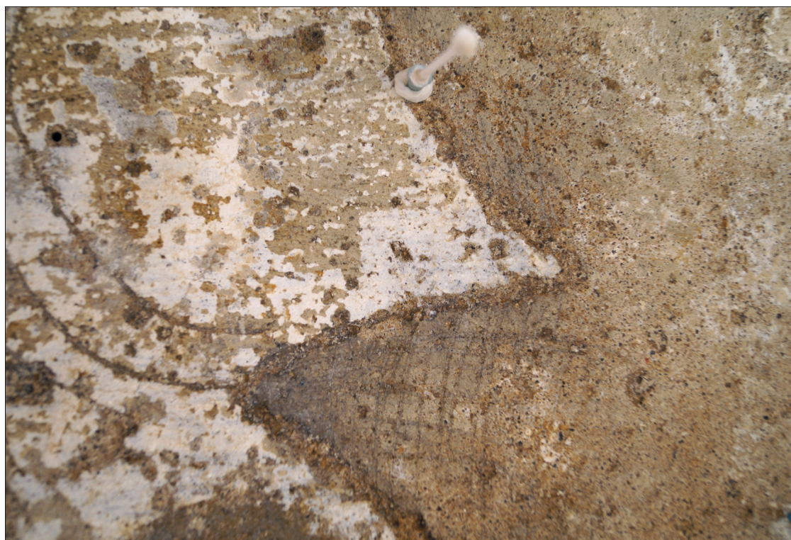
Obr. 125 Zkouška odstraňování povrchových nečistot/krust, naměkčením vodou a šetrné mechanické snímání planžetovým skalpelem.
