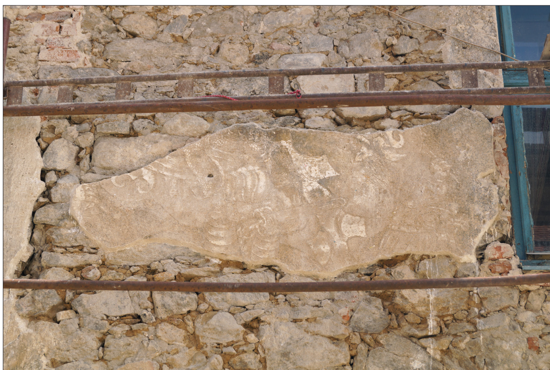
Obr. 133 Výjev s praporečkem, stav po odkryvu, očištění, konzervaci a obtmelení.
