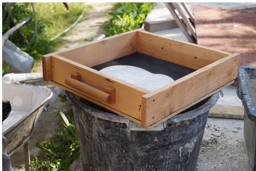
Obr. 95 Příprava nedvědického vápna hašeného v přebytku vody na bianco.
