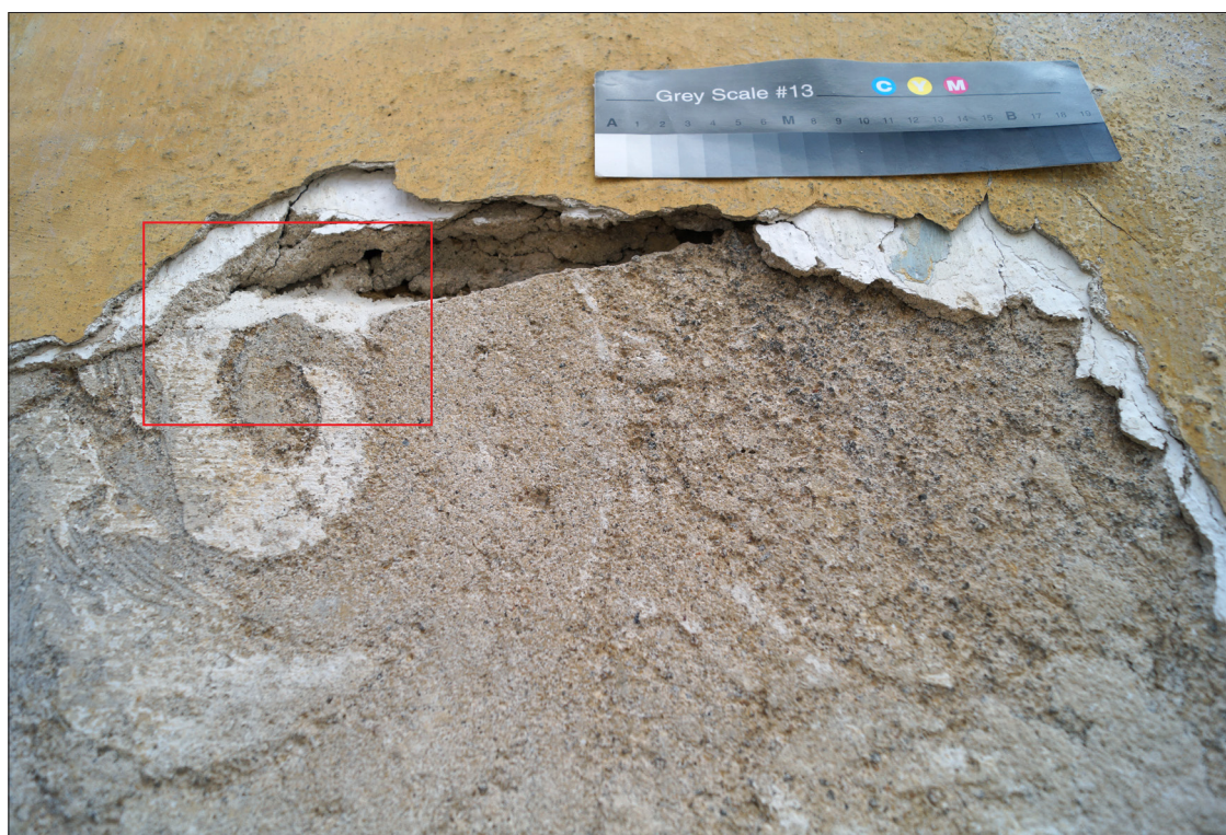
Obr. 110 Původní povrch sgrafita, překryvné omítky a nátěry; v rámečku provizorní tmel ze zajištění po odkryvu (Václav Špale).
