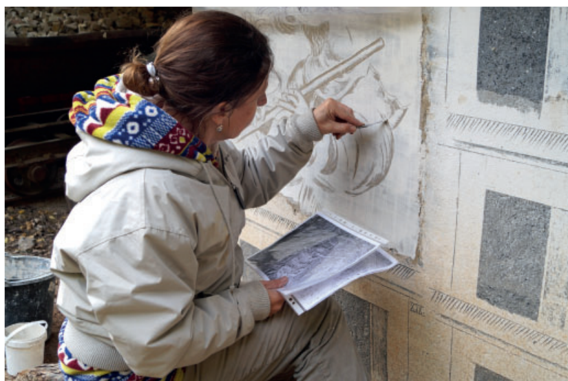
Obr. 22 Postup stínování prokletováním – odebrání svrchního nátěru po nanesení základního rozvrhu sgrafita.
