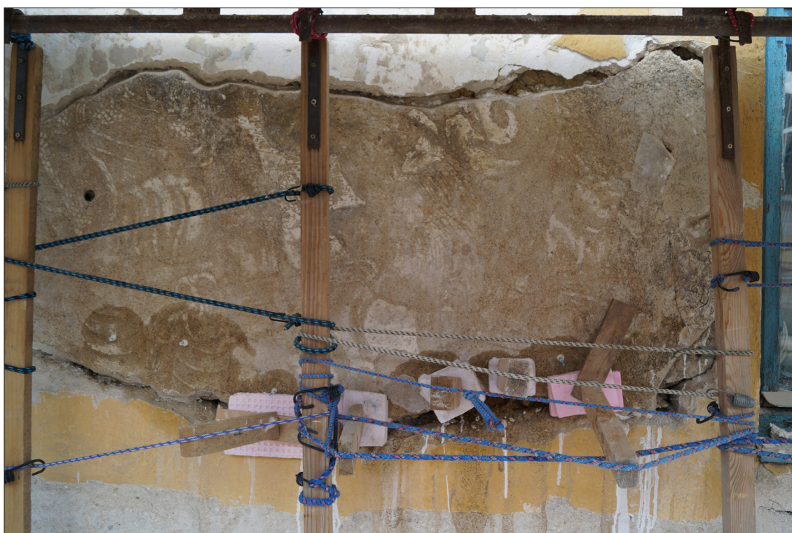
Obr. 123 Výjev s praporečnickem – postupné zajišťování přitlačnými konstrukcemi odspoda.
