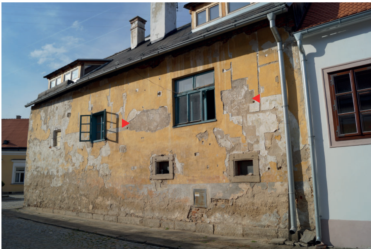
Obr. 3 Slavonice, dům čp. 545, celkový pohled na dům před započítím restaurátorských prací (šipky označují fragmenty původních sgrafit).
