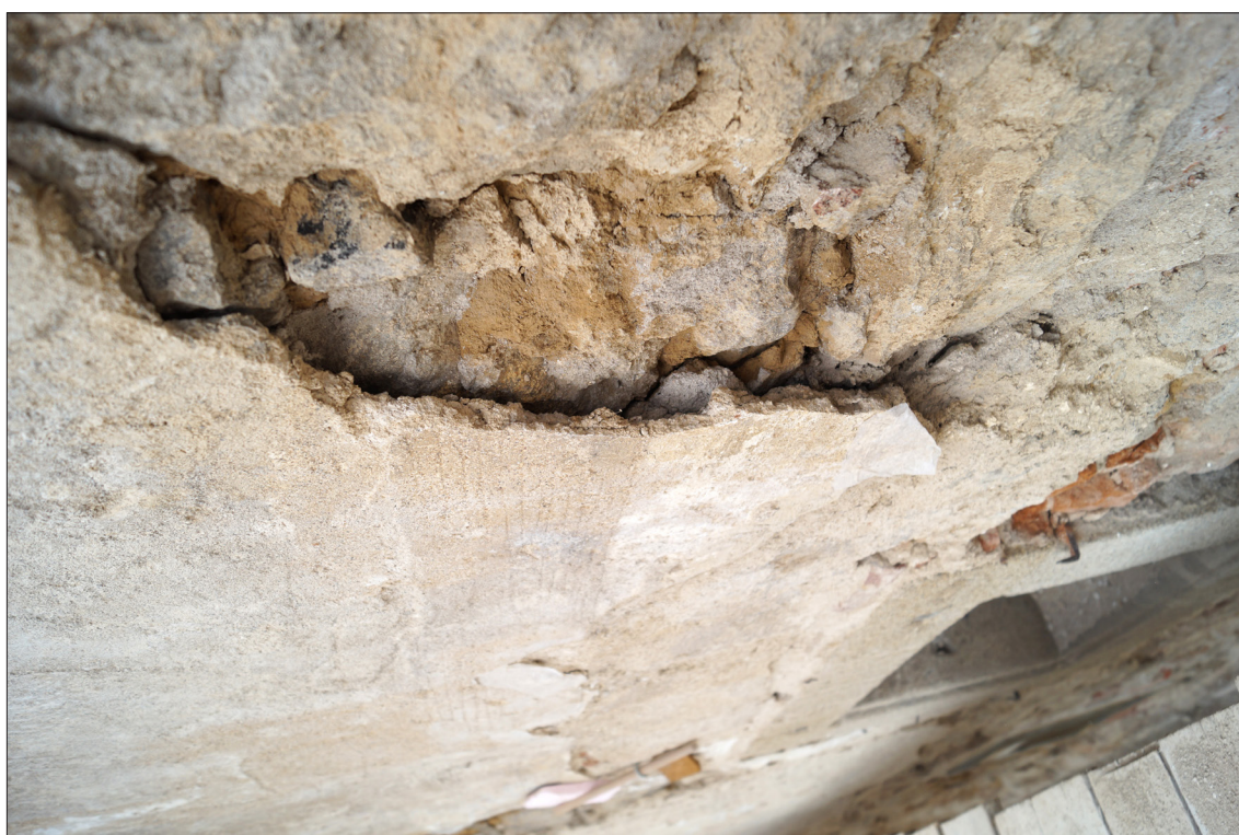
Obr. 120 Příprava na injektáž – obnažení okrajů, vyfoukání okraj části naprosto oddělené od zdi.
