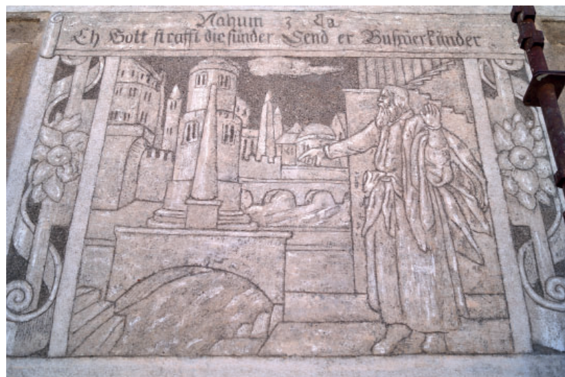
Obr. 40 Slavonice, Horní nám., dům čp 537. Detail fasády s prorokem Nahumem, tento výjev se jako jeden z mála dochoval v téměř kompaktní původní omítce.
