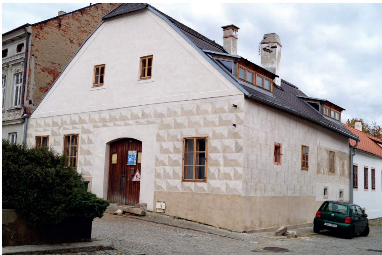
Obr. 2 Slavonice, dům čp. 545, celkový pohled na dům po restaurování.
