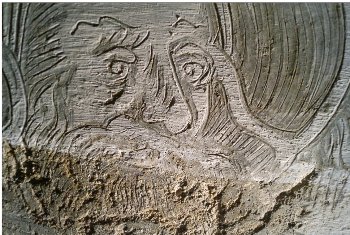
Obr. 170 Detail návaznosti na původní povrchy.
