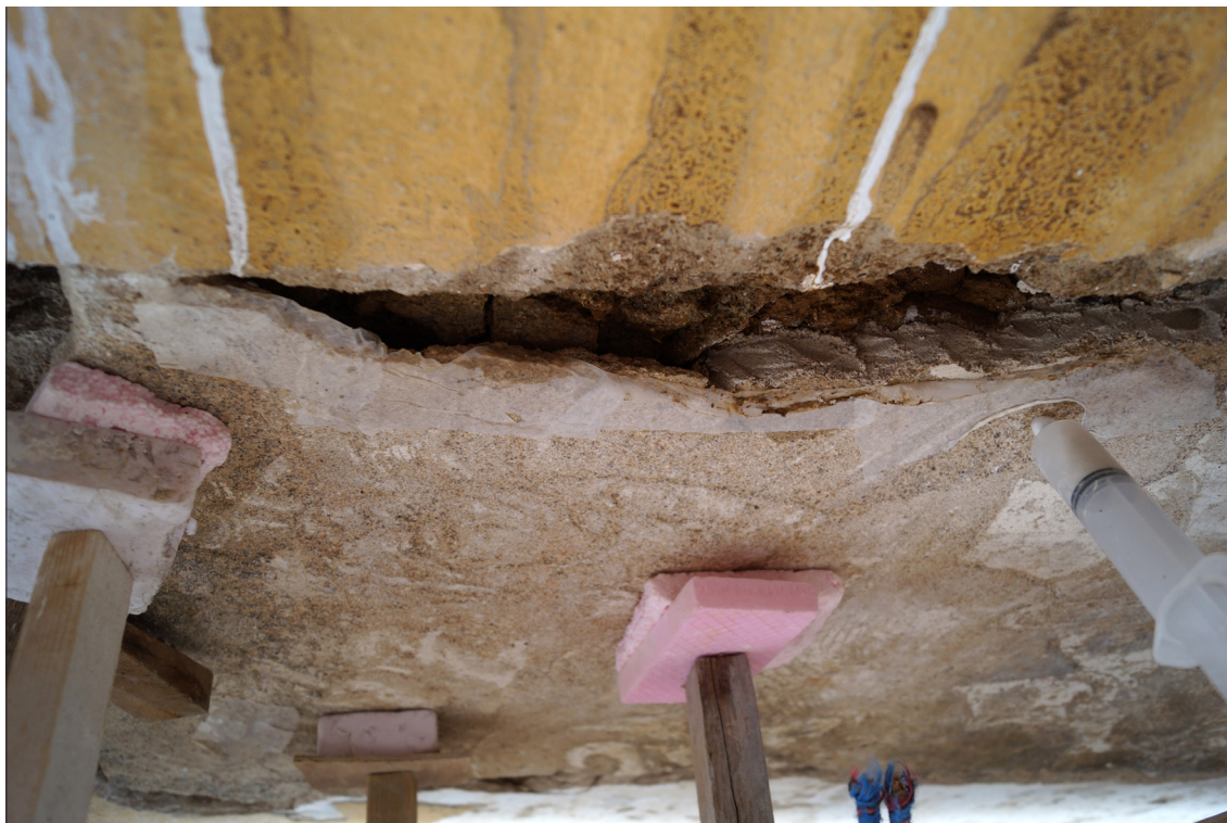
Obr. 119 Příprava na injektáž – obnažení okrajů, aplikace vápenné nanosuspensie CaloSil do navrtaných děr (zpevnění jádra), obtmelení.
