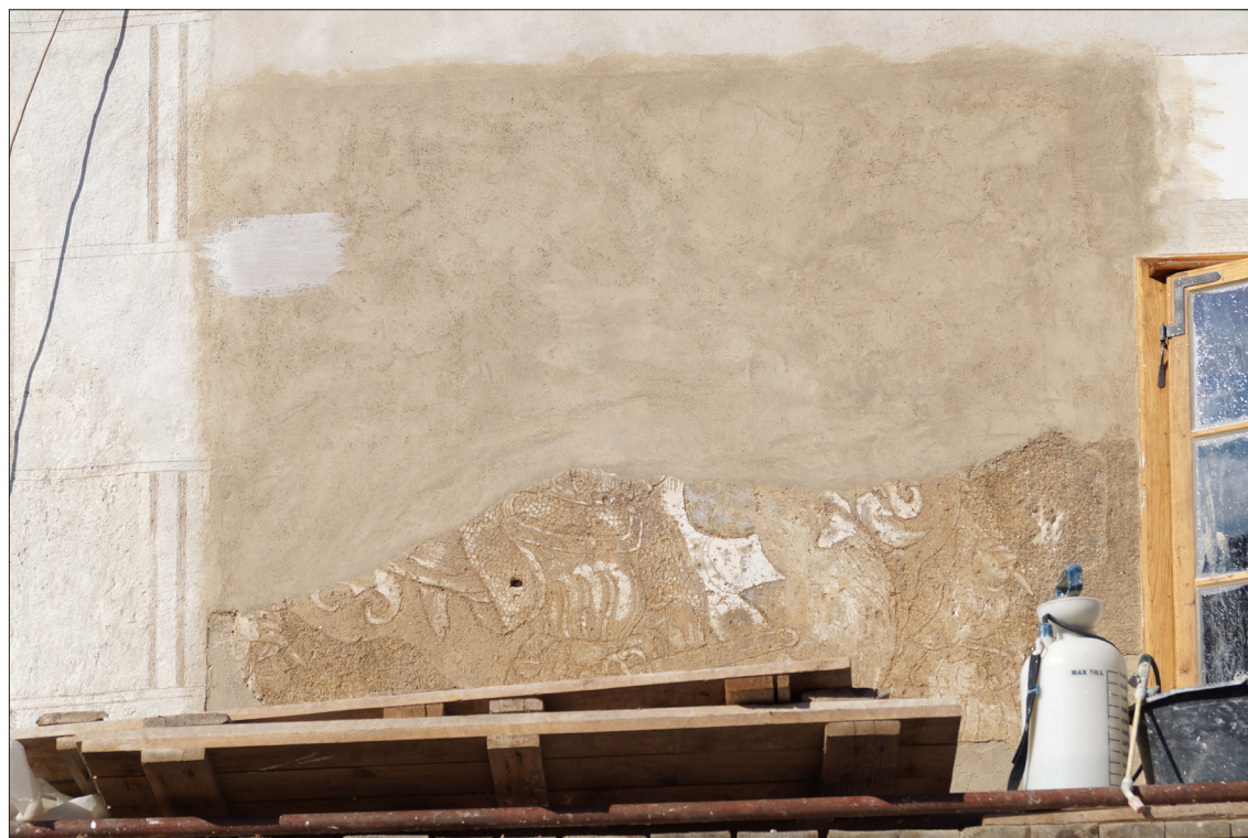
Obr. 160 Druhá vrstva barevného intonaca, celková tloušťka max. 0,5 cm.
