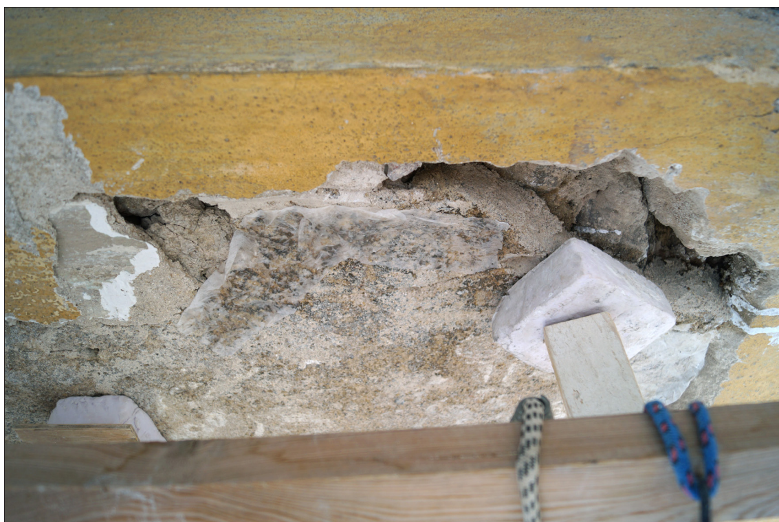
Obr. 114 Průběh odkryvu, zajištění okrajů tlakovací příchytanou konstrukcí a přelepý japonským papírem a Klucelem, výjev vlevo – praporečník.
