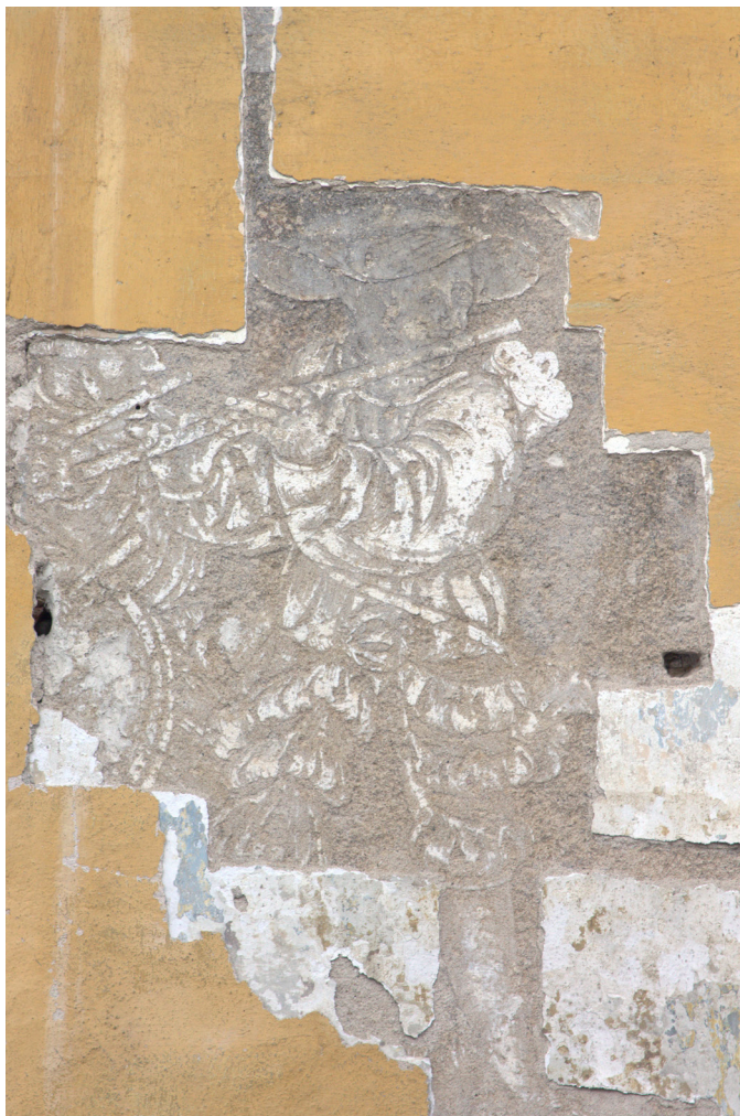
Obr. 108 Detail flétnisty, obličej ztmavlý vlivem sulfatizace.
