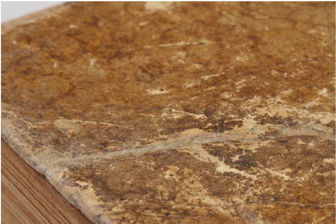
Obr. 374 Detail na pokryv po reštaurovaní.
