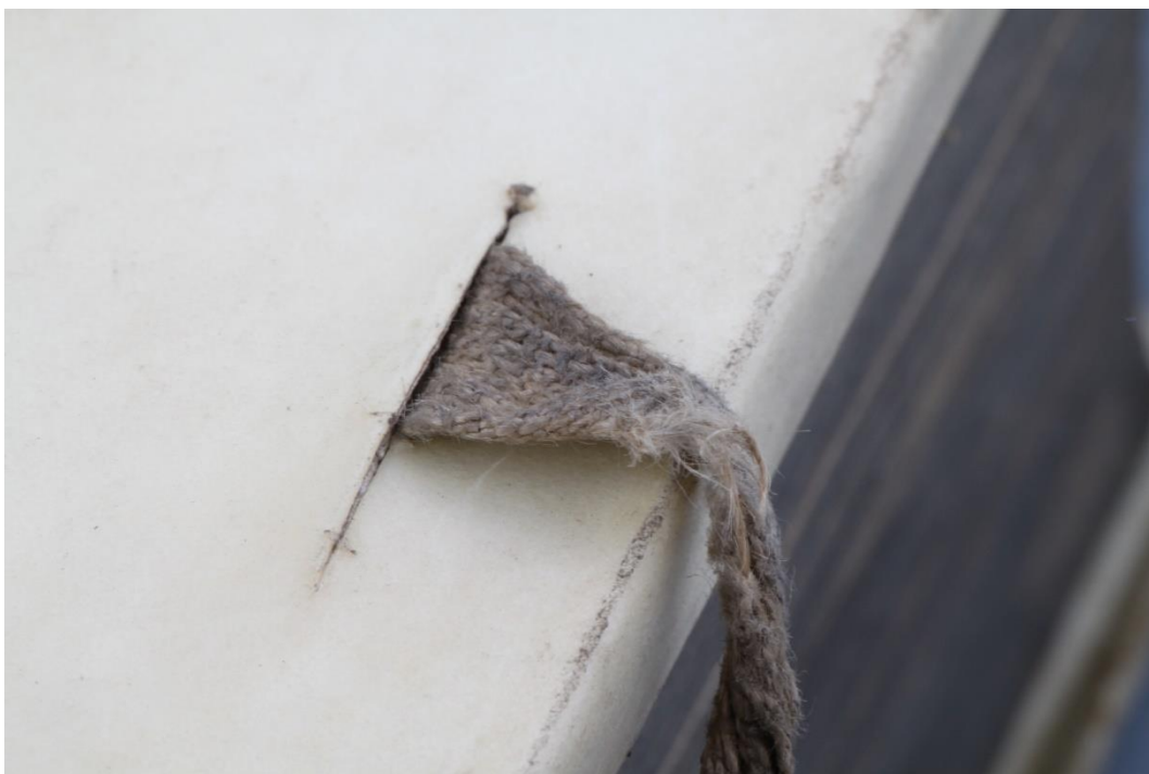
Obr. 336 Detail na prevlečenú tkanicu skrz dosku.
