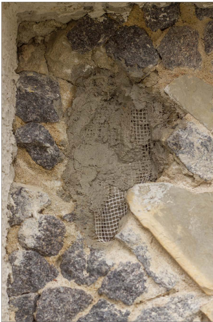
Obr. 88: Kamenná mozaika Ptačí rodina – detail malty zpevněné armovací mřížkou v horní levé části mozaikového výjevu.
