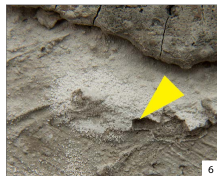
Obr. 80: Kamenná mozaika Ptačí rodina – přehled poškození a doplňkových či tvůrčích zásahů autorky: 1 – poškození až ztráta opukových kamenů, 2 – zvětvávání opukových kamenů osazených na kolmo k loži, 3 – trhliny v osazovací maltě mozaiky, 4 – první menšinová cementová malta (teplá šedá), 5 – druhá menšinová jemnozrnná cementová malta (studená šedá), 6 – bílý zákal na odhalené menšinové osazovací maltě, 7 – světle okrový polymerní materiál strukturálně pojící od lupující se opuku.
