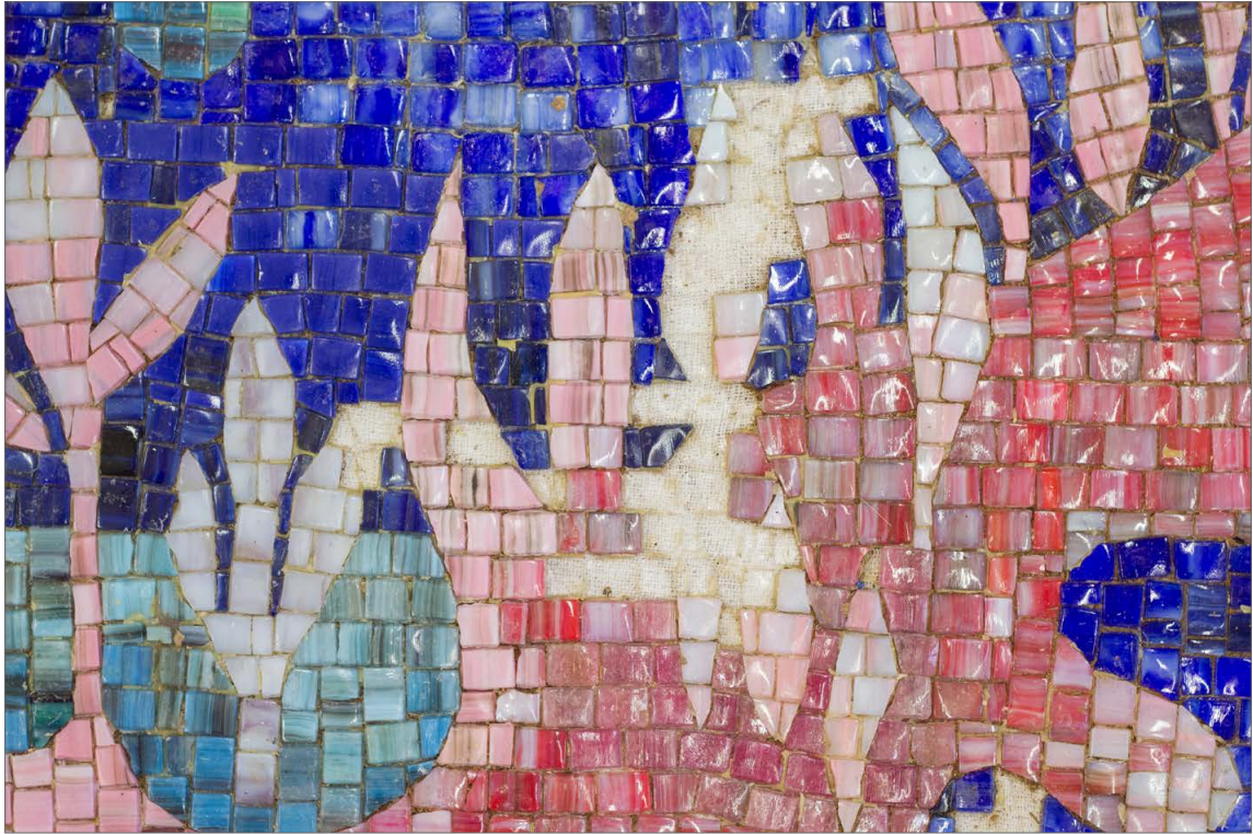
Obr. 59: Skleněná mozaika s motivem racka – detail místa s kostkami uvolněnými během mechanického odstraňování epoxidové pryskyřice (rubová strana).
