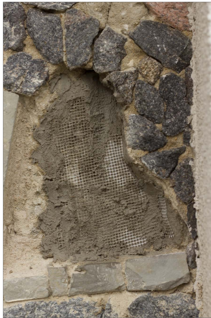
Obr. 89: Kamenná mozaika Ptačí rodina – detail malty zpevněné armovací mřížkou ve střední pravé části mozaikového výjevu.
