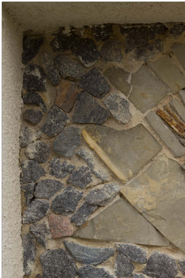
Obr. 90: Kamenná mozaika Ptačí rodina – detail po osazení mozaikových kamenů v místě obnažené ocelové armatury v horní levé části mozaikového výjevu.
