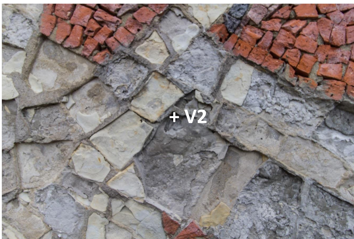
Obr. 73 Místo vrtu V2 ve výšce 82 cm; stanovení obsahu vodorozpustných solí (V2A, V2B, V2C).
