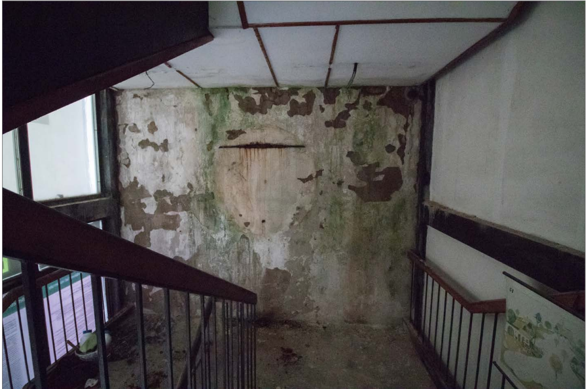
Obr. 53: Skleněná mozaika s motivem racka – celkový pohled na mezipatro schodišťové haly, kde byla mozaika původně umístěna.
