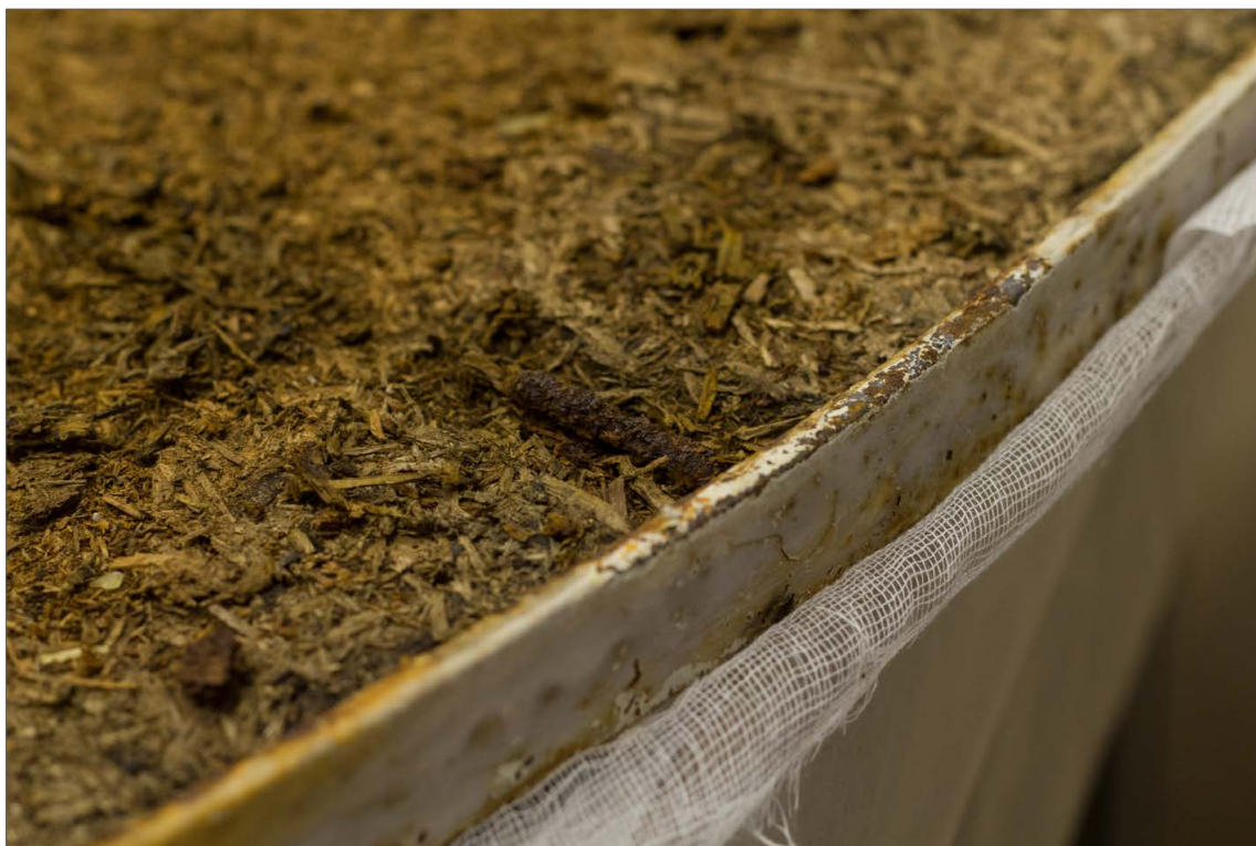
Obr. 58: Skleněná mozaika s motivem racka – detail mozaiky v průběhu odstraňování dřevotřískové desky – viditelný zkorodovaný vrut upevňující ocelový rám.
