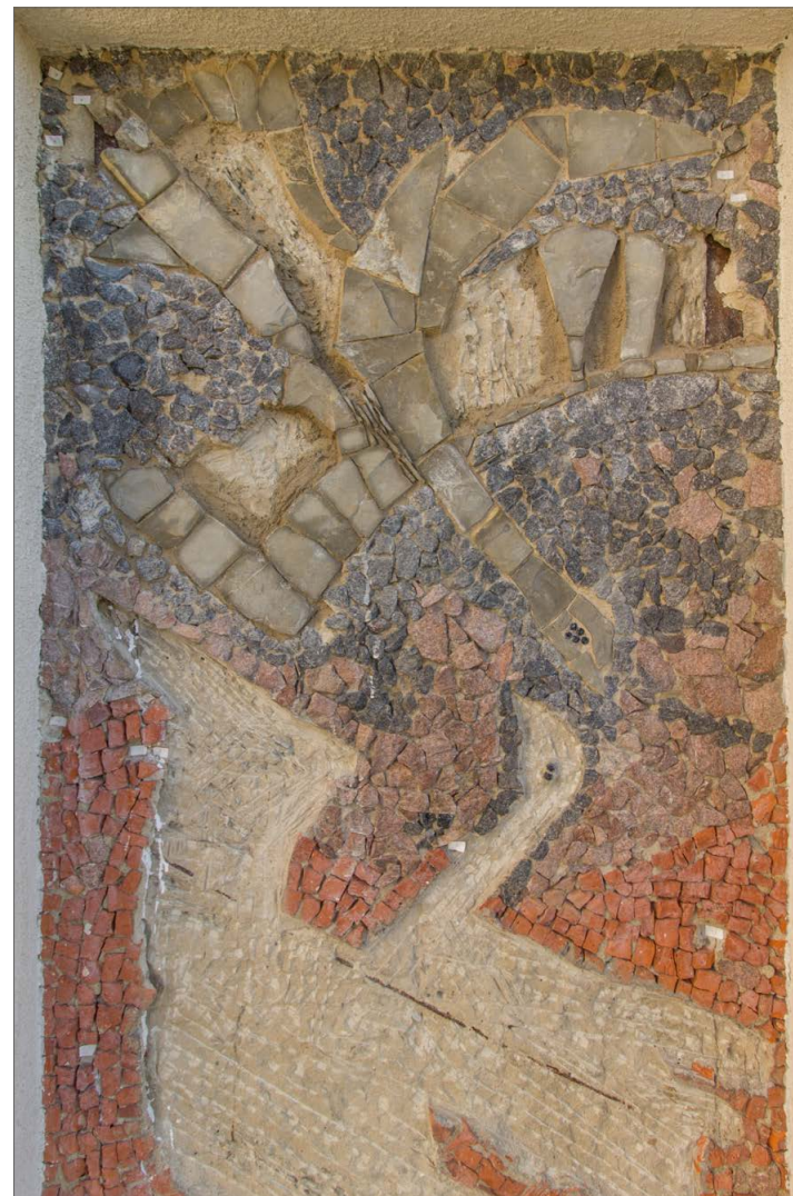
Obr. 85: Kamenná mozaika Ptačí rodina – průběh osazování opukových kamenů do nového maltového lože.
