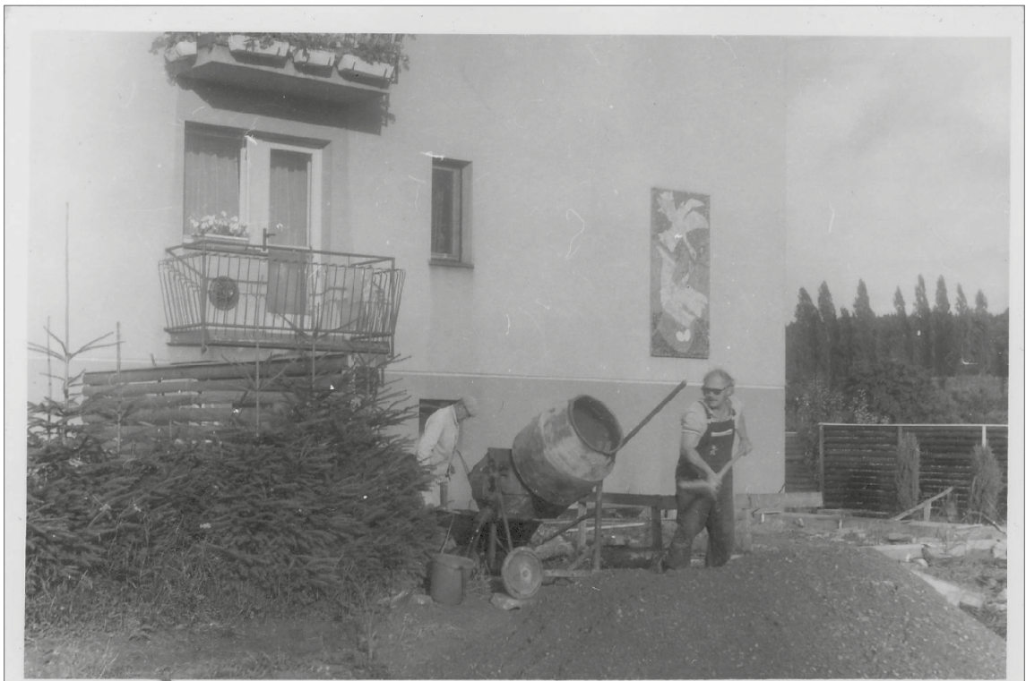
Obr. 100: Historická fotografie dokumentující pravděpodobně stavební úpravy na zahradě, v pozadí osazená mozaika s motivem Ptačí rodina [BRÝDL, Miroslav. Osobní archiv].
