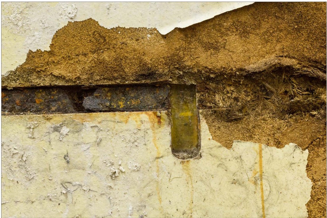
Obr. 54: Skleněná mozaika s motivem racka – detail zadní strany panelu – zbytky kovového zavěšovacího systému a degradovaná dřevotřísková deska.
