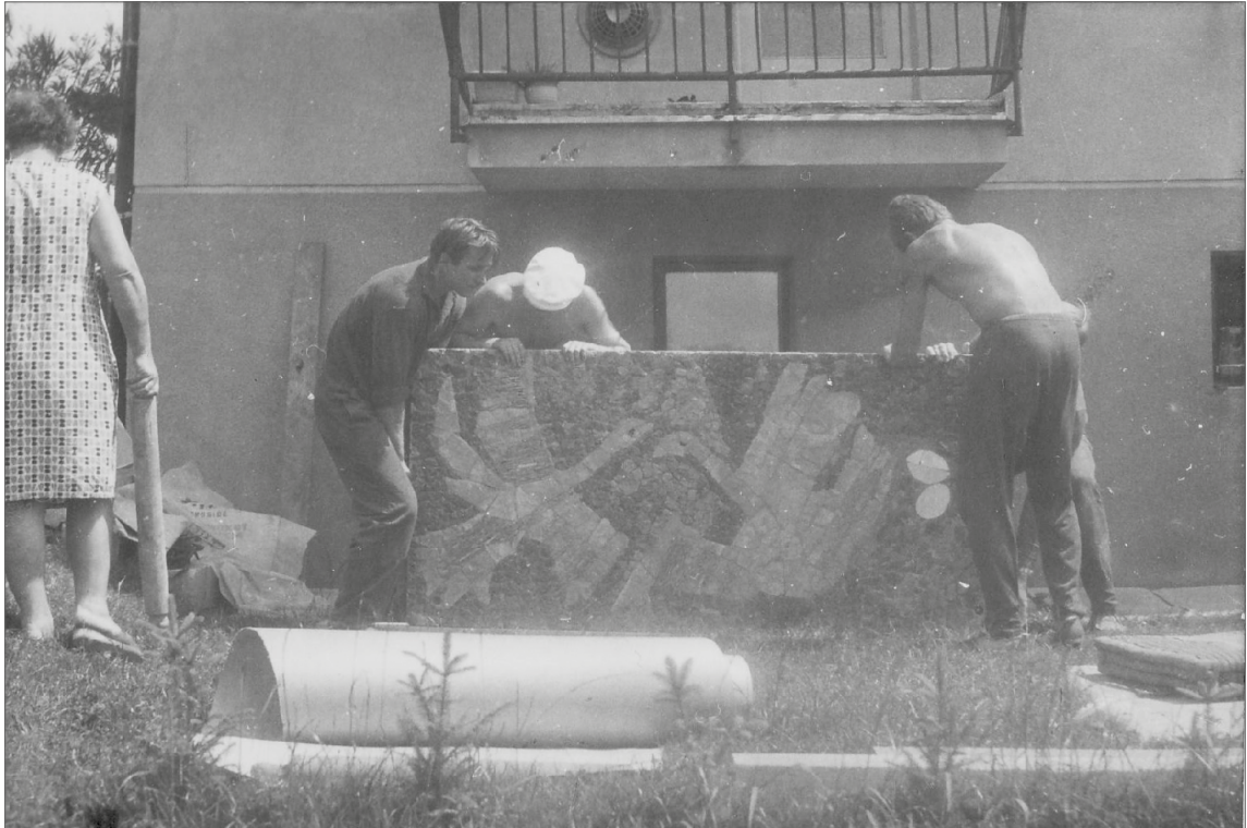
Obr. 99: Historická fotografie z prvního osazování mozaiky s motivem Ptačí rodina na západní fasádu činžovního domu [BRÝDL, Miroslav. Osobní archiv].
