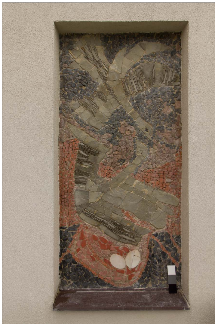
Obr. 92: Kamenná mozaika Ptačí rodina – celkový pohled na mozaikový výjev po doplnění všech mozaikových kamenů.
