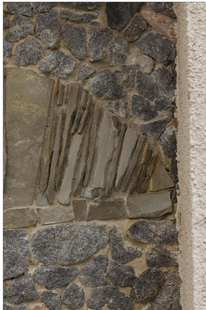
Obr. 91: Kamenná mozaika Ptačí rodina – detail po osazení mozaikových kamenů v místě obnažené ocelové armatury ve střední pravé části mozaikového výjevu.
