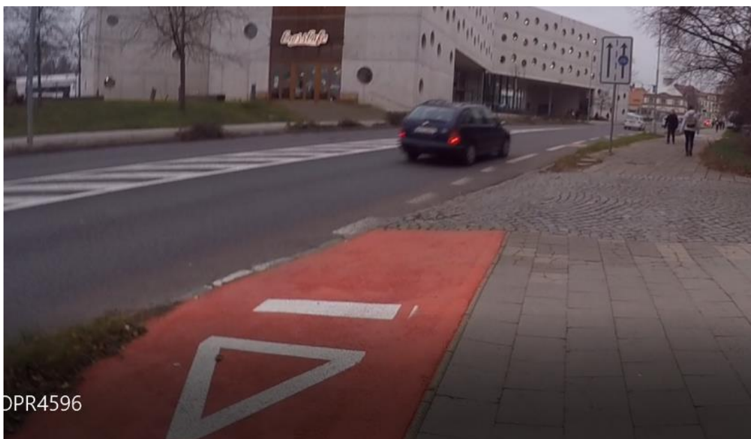
Obrázek 35 Ukončení cyklostezky v ulici Hradecká
