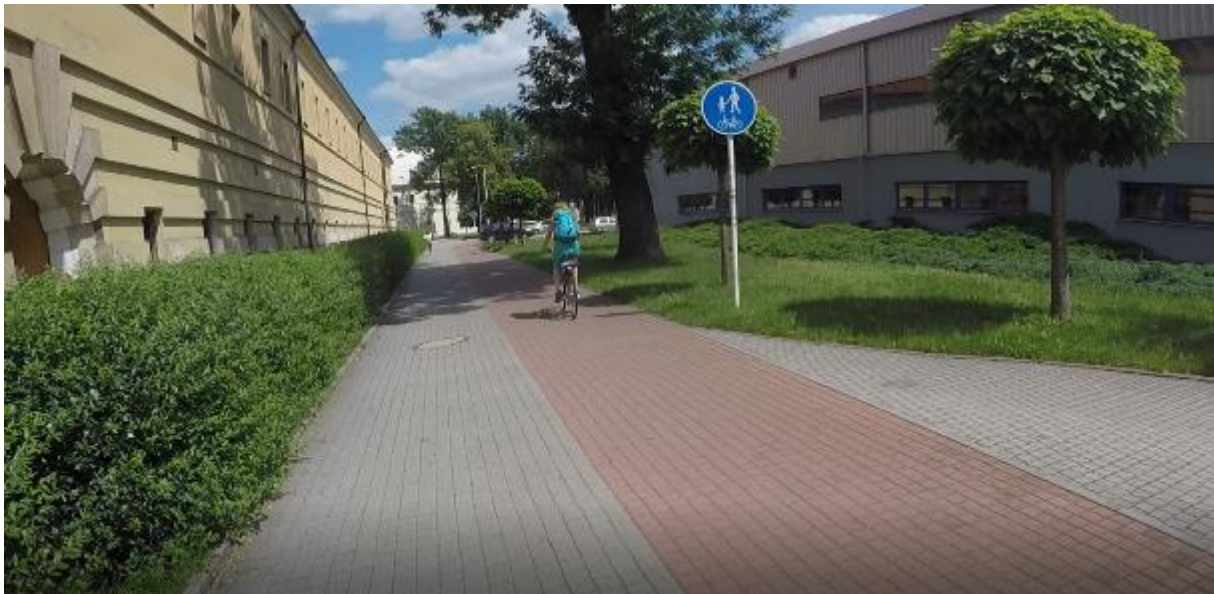
Obrázek 31 Svislé značení neodpovídající značení vodorovnému 2
