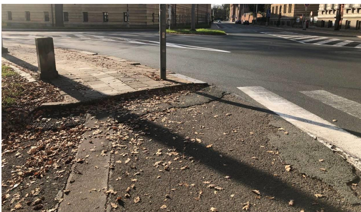
Obrázek 26 Nesnížená chodníková hrana na konci chodníku
