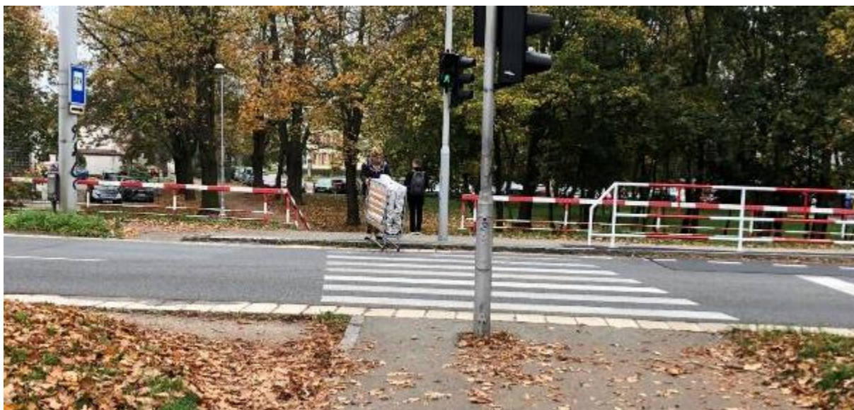
Obrázek 25 Nesnížená chodníková hrana na přechodu pro chodce
