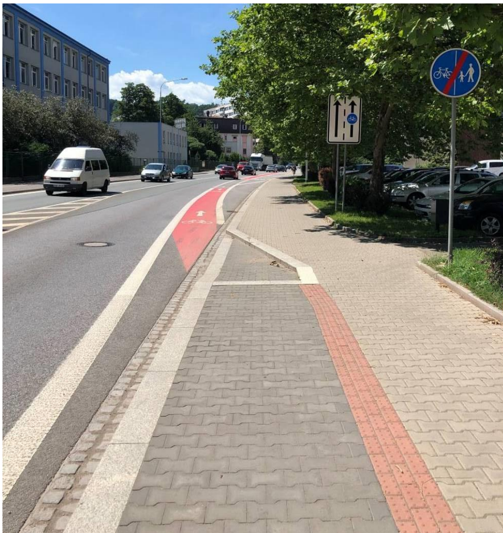
Obrázek 36 Příklad technického řešení sjezdu z přidruženého dopravního prostoru do hlavního prostoru
