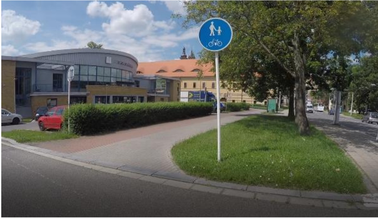
Obrázek 30 Svislé značení neodpovídající značení vodorovnému 1
