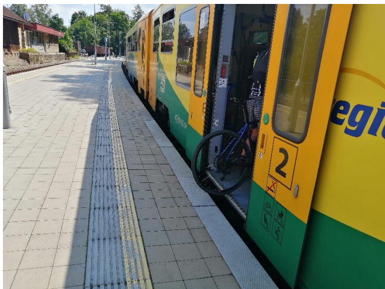
Obrázek 12: nástupištní hrana ve stanici Jílové u Prahy
