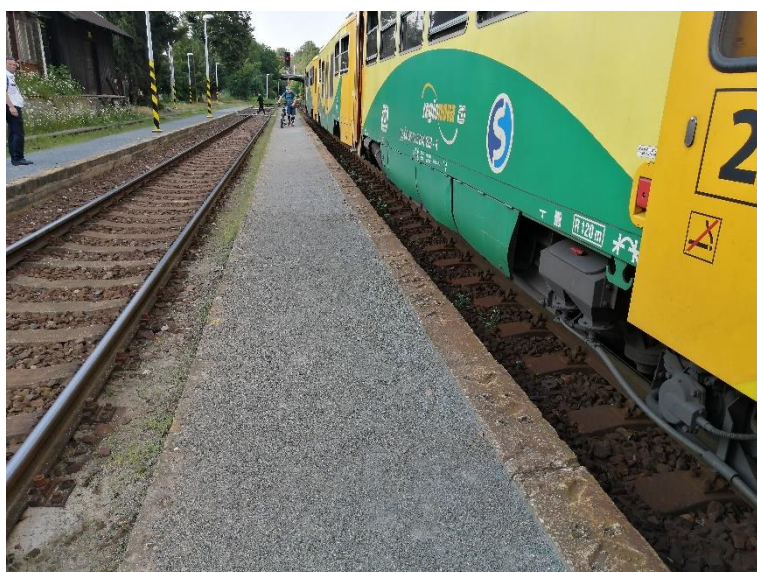
Obrázek 13: nástupištní hrana ve stanici Praha – Zbraslav
