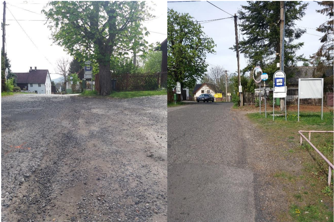
Obrázek H-1: Současný stav obou stanovišť zastávky Manušice
