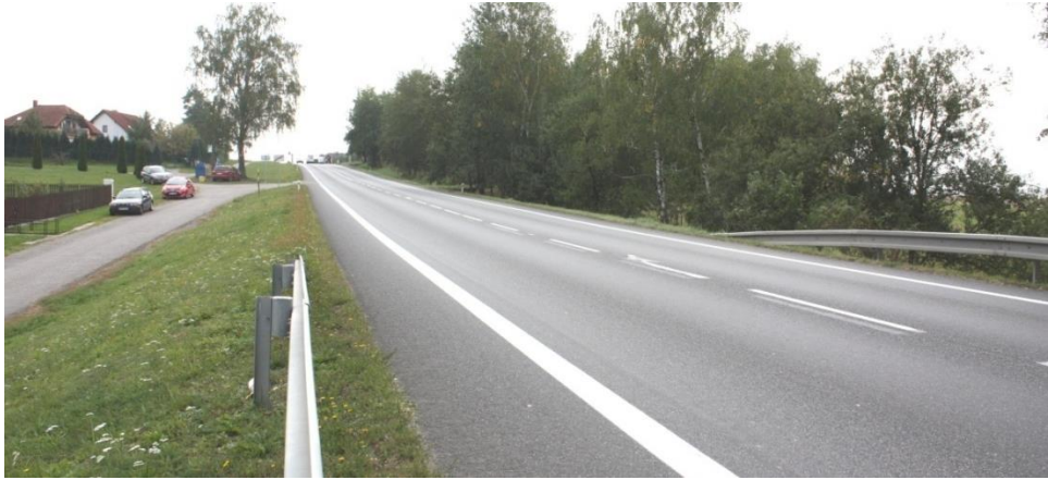
Obr. 23 Pohled na silnici I/38 ve směru na Havlíčkův Brod
