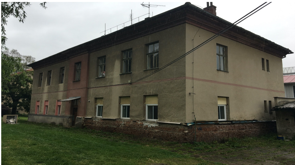
Obrázek 16 Bytový dům č.p. 150
