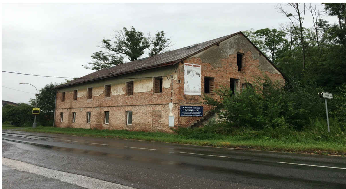
Obrázek 14 Budova bývalé mechanické tkalcovny
