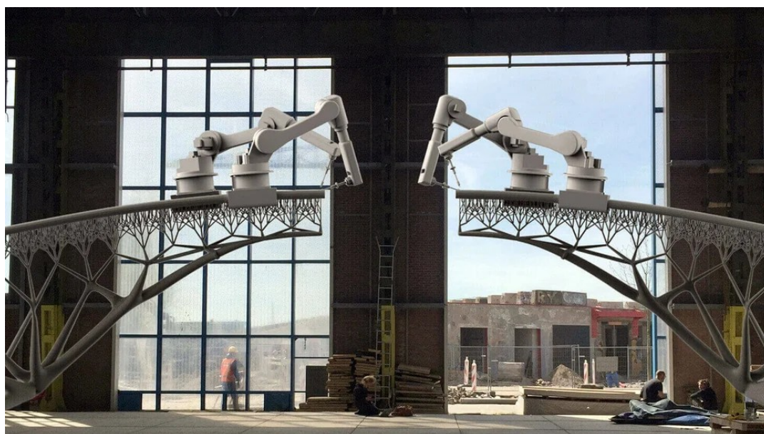
Obr. 11: Ocelový most zhotovený technologií aditivní výroby v roce 2015 v Nizozemí [26]
