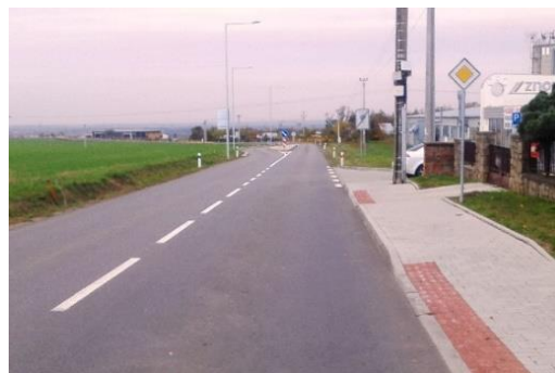
Obrázek 7 – Silnice II/408, intravilán Suchohrdly, km 70,541
