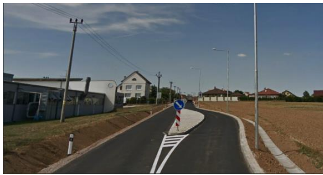
Obrázek 28 – Silnice II/408, vjezdová brána Zdroj: (8)
