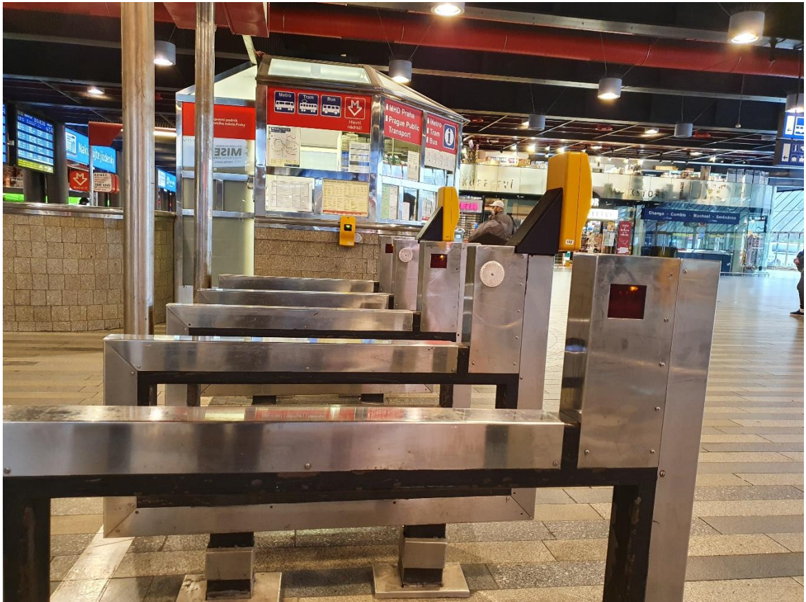
Obrázek 5 Sloupky u vstupů do metra pro počítání cestujících (Hlavní nádraží)
