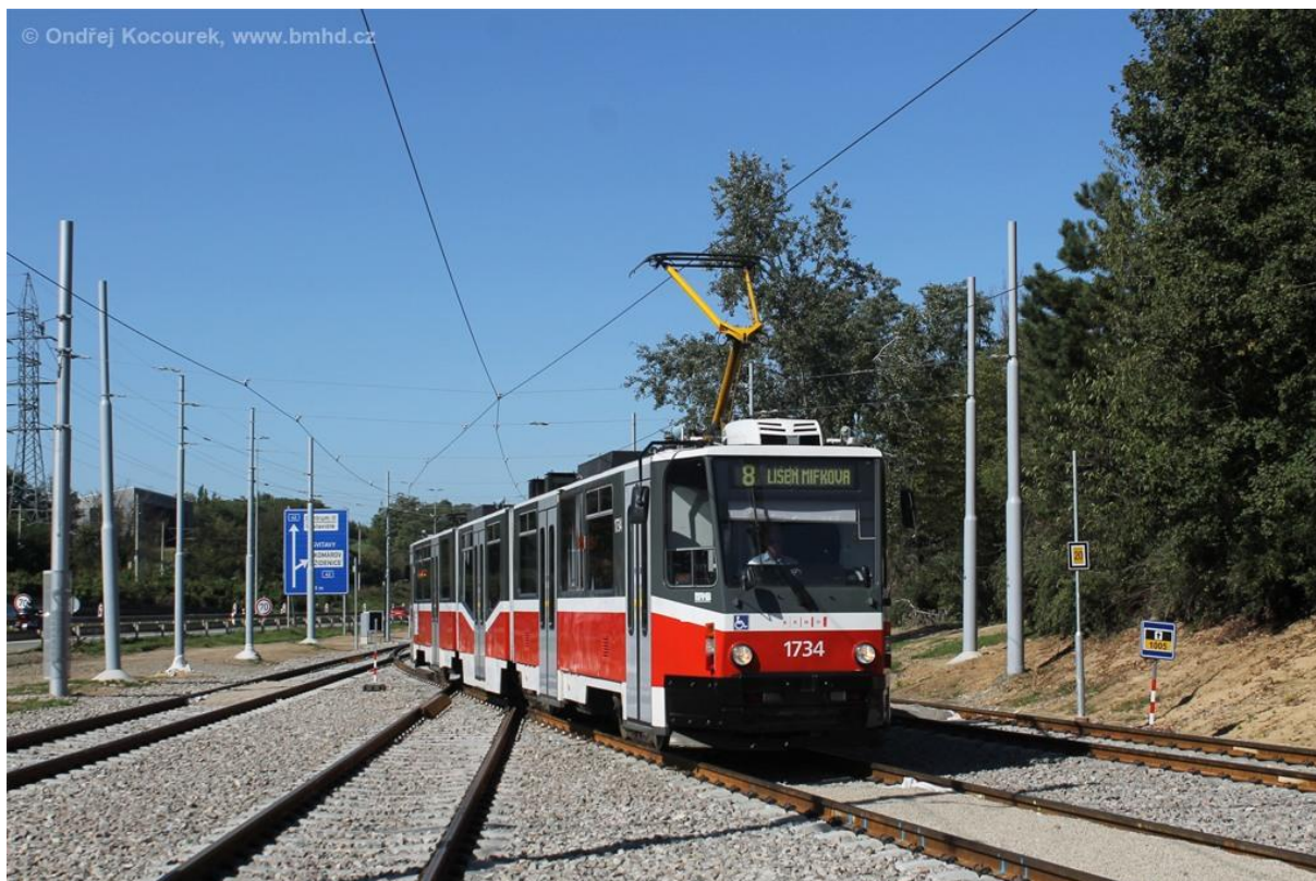
Obrázek 2: Tramvaj KT8D5N na lince 8 při průjezdu přes rychlostní výhybku na rozdělení tratí do Líšně a na Stránskou skálu Zdroj: Ondřej Kocourek, www.bmhd.cz
